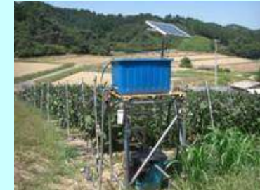
ソーラーパネルの電力を利用した自動かん水装置(県実証ほ)
