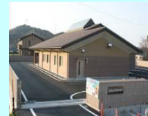
農業集落 排水施設
