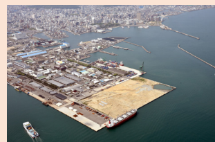
整備が進む高松港国際物流ターミナル
