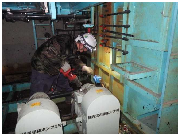
屋内設備撤去状況
