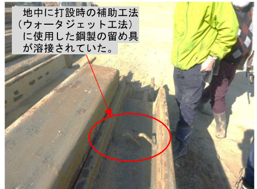
写真6 鋼矢板側面に溶接された鋼製の留め具
