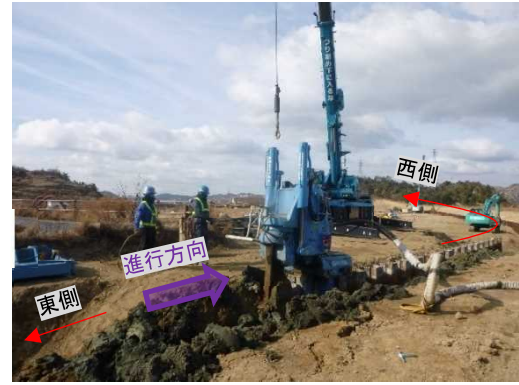
写真2 油圧圧入引抜機による引抜き状況
