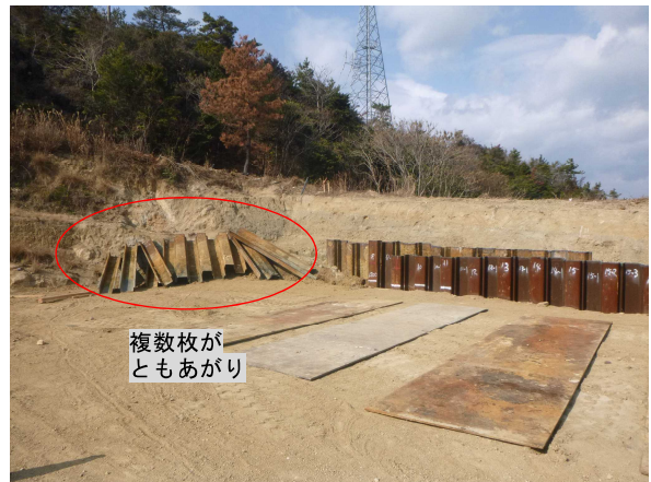
写真 24 西側端部の引抜き後の状況
