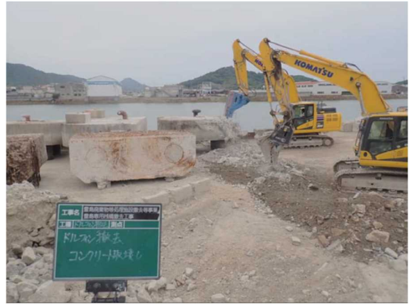
ドルフィン撤去 コンクリート破砕状況
