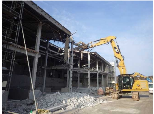
躯体外部解体状況
