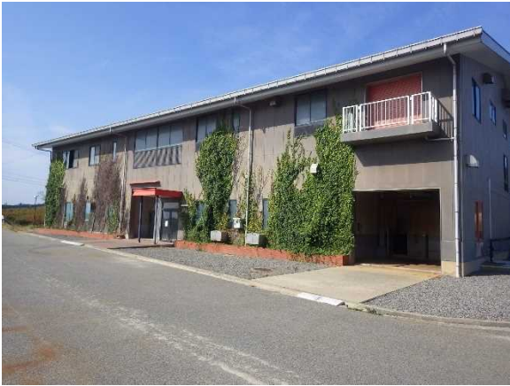
建屋解体前（東側から撮影）
