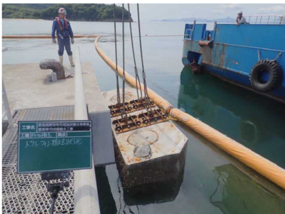
吊ピース設置状況
