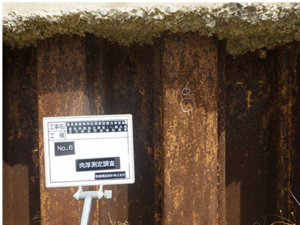
写真 1 肉厚測定箇所-研磨前 (No. 6)
