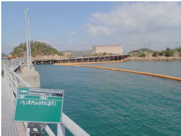
汚濁防止膜設置状況 (東側)
