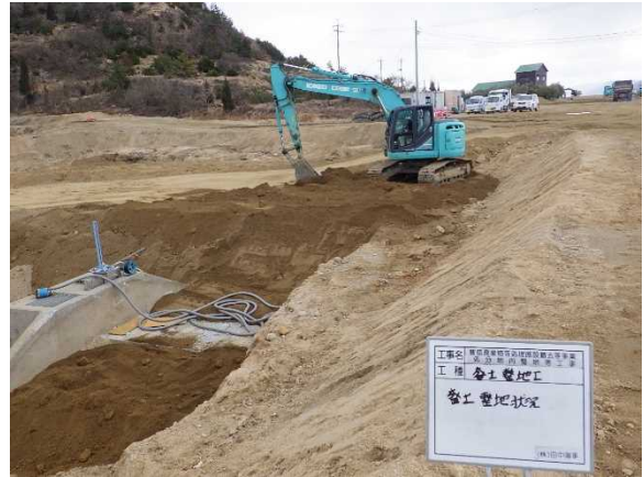
導水管呑口部付近の整地状況
