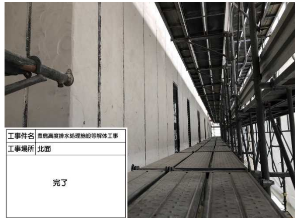
外壁完了状況
