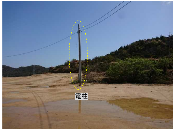
写真区-16 ⑥-6 電柱
