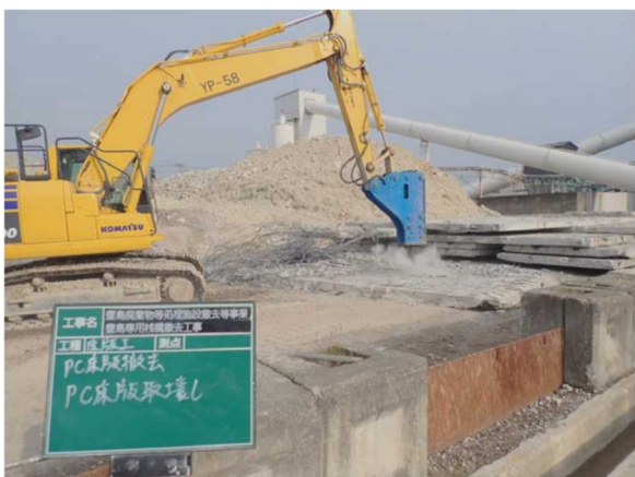
床版撤去 コンクリート破碎状況
