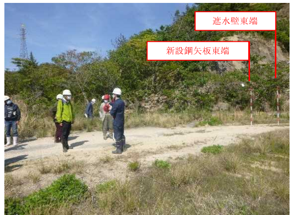
写真12 遮水壁東端部
