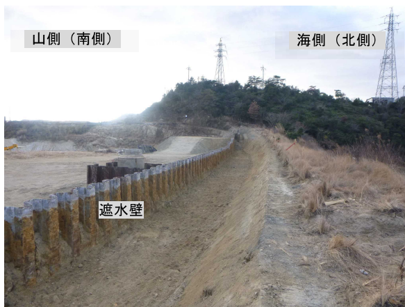
写真 19 背面土砂掘削後（中央から西向き）
