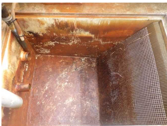
洗浄後 写真1 沈砂槽
