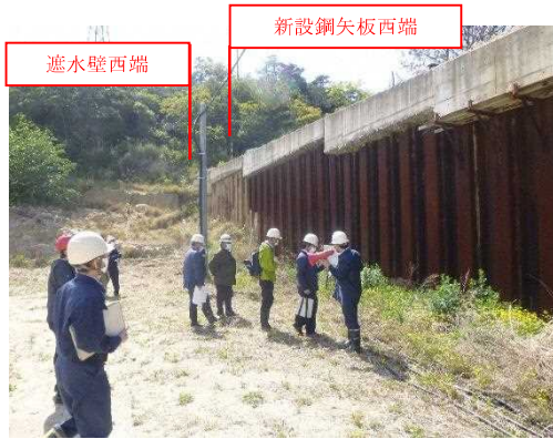
写真3 遮水壁西端部
