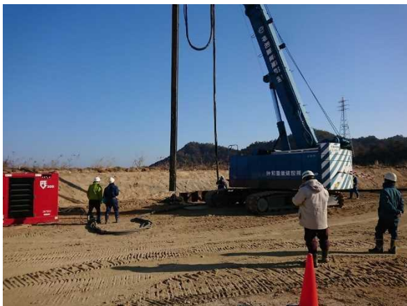
写真 37 松島委員立会状況（引抜き状況の確認）
