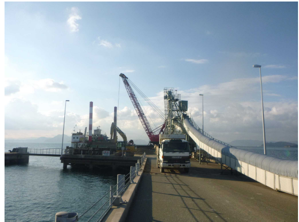
写真 22 トレンチドレーンの搬出状況
