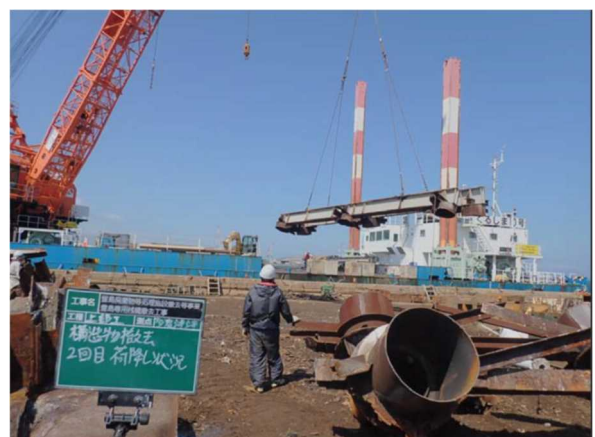
栈橋上部鋼材撤去 荷下し
