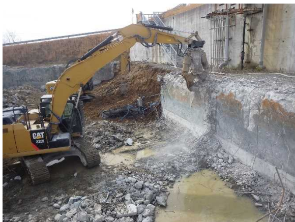
水槽部外部壁解体状況
