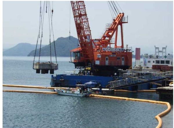
ドルフィン撤去状況
