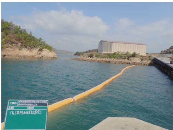
汚濁防止膜設置状況 (西側)
