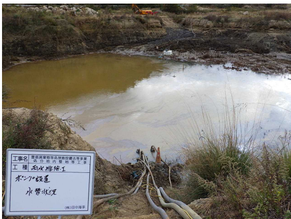
水替え状況（区画⑨）
