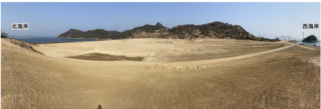
写真VI-4 処分地の整地関連工事後の状況（西側から広角撮影）
