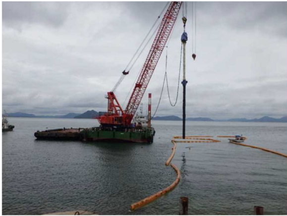
鋼管杭積込状況
