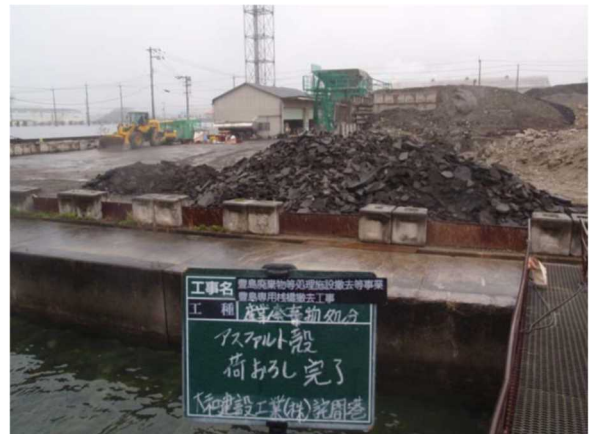
床版撤去 アスファルト塊荷下し後
