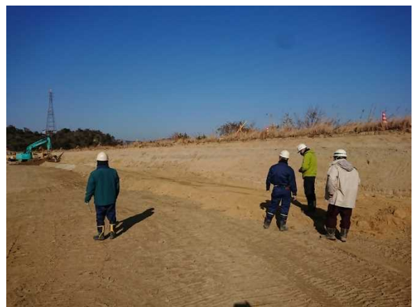
写真IV-12 引抜き後の締め固め状況の確認
