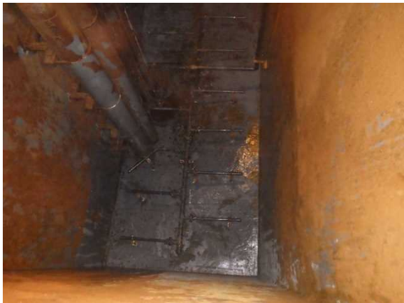
洗浄後 写真5 ばっ気槽
