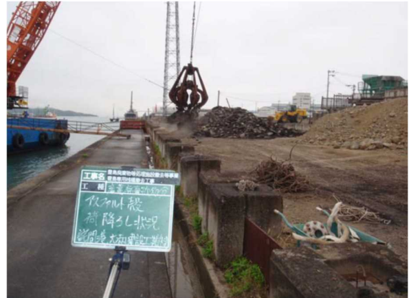
床版撤去 アスファルト塊荷下し
