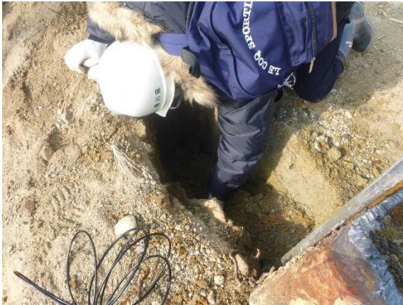
写真IV-7 引抜き跡の確認
