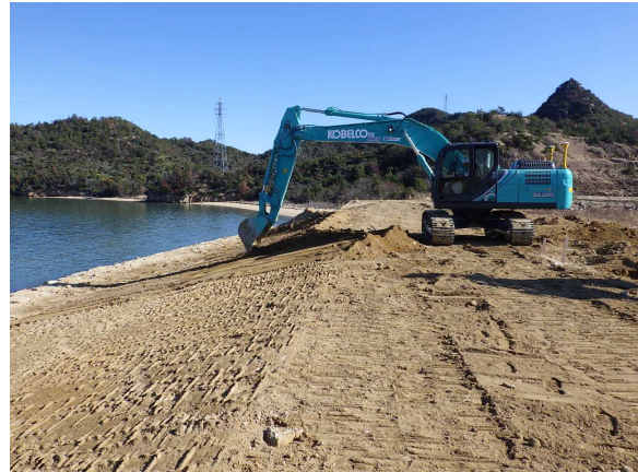
北海岸土堰堤付近の整地・整形状況
