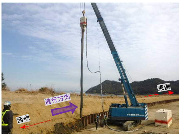
写真 25 バイブロハンマによる引抜き状況 1
