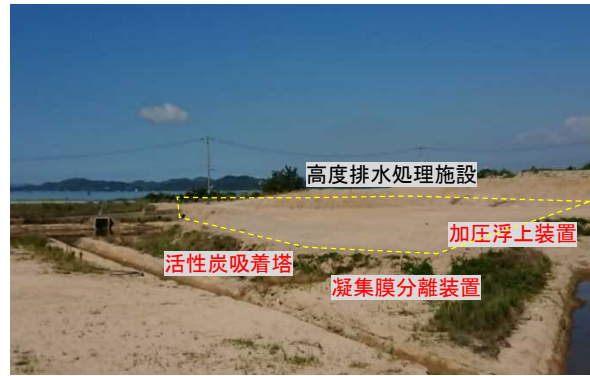
写真Ⅲ-6 簡易地下水処理施設 解体・撤去後
