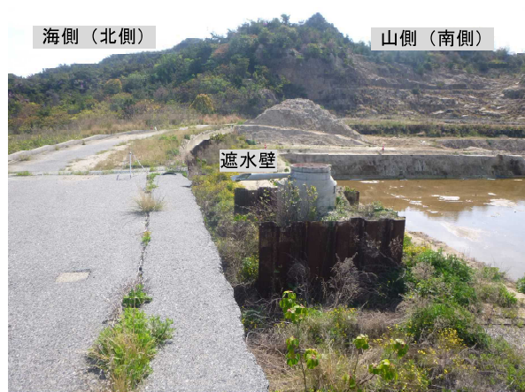
写真4 遮水壁上部（中央から東向き）
