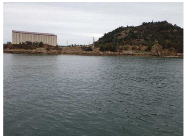
写真V-4 栈橋撤去後（海側から撮影）
