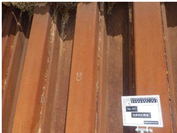
写真 5 肉厚測定箇所-研磨前 (No. 42)
