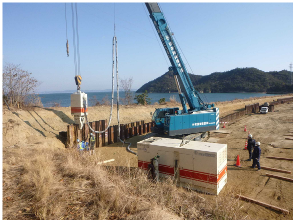
写真 23 鋼矢板の引抜き開始（西側端部から）
