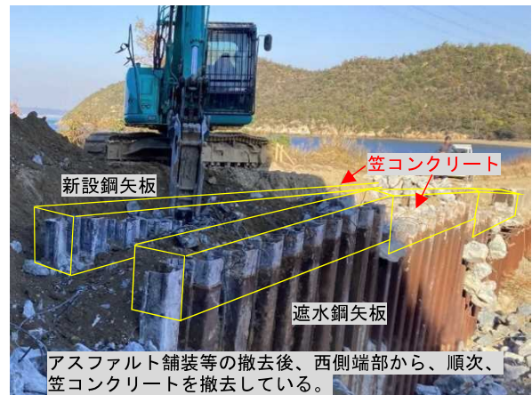
写真 18 笠コンクリートの撤去状況
