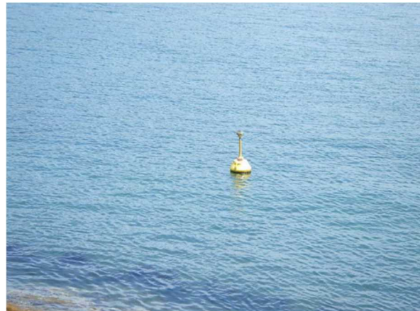
灯浮標設置状況 (近景)
