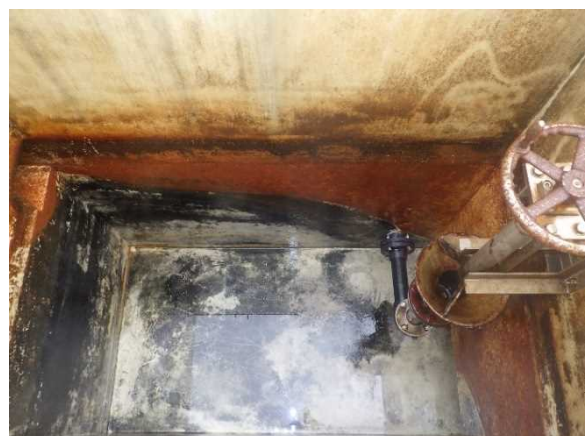
洗浄後 写真2 油水分離槽
