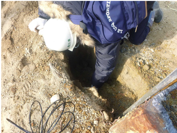
写真 33 松島委員立会状況（引抜き跡の確認）
