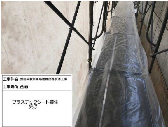
外壁シート養生状況
