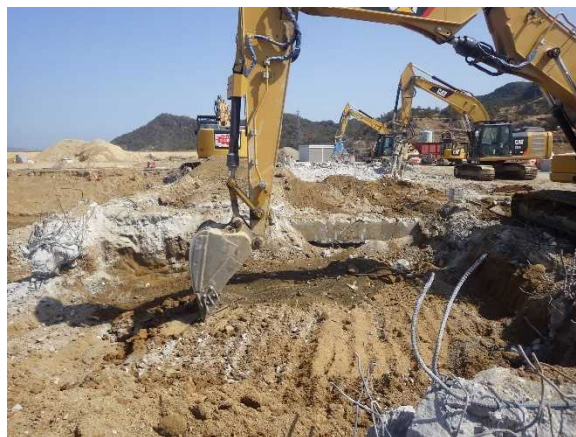
基礎・地中梁解体状況
