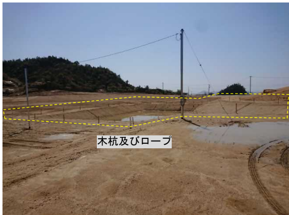
写真区-17 浸透池 (木杭及びロープの設置状況)
