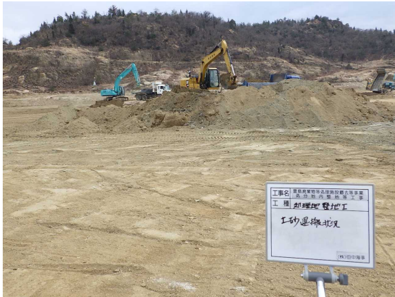
処分地内土砂の積込み・運搬状況（その1）
