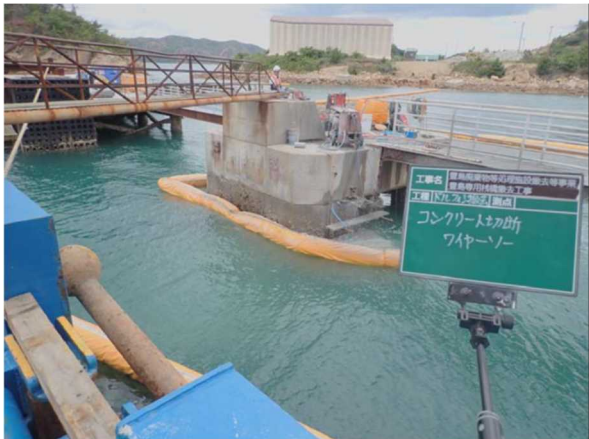
コンクリート切断状況 (ワイヤーソーイング)
