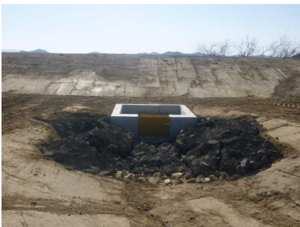
写真VI-5 導水管呑口部の改修後の状況
