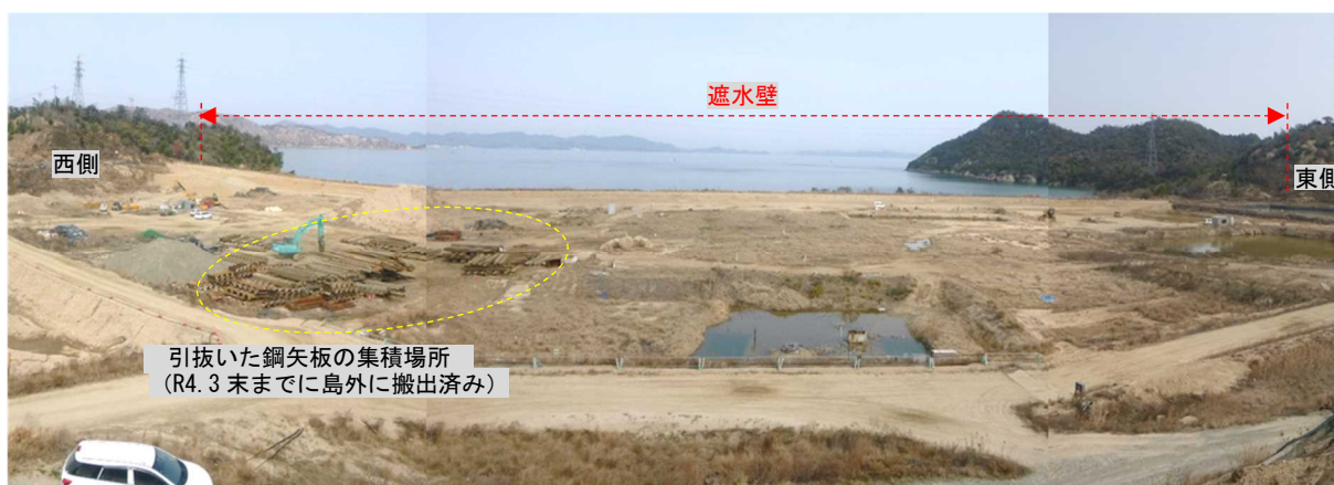
写真IV-2 引抜き後の処分地内の状況 (令和4年3月17日)
