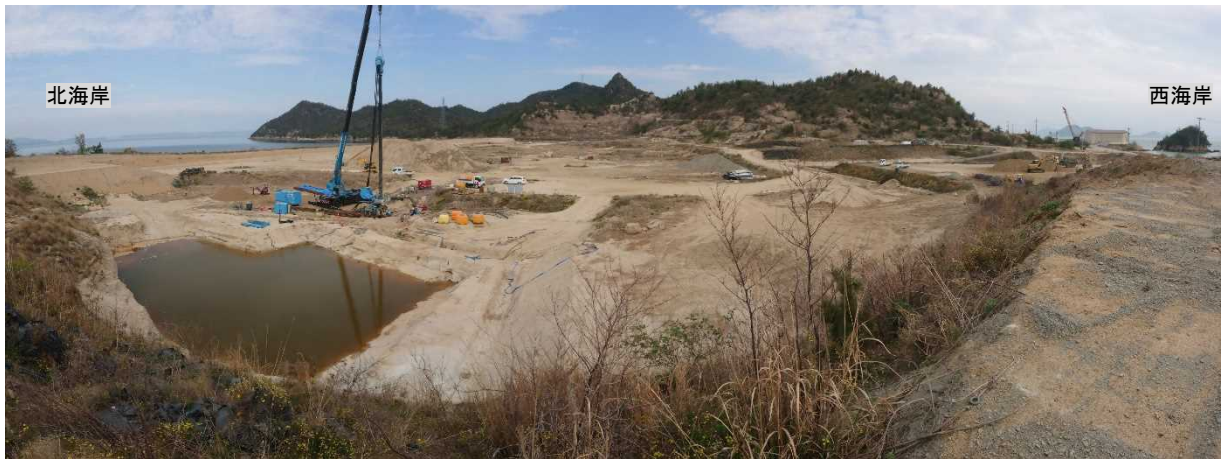
写真VI-3 処分地の整地関連工事前の状況（西側から広角撮影）
