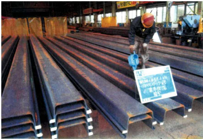
鋼矢板への止水材塗布状況【H27北海道トレンチドレーン撤去及び仮設矢板設置工事（第1工区）】
