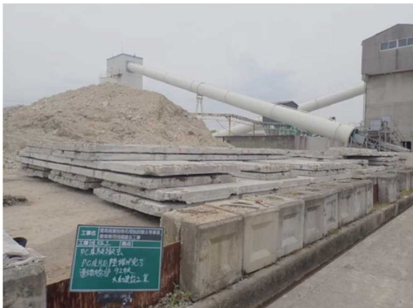
床版撤去 荷下し後
