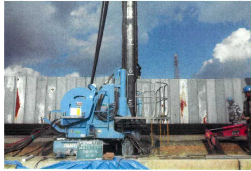
クラッシュパイラーによる圧入状況【H27北海道トレンチドレーン撤去及び仮設矢板設置工事（第1工区）】
