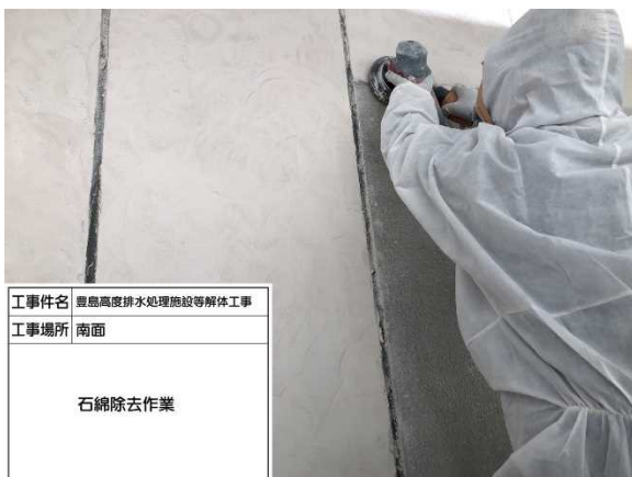
外壁のケレン状況
