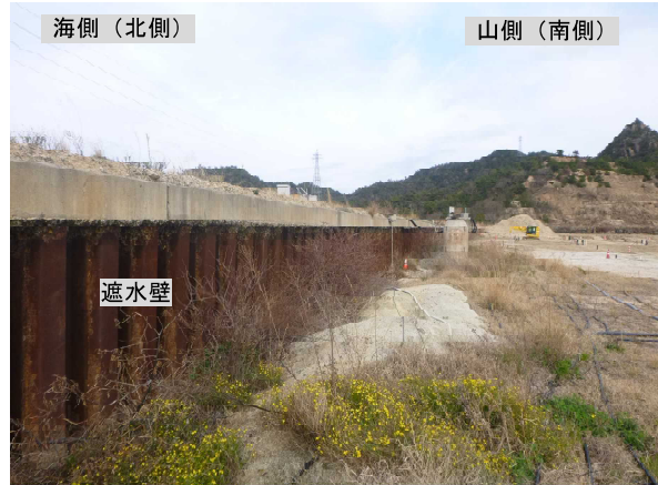
写真6 遮水壁処分地側（中央から東向き）
