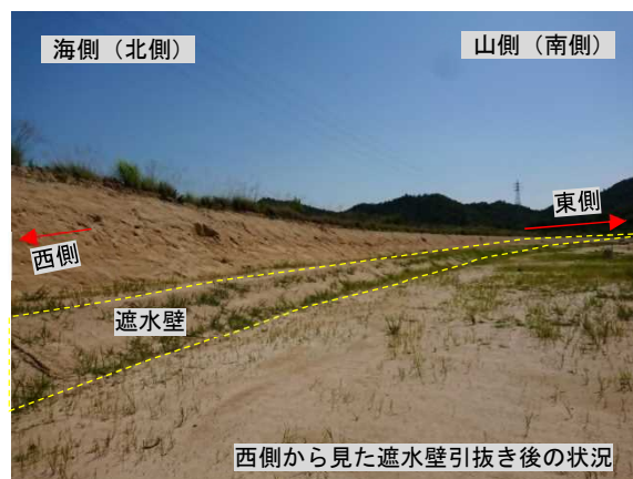
写真IV-5 遮水壁撤去後（処分地側（東向き））
