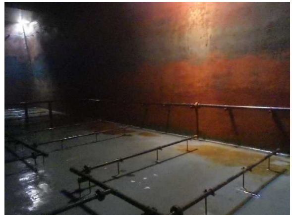
洗浄後 写真6 貯留槽
