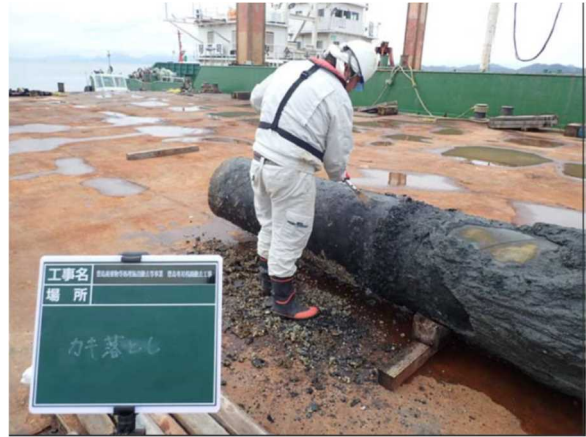
鋼管杭撤去 かき落とし
