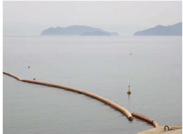
灯浮標設置状況 (遠景)
