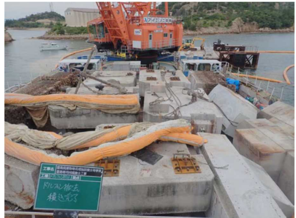
ドルフィン積込状況 (起重機船内)
