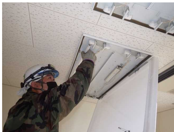
蛍光灯撤去状況
