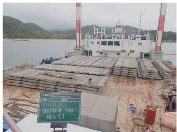
PC床版積込状況 (起重機船内)
