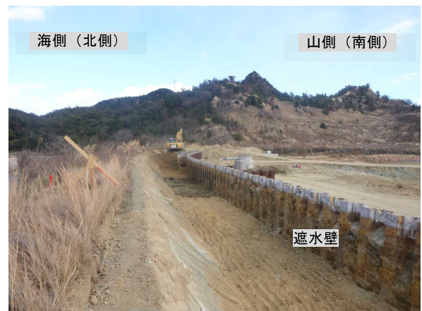
写真 20 背面土砂掘削後（中央から東向き）
