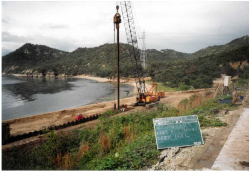
バイブロハンマによる打設状況【H12暫定的な環境保全措置工事（第1工区）】
