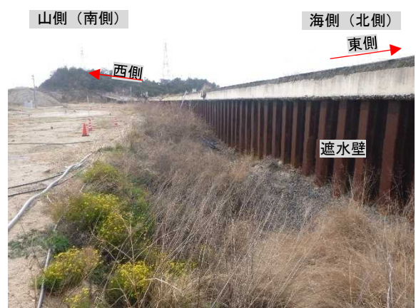
写真IV-4 遮水壁撤去前（処分地側（西向き））
