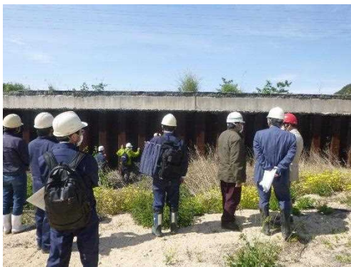
写真1 遮水壁側面部
