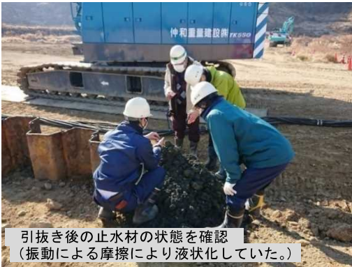
写真3 引抜き後の確認状況1 (バイブロハンマ)
