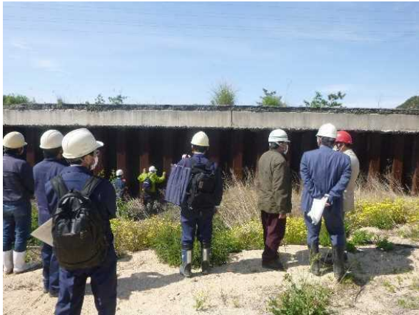
写真9 遮水壁側面部
