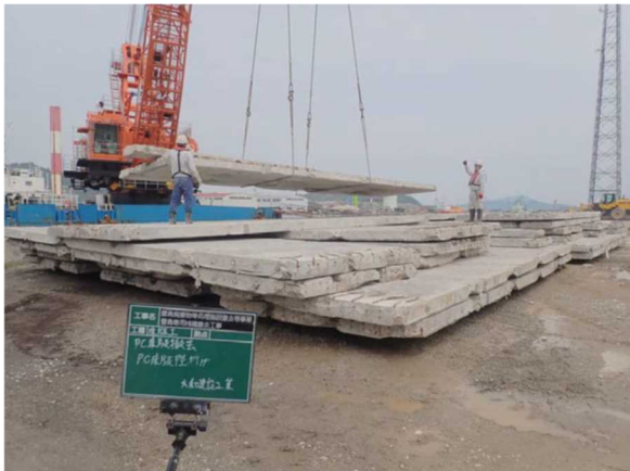
床版撤去 荷下し
