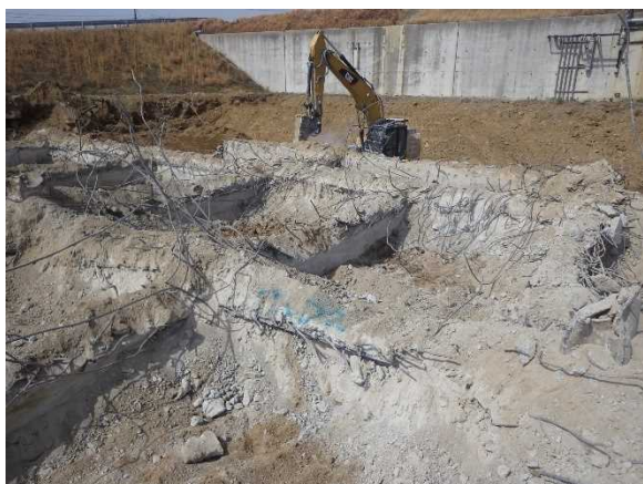
基礎解体状況
