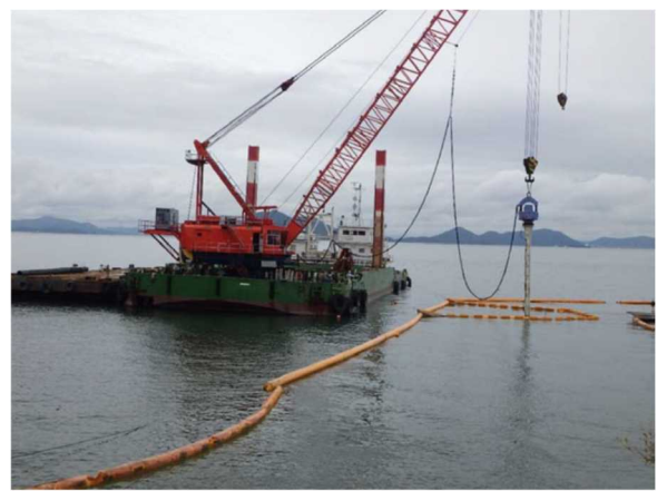
鋼管杭引抜状況 (バイプロハンマ、遠景)
