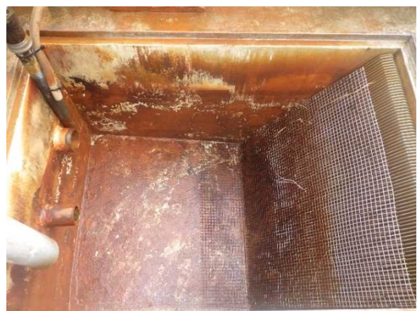
写真Ⅲ-2 高度排水処理施設（沈砂層）洗浄後
