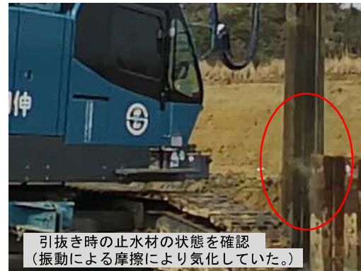
写真5 引抜き時の止水材の気化状況
