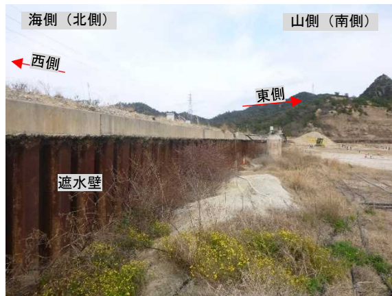
写真IV-3 遮水壁撤去前（処分地側（東向き））
