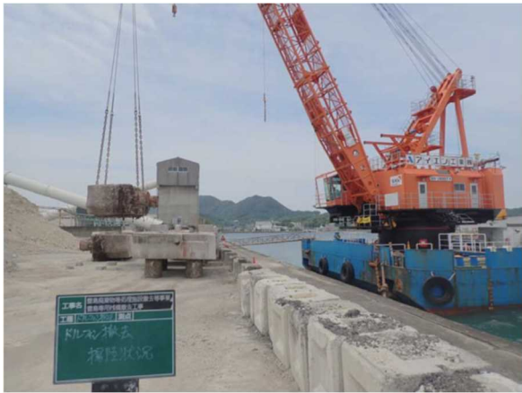
ドルフィン撤去 荷下し
