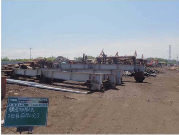
橋橋上部鋼材撤去 荷下し後
