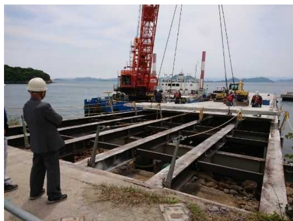
写真V-6 床版撤去作業の確認
