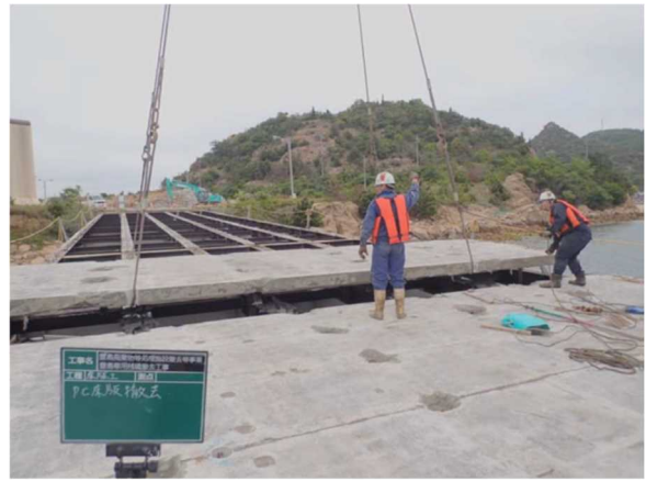
PC床版撤去状況 (近景)
