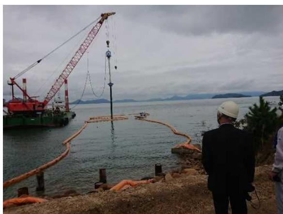
写真V-8 鋼管杭撤去作業の確認
