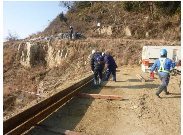
写真IV-8 引抜き後の鋼矢板の確認
