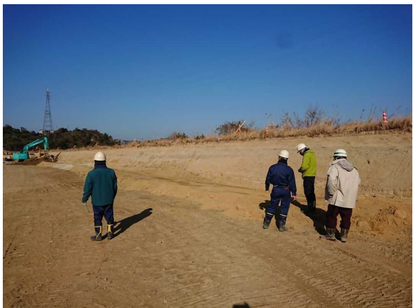
写真 38 松島委員立会状況（引抜き後の状況）
