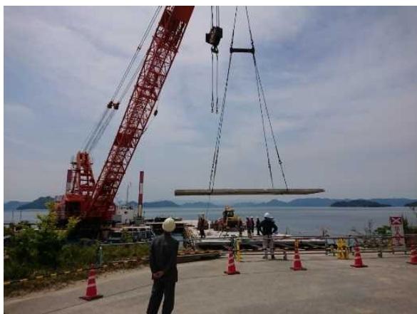
写真V-5 床版撤去作業の確認
