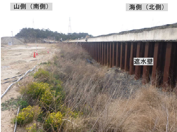
写真5 遮水壁処分地側（中央から西向き）
