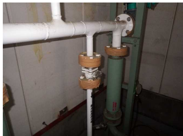
フランジガスキットのテープ養生状況
