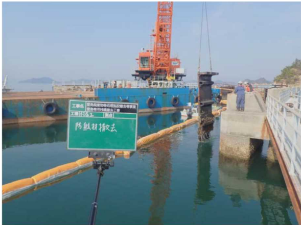
防舷材撤去状況
