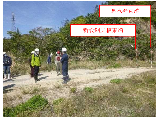
写真4 遮水壁東端部
