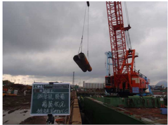
鋼管杭撤去 荷下し
