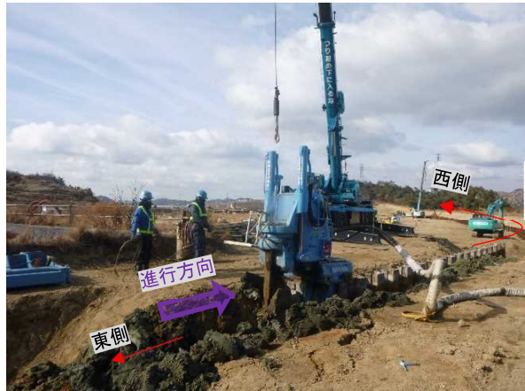
写真 28 油圧圧入引抜機による引抜き状況
