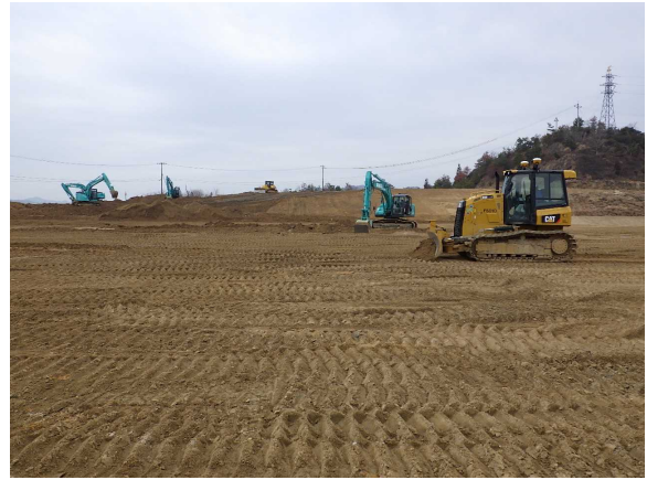
処分地内の整地状況
