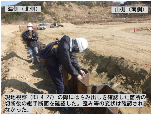
写真IV-9 接手部の切断状況の確認
