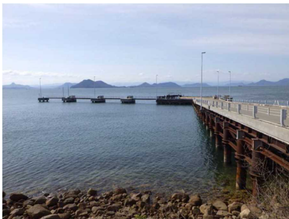
写真V-1 栈橋撤去前（陸側から撮影）
