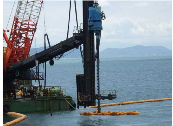
鋼管杭中掘削状況 (アースオーガ、近景)
