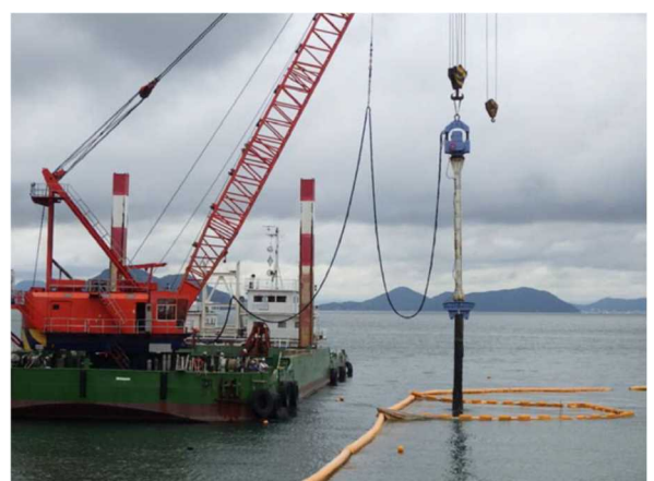
鋼管杭引抜状況 (バイプロハンマ、近景)
