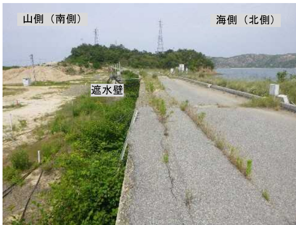
写真3 遮水壁上部（中央から西向き）
