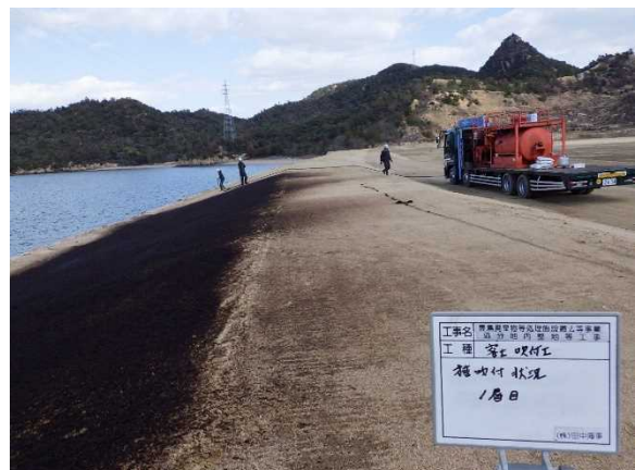
北海岸土堰堤付近の吹付状況
