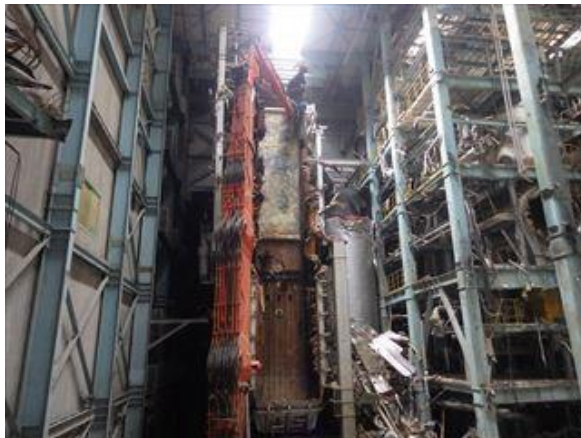
重機によるボイラー等解体作業中 (南棟内の南方向を撮影)
