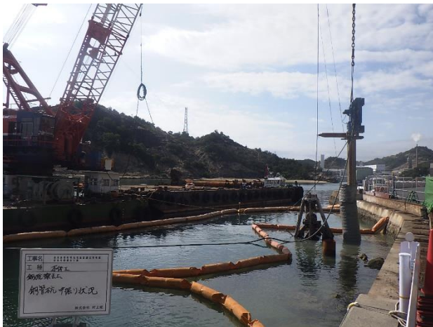
鋼管杭中掘狀況（遠景）
