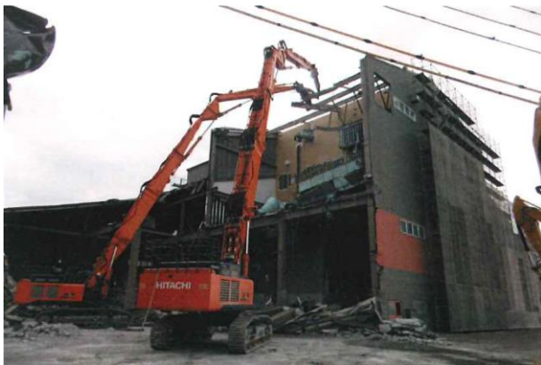
特殊前処理室付近解体中 （北西側から撮影）
