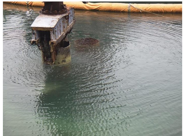
鋼管杭引抜狀況（近景）
