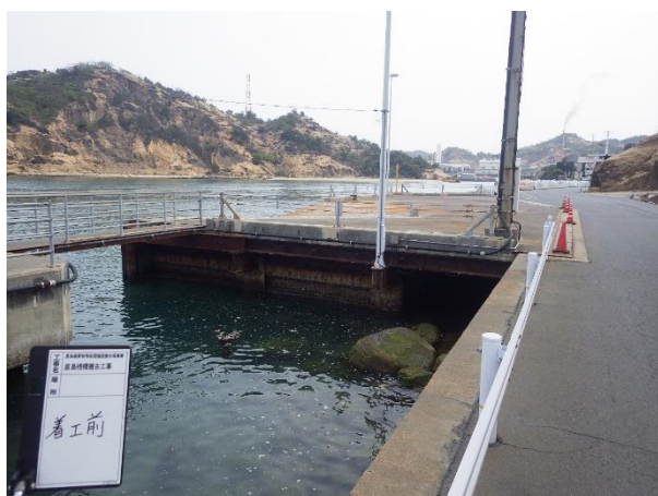
直島専用棧橋解体前 (北西側から撮影)
