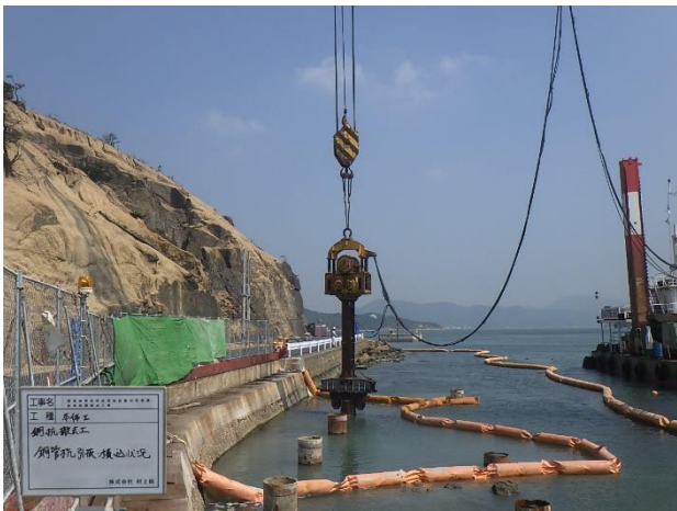
鋼管杭引抜狀況（遠景）
