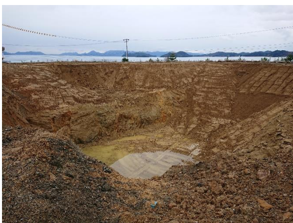
解体撤去完了後 (東側から撮影)
