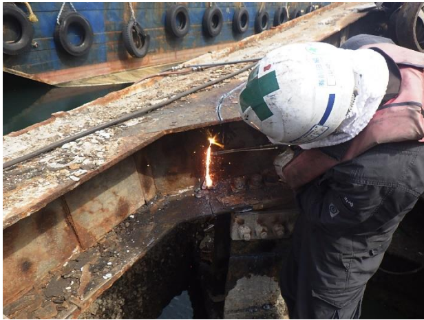
H鋼溶断状況
