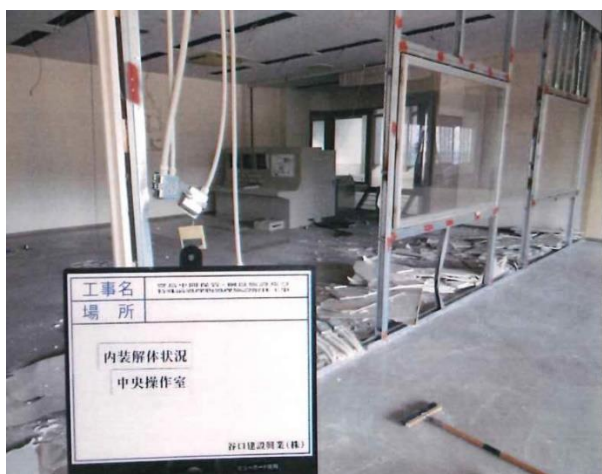
中央操作室付近内装解体中 （南東方向から撮影）
