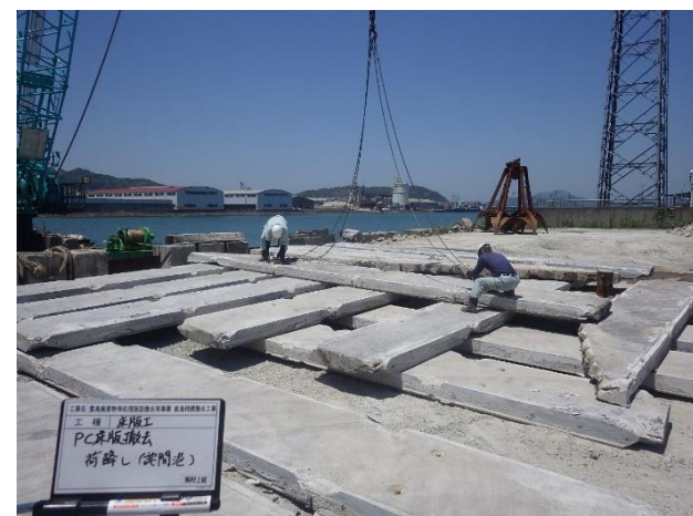
PC 床板撤去 荷下し後
