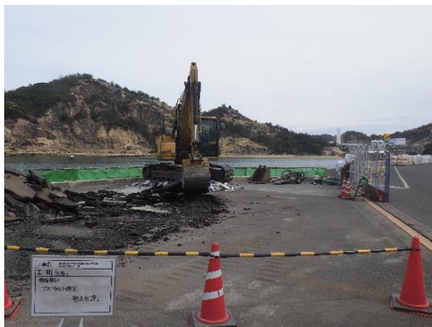
アスファルト粉砕状況
