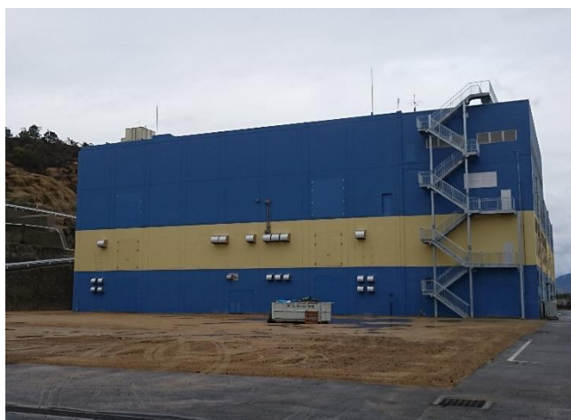
建屋等改修工事完了後 南東側から撮影
