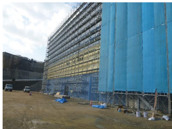
建屋等改修工事中（非常階段設置工事） 南東側から撮影
