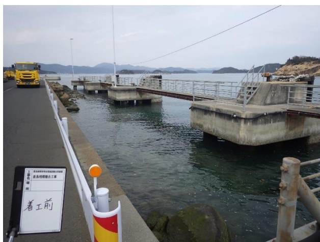
直島専用棧橋ドルフィン解体前 (南西側から撮影)
