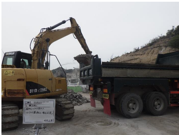
PC 床板コンクリートガラ搬出
