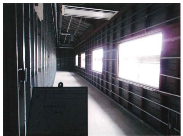
廊下付近内装解体後 (南方向から撮影)
