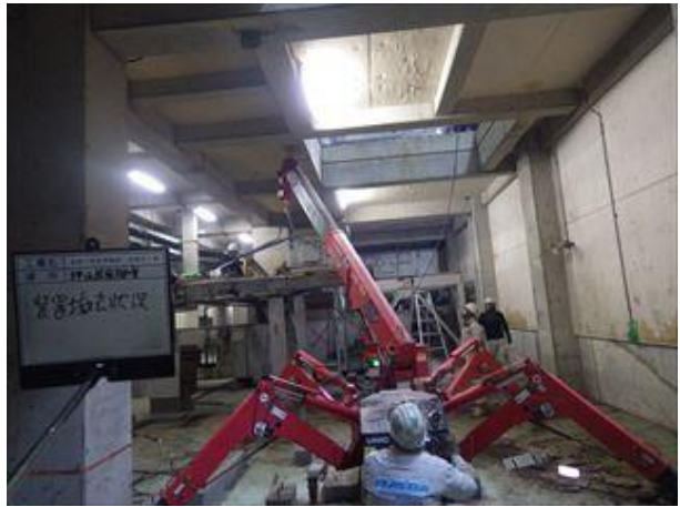
供給ホッパ下部重機による解体作業中
