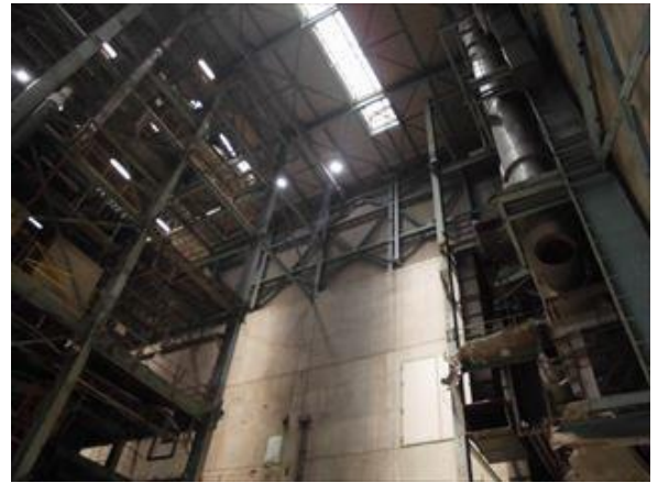
南棟プラント解体前
