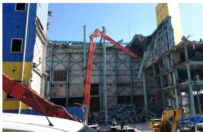
南棟建屋解体中（西側から撮影）
