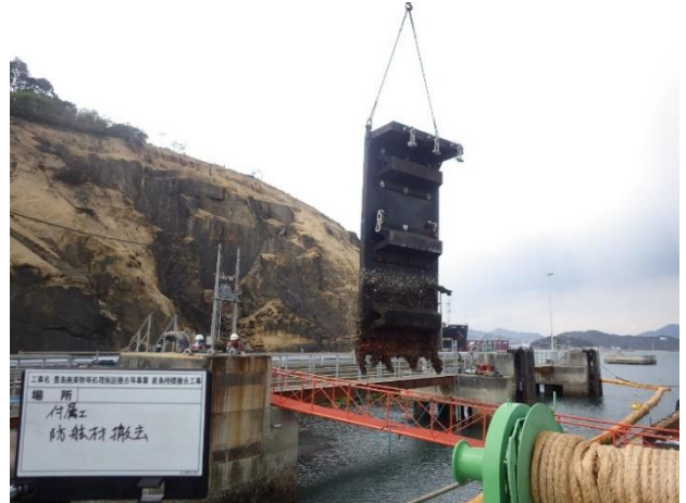
防舷材撤去状況
