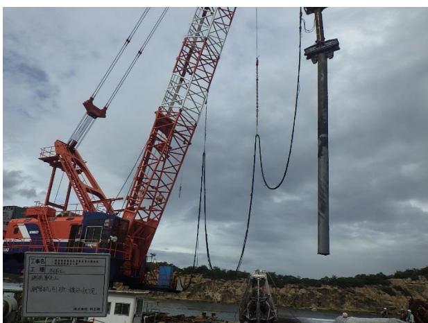
鋼管杭積込狀況
