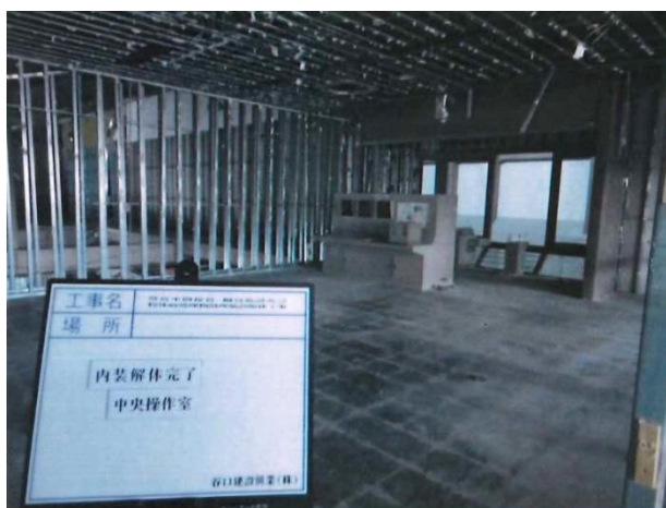
中央操作室付近内装解体後 （南東方向から撮影）
