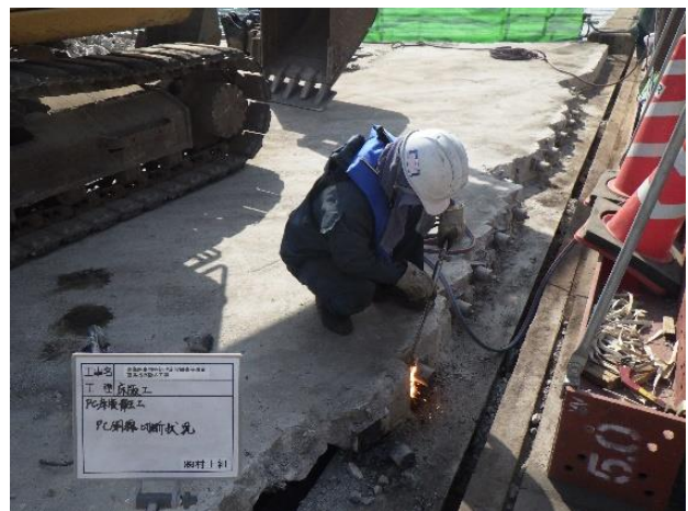
PC床板線金具切断状況
