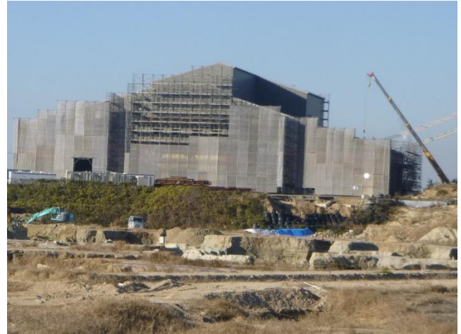
建屋解体前（東側から撮影）
