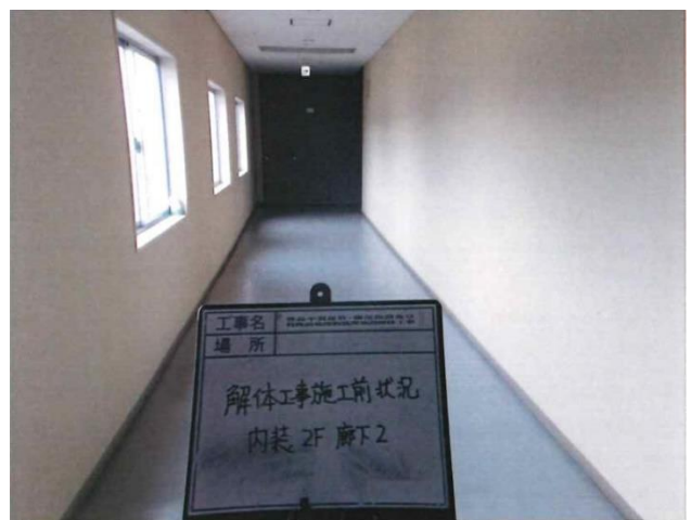
廊下付近内装解体前 (北方向から撮影)
