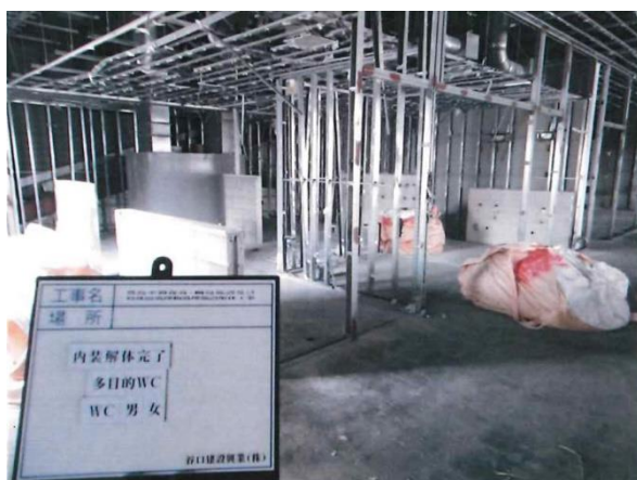
トイレ付近内装解体後 (南東方向から撮影)
