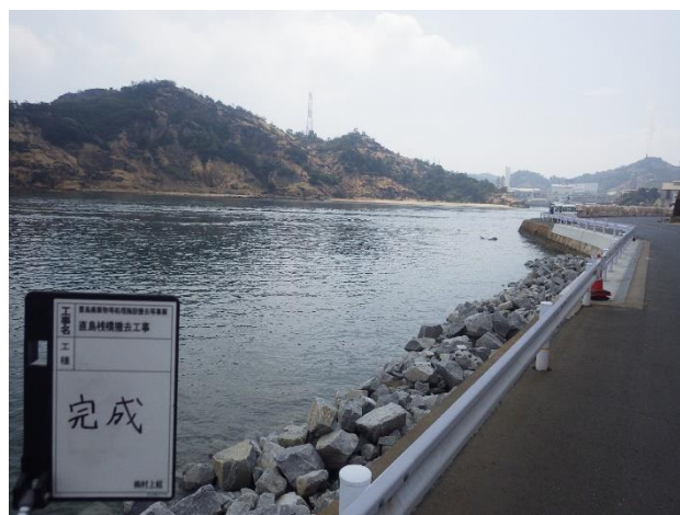
直島専用棧橋解体後 (北西側から撮影)
