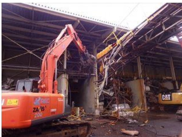
スラグ搬送コンベヤ解体中 （北東側から撮影）
