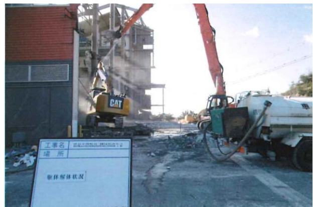
投入前室付近解体中（東側から撮影）
