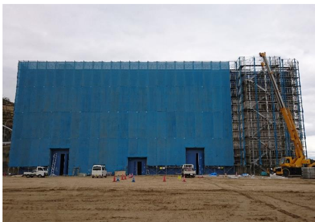
建屋等改修工事中（非常階段設置工事） 南から撮影
