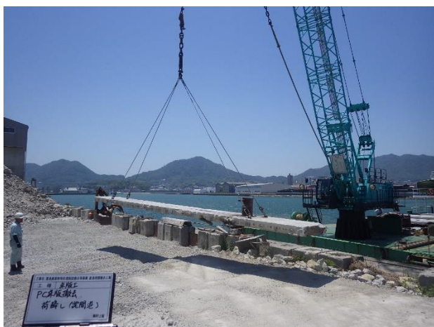
PC 床板撤去 荷下し
