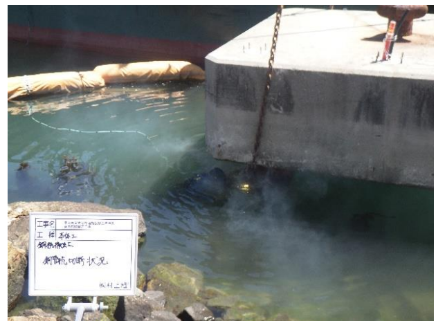
鋼管杭切断状況
