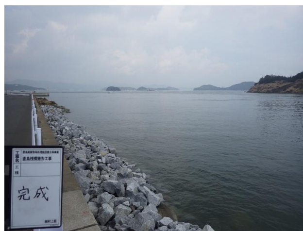
直島専用棧橋ドルフィン解体後 (南西側から撮影)
