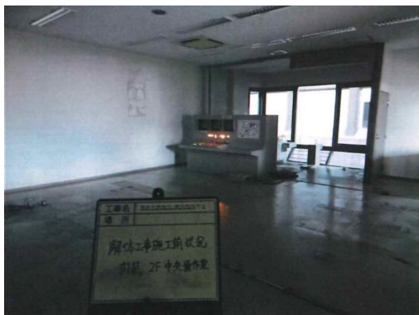
中央操作室内付近装解体前 （南東方向から撮影）
