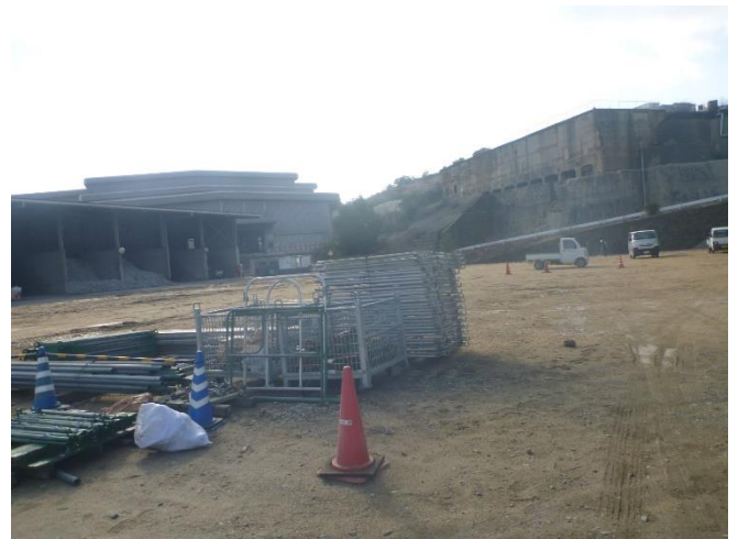
南棟建屋解体撤去完了後（北東から撮影）
