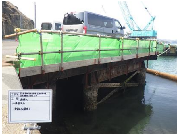
落下防止柵設置状況
