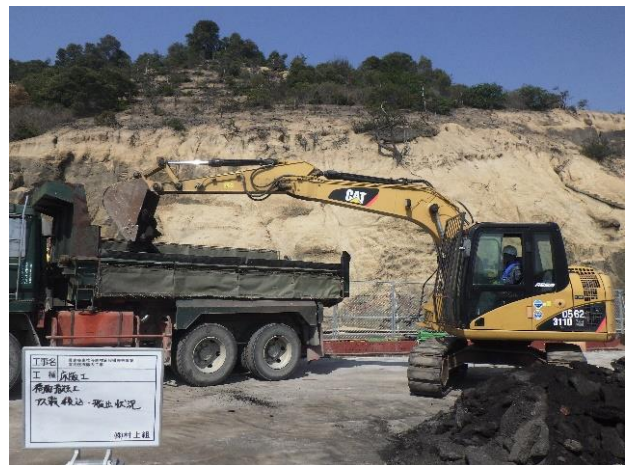
PC 床板アスファルトガラ搬出
