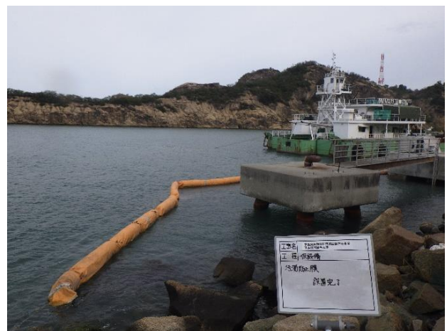
汚濁防止膜設置状況
