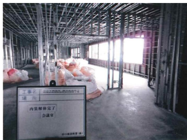
会議室付近内装解体後 （南方向から撮影）
