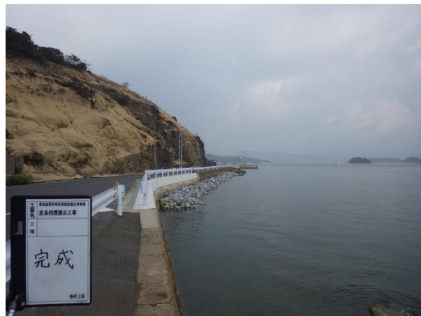
直島専用棧橋解体後 (南側から撮影)
