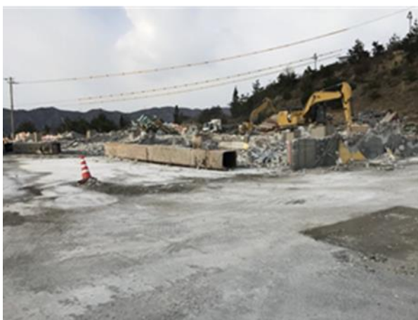
建屋解体撤去完了後 （南東側から撮影）
