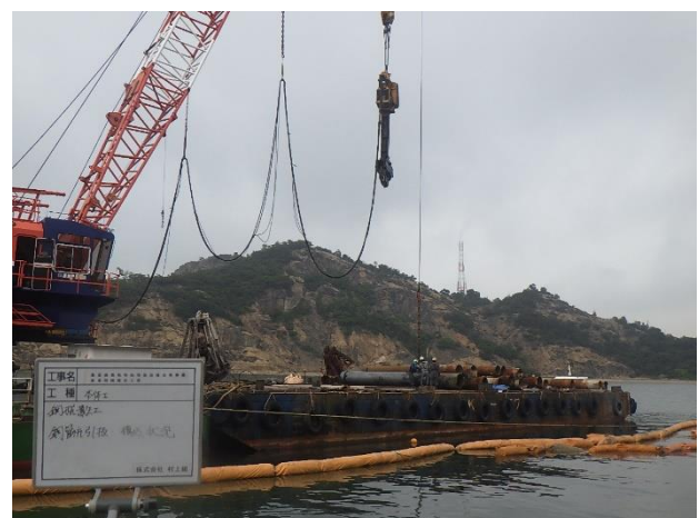
鋼管杭積込狀況
