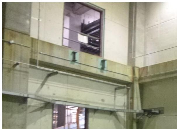
粗破砕機搬送コンベヤ及び粗破砕機解体作業後 (1階から北東方向に撮影)
