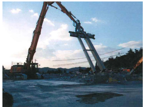
鉄骨転倒防止用重機の使用の状況 （東側から撮影）
