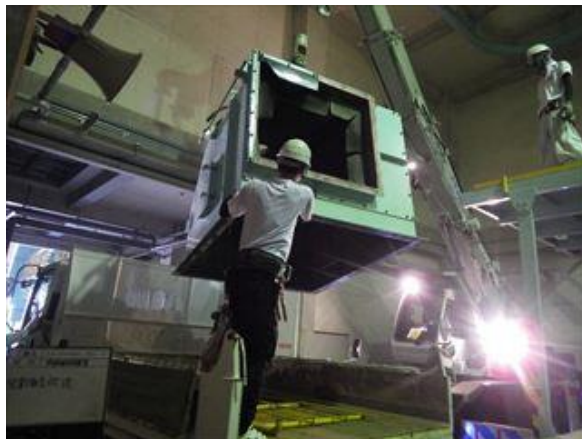
粗破砕機解体作業中
