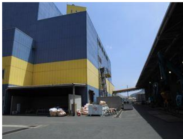
南棟建屋解体前（南西側から撮影）
