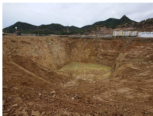
解体撤去完了後 (西側から撮影)
