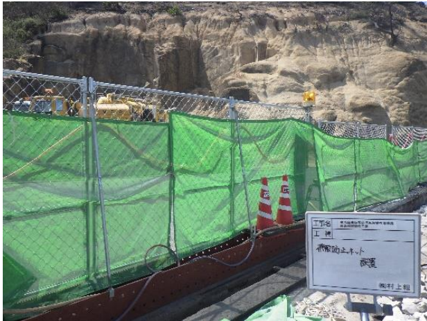
飛散防止ネット設置
