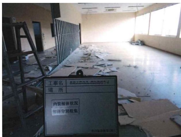
会議室付近内装解体中 （南方向から撮影）
