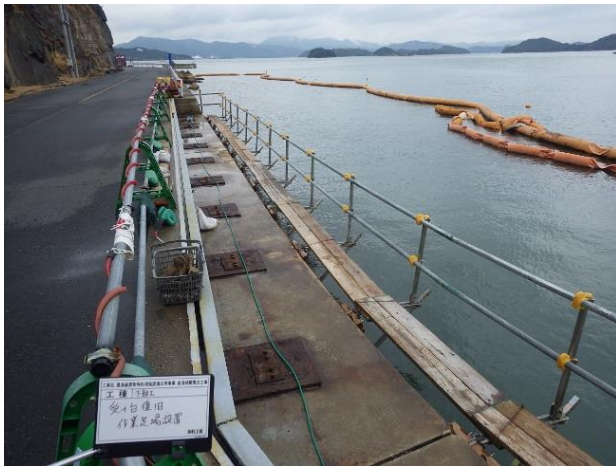
受け台復旧 足場設置状況
