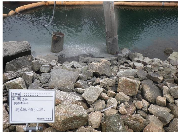
鋼管杭中掘狀況（近景）
