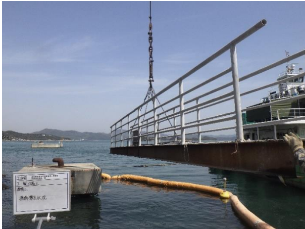
棧橋撤去状況
