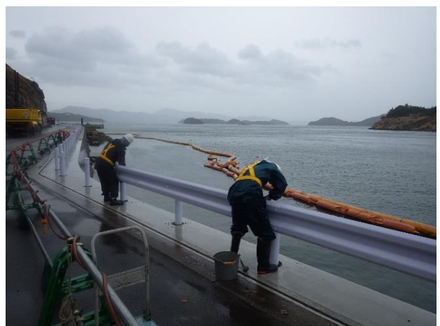
受け台復旧 ガードレール設置
