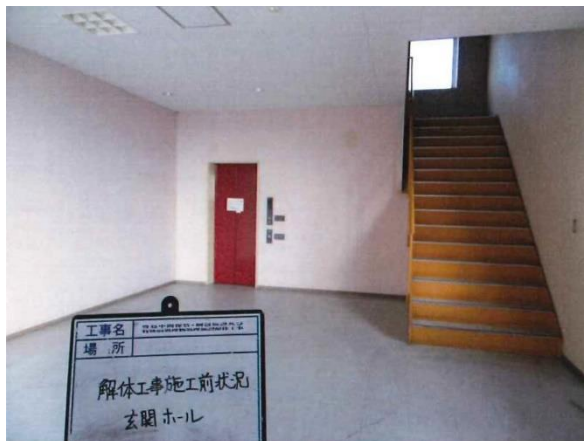
1階玄関ホール付近内装解体前 (西側から撮影)
