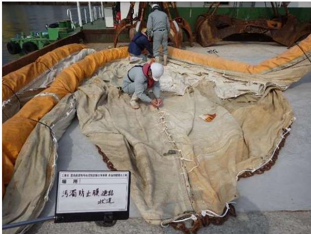
汚濁防止膜連結状況
