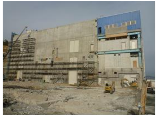
南棟建屋解体後（南東から撮影）
