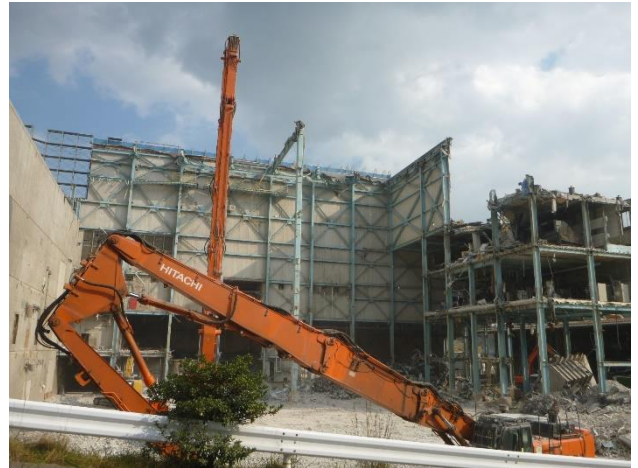
南棟建屋解体中（西側から撮影）
