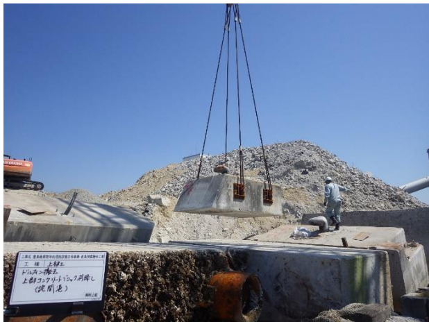
ドルフィン撤去 荷下し
