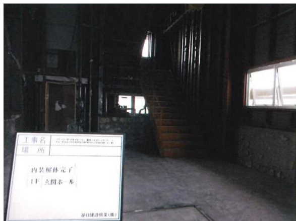
1階玄関ホール付近内装解体後 (西側から撮影)
