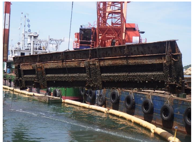
カーテンウォール撤去状況
