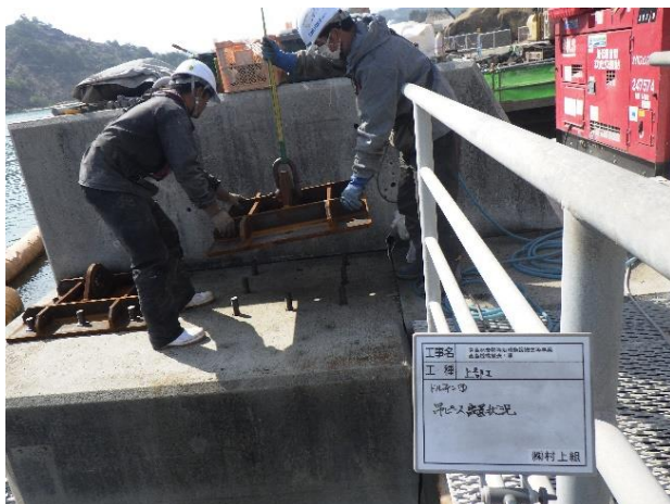
吊りピース設置状況
