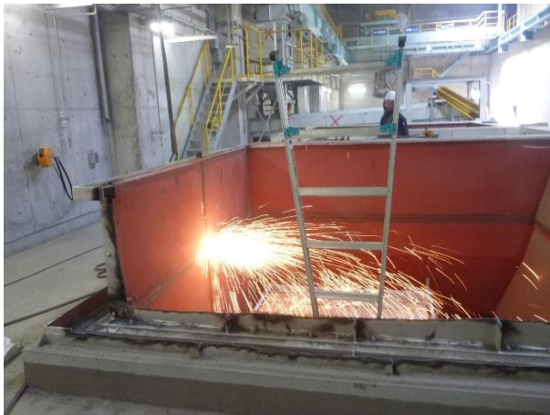
供給ホッパ上部ガス溶断による解体作業中
