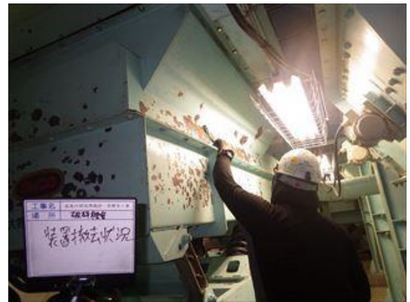
粗大物搬送コンベヤ解体作業中
