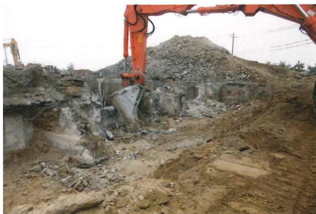
基礎・地中梁解体の状況 (東側から撮影)
