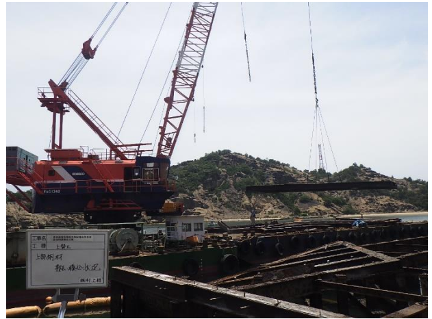
H鋼撤去状況
