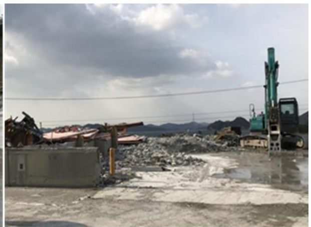
建屋解体撤去完了後 （東側から撮影）
