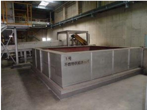
供給ホッパ解体作業前
