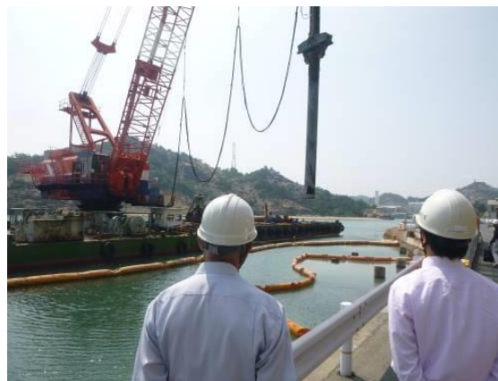
写真14 杭撤去作業の確認 (北西より撮影) 再掲
