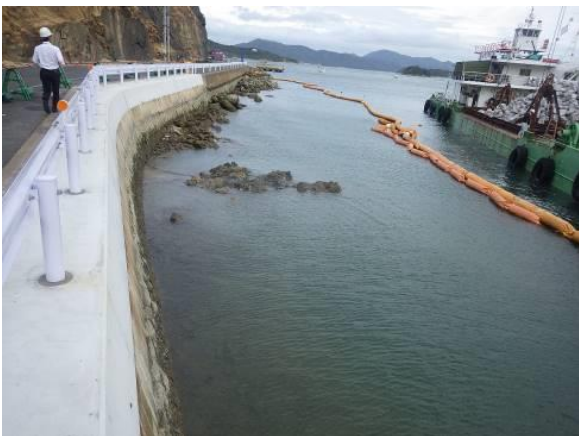
写真21 埋戻し及び敷均し前の状況
