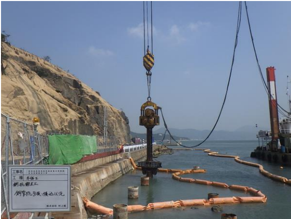
写真17 鋼管杭の引抜状況①
