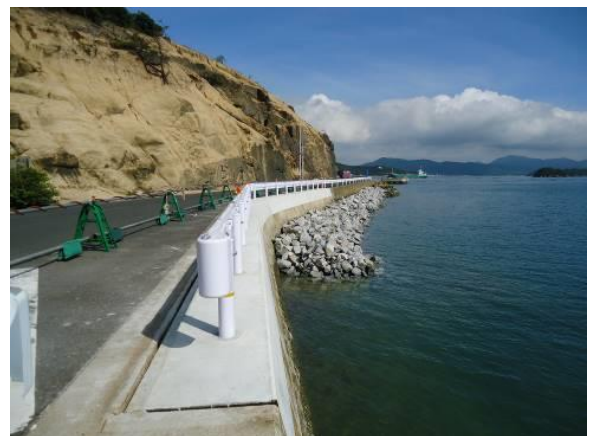
写真22 撤去完了後の状況
