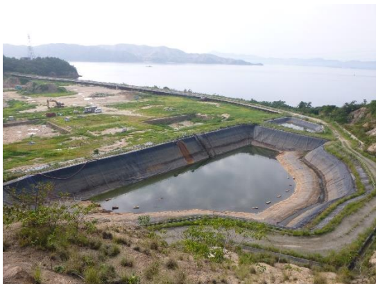
写真1 貯留トレンチ
