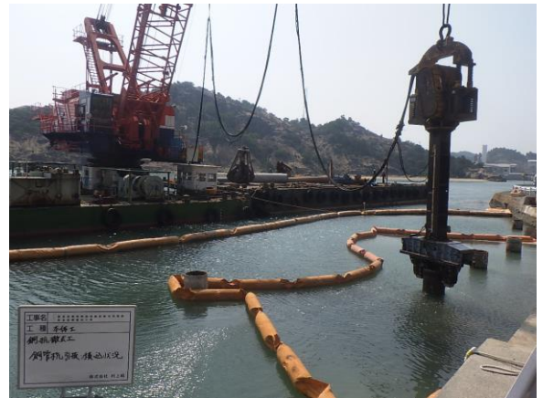
写真18 鋼管杭の引抜状況②
