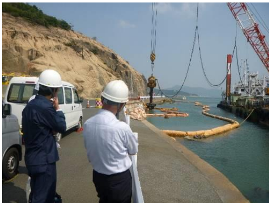
写真3 杭撤去作業の状況の確認（南より撮影）
