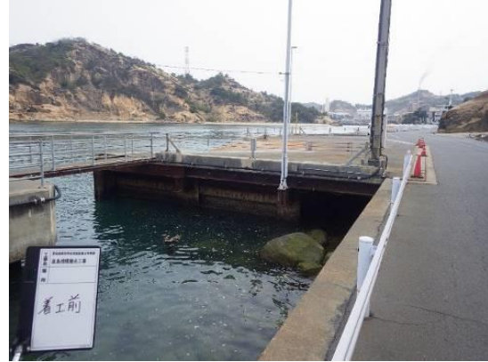
写真2 床版（北西より撮影）
