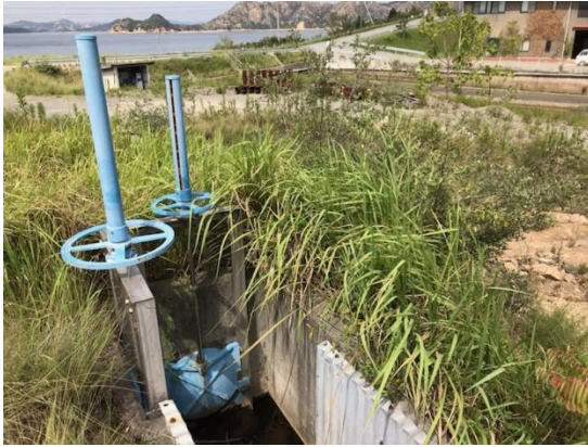
写真3 処分地進入路の排水路
