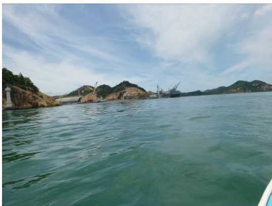
写真 7 基本監視点(東側から) R1. 6. 18
