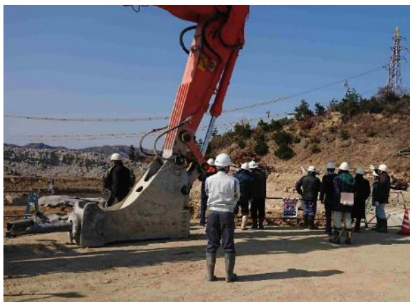
①ピットの解体状況の確認
