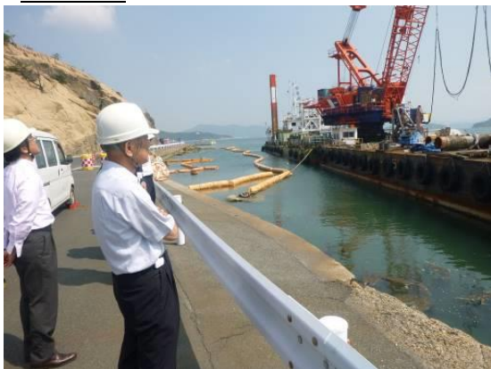
写真11 杭撤去作業の確認 (南より撮影)
