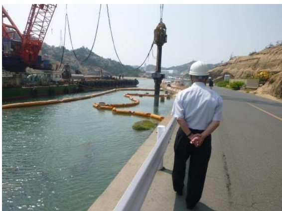
写真13 杭撤去作業の確認 (北より撮影)
