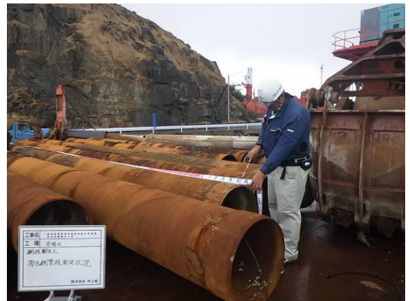
写真20 鋼管杭の確認状況
