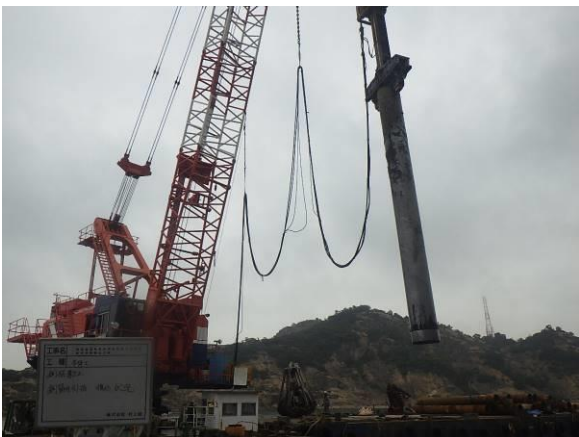
写真19 鋼管杭の引抜状況③
