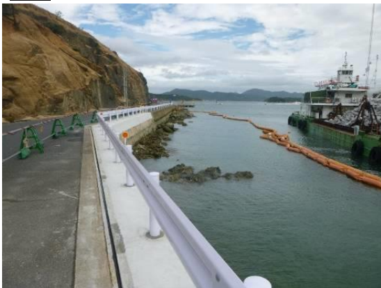
写真5 撤去状況（南より撮影）
