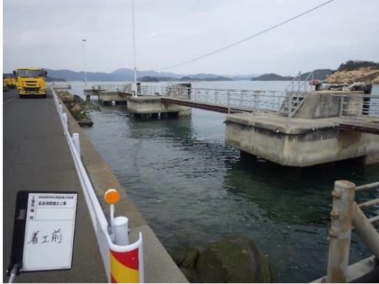
写真1 栈橋、ドルフィン（南より撮影）
