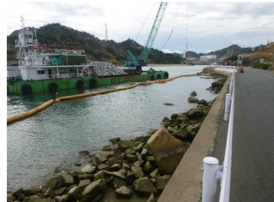
写真6 撤去状況（北西より撮影）
