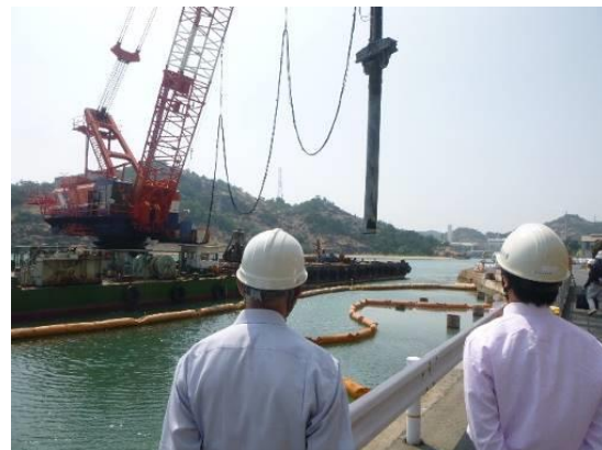
写真4 杭撤去作業の状況の確認（北西より撮影）
