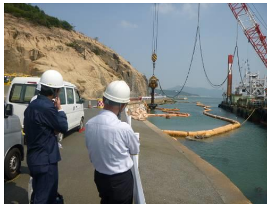
写真12 杭撤去作業の確認 (南より撮影) 再掲
