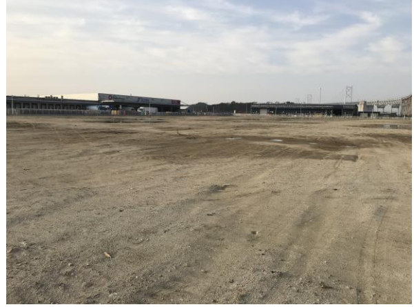
写真2 整地後の状況 (H30. 3. 12 撮影)
