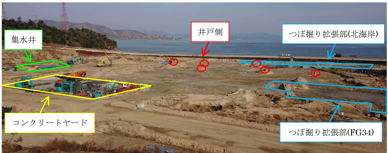
写真1 施工状況（H30.2.16撮影）
