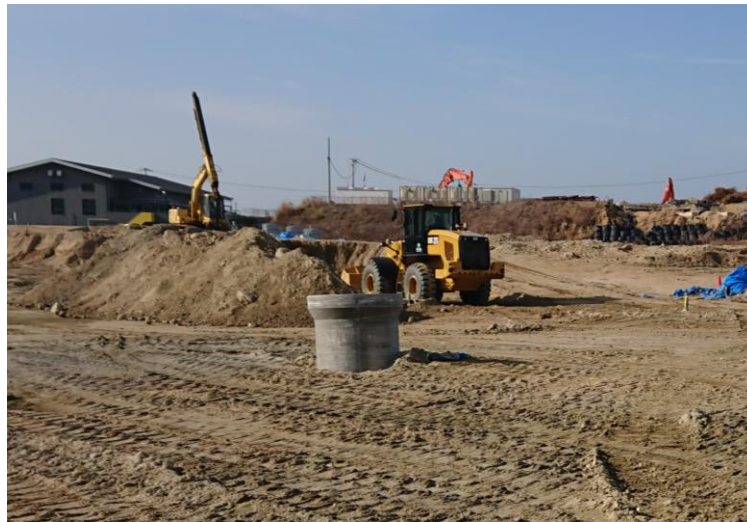
写真2 井戸側の設置状況
