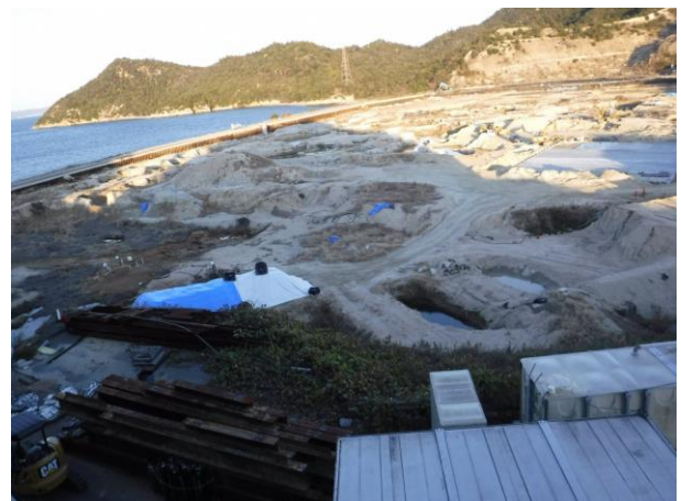
写真2 杭基礎等撤去後の状況 (H29.12.12撮影)
