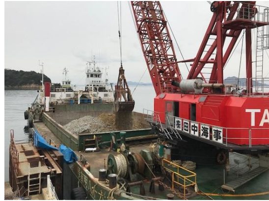
④施設撤去廃棄物等の搬出状況
