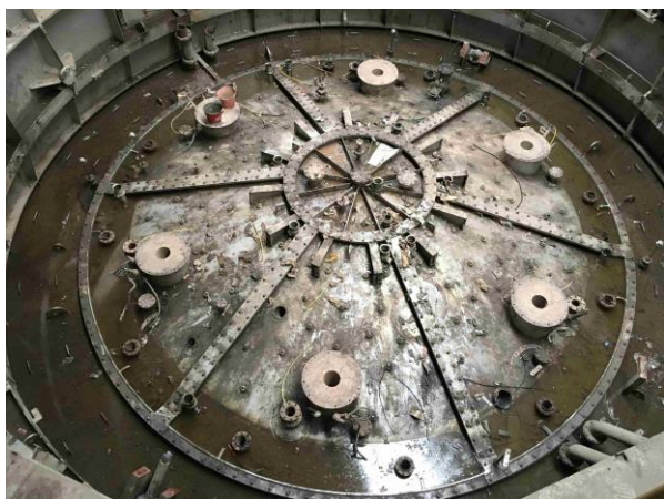
① 溶融炉上部（機器類撤去後）
