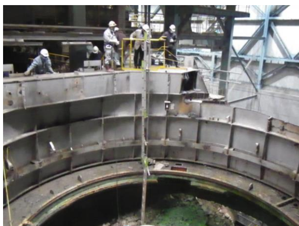
③溶融炉の解体及び除去・除染の状況
