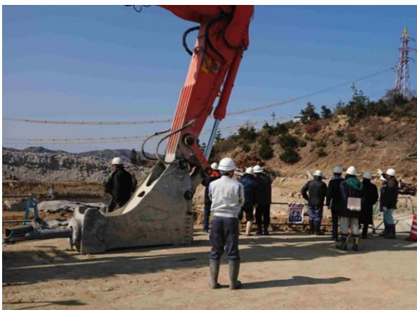
①ピットの解体状況の確認
