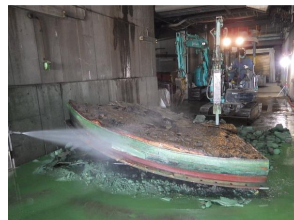
⑥ 溶融炉ケーシング（除染作業中）
