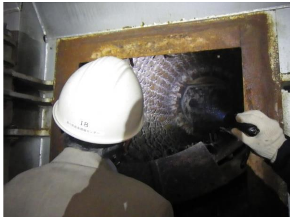
④ロータリーキルンの除去・除染の状況
