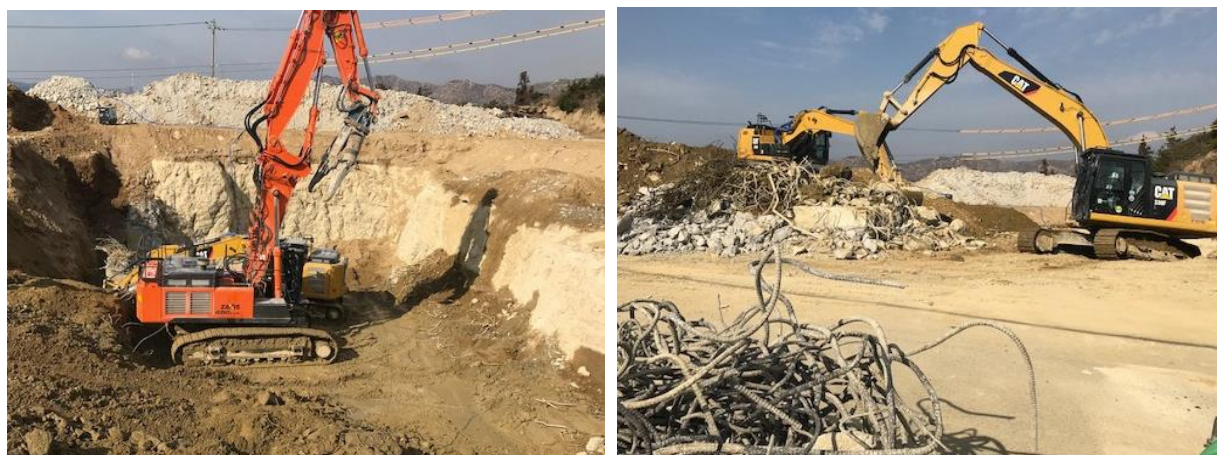
①ピットの解体状況
