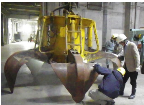
①投入クレーンの除去作業等の完了状況
