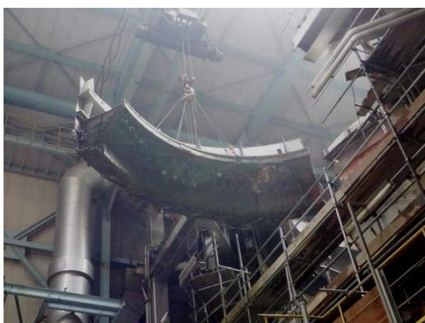
⑤ 溶融炉ケーシング（吊り降ろし中）
