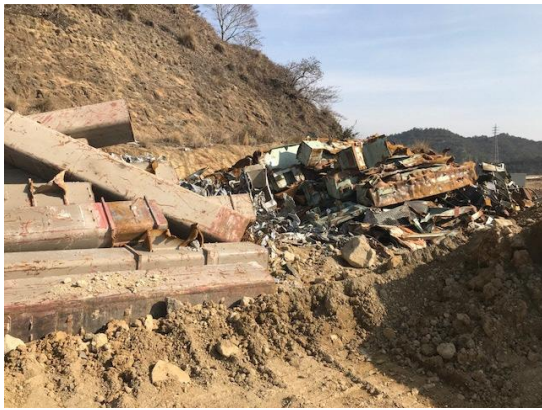
③施設撤去廃棄物等の保管状況
