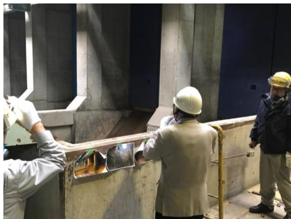
②ピットの除去・除染作業の完了状況
