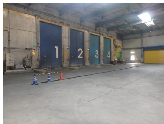
⑥建築構造物 (プラットフォーム)
