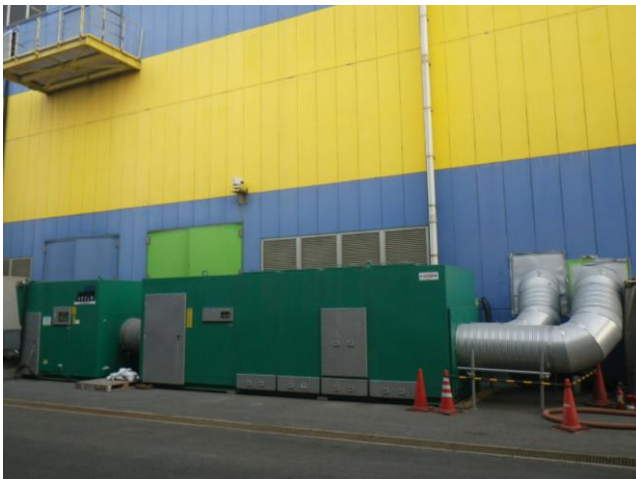
①負圧集じん機の設置状況
