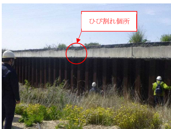
写真1 全景 (FG 測線中間付近)
