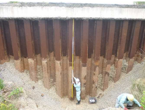
写真11 肉厚測定箇所-掘削状況 (FG 中間付近)
