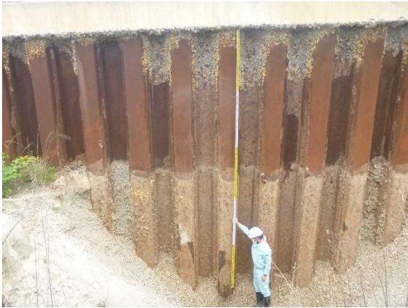
写真9 肉厚測定箇所-掘削状況 (E 測線付近)
