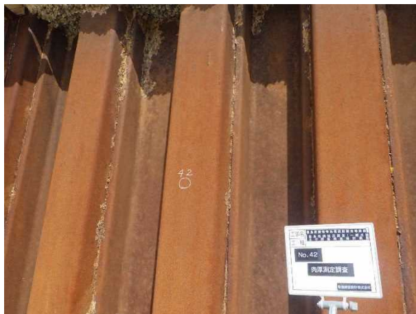
写真 5 肉厚測定箇所-研磨前 (No. 42)
