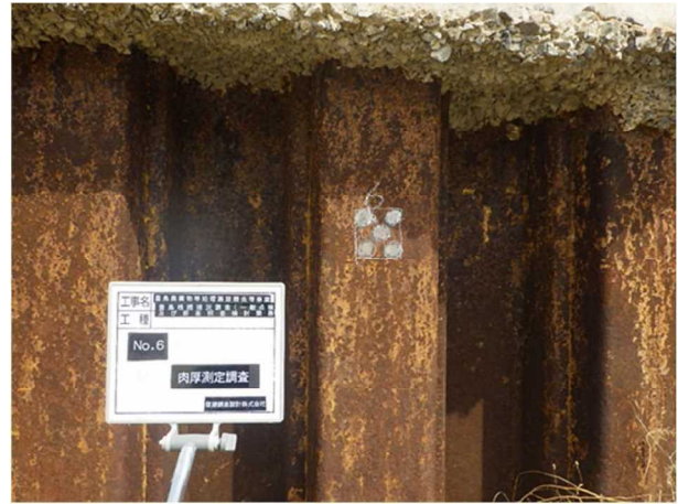
写真 2 肉厚測定箇所-研磨後 (No. 6)
