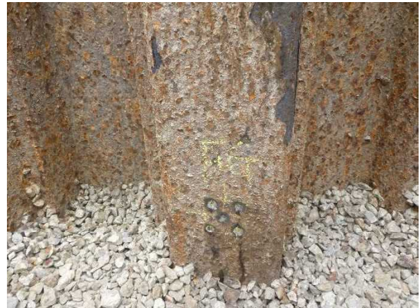
写真12 肉厚測定箇所-研磨後 (FG 中間付近)
