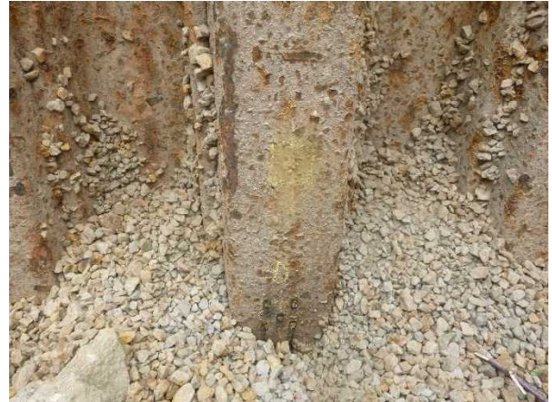
写真8 肉厚測定箇所-研磨後 (D 測線付近)
