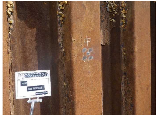
写真 4 肉厚測定箇所-研磨後 (中間)
