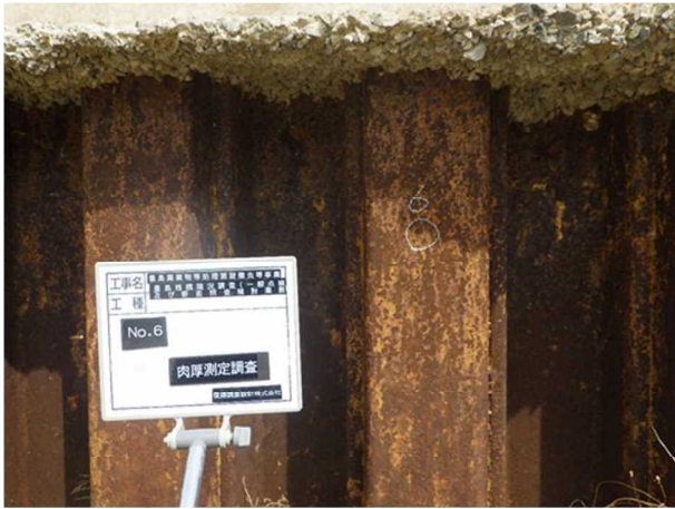
写真 1 肉厚測定箇所-研磨前 (No. 6)
