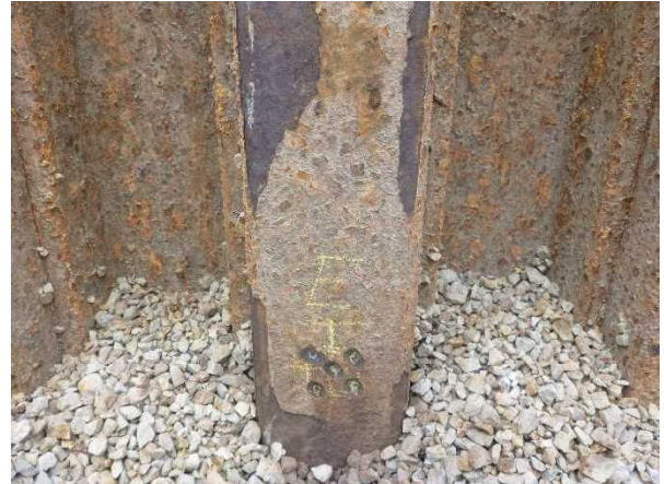
写真10 肉厚測定箇所-研磨後 (E 測線付近)
