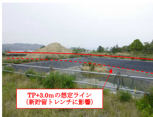
写真4 東側端部の状況
