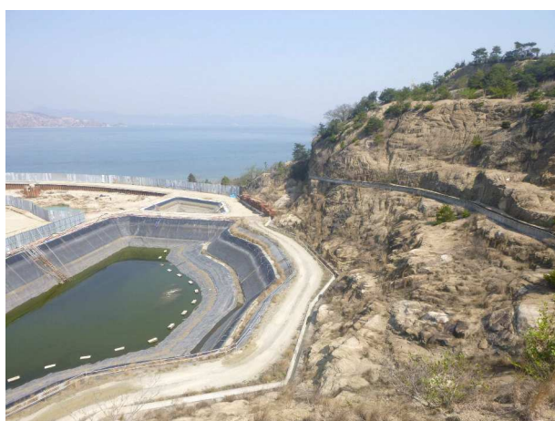
写真1 撤去前の状況（H29.7.13撮影）
