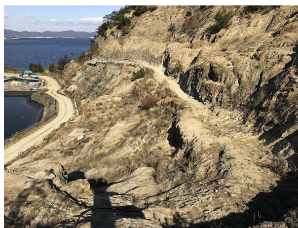
写真2 撤去後の状況（H29.12.12撮影）
