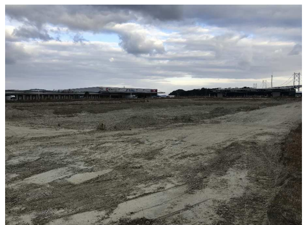
写真2 仮囲い、管理用道路の砕石撤去後の状況 (H29.12.18撮影)
