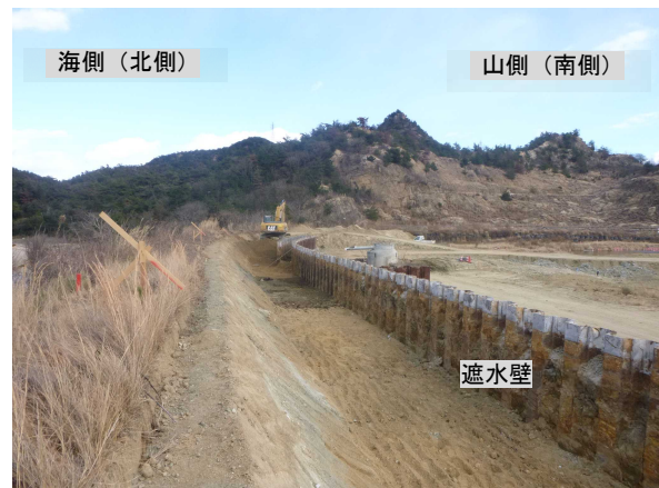
写真 20 背面土砂掘削後（中央から東向き）
