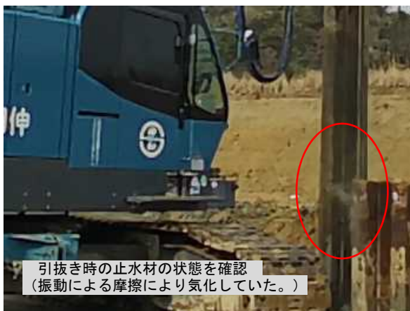
写真 31 引抜き時の止水材の気化状況
