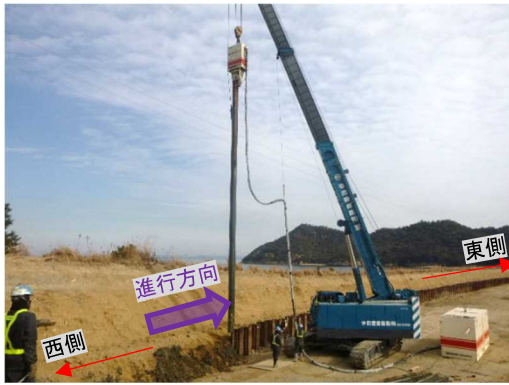
写真1 バイブロハンマによる引抜き状況
