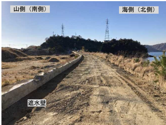
写真 15 A s 舗装等撤去後（中央から西向き）
