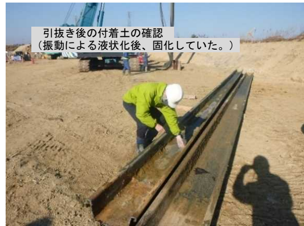
写真 30 引抜き後の確認状況 2 (バイブロハンマ)
