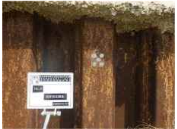
写真2 肉厚測定箇所-研磨後 (No. 6)
