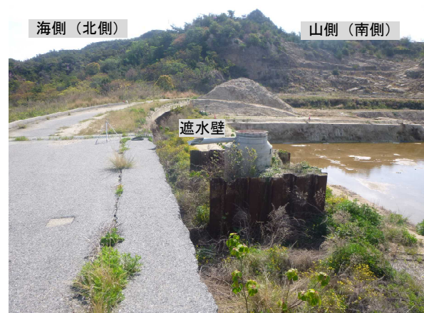
写真4 遮水壁上部（中央から東向き）
