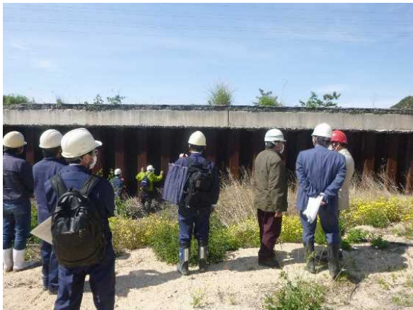
写真9 遮水壁側面部
