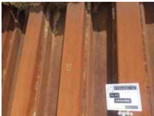
写真5 肉厚測定箇所-研磨前 (No. 42)
