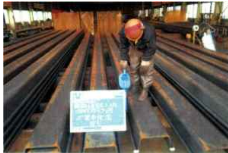
鋼板への止水材塗布状況【H27北海岸トレンチドレーン撤去及び仮設矢板設置工事（第1工区）】
