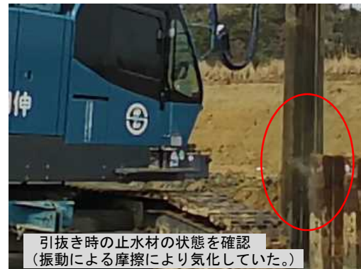
写真5 引抜き時の止水材の気化状況
