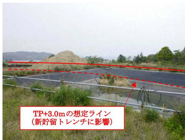
写真4 東側端部の状況
