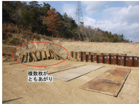
写真 24 西側端部の引抜き後の状況
