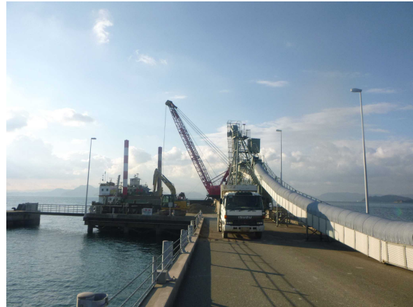
写真 22 トレンチドレーンの搬出状況
