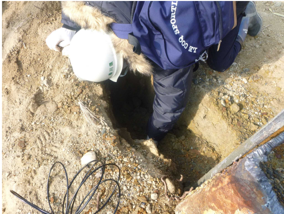
写真 33 松島委員立会状況（引抜き跡の確認）
