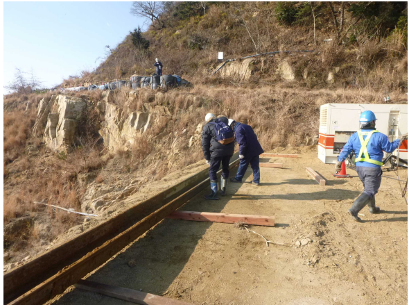
写真 34 松島委員立会状況（鋼矢板の状況）
