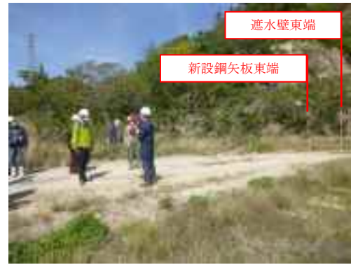
写真4 遮水壁東端部
