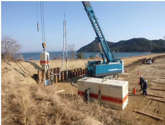
写真 23 鋼矢板の引抜き開始（西側端部から）
