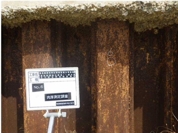
写真 1 肉厚測定箇所-研磨前 (No. 6)
