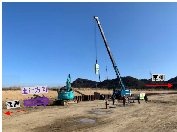
写真 26 バイブロハンマによる引抜き状況 2
