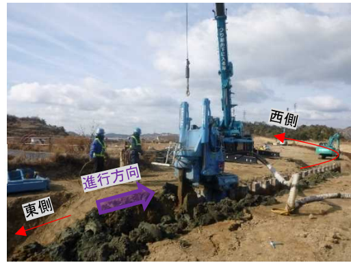
写真2 油圧圧入引抜機による引抜き状況
