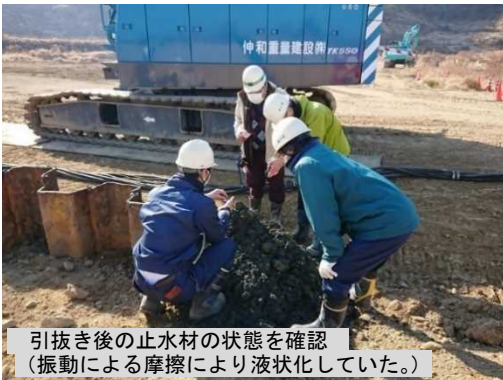
写真3 引抜き後の確認状況1 (バイブロハンマ)
