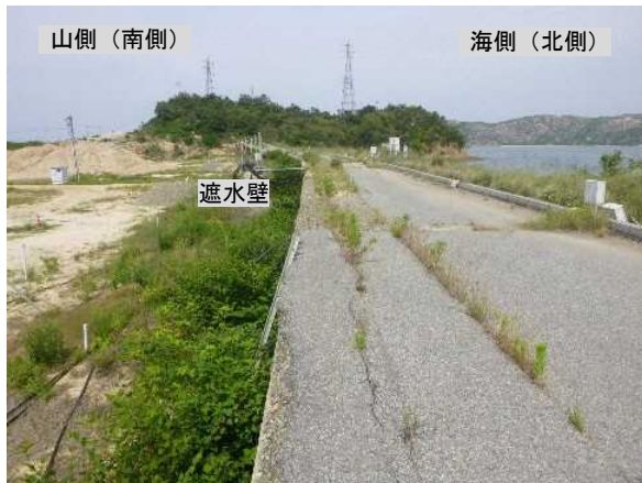
写真3 遮水壁上部（中央から西向き）
