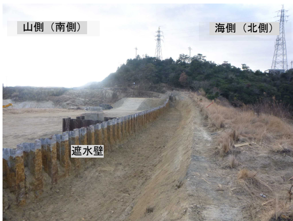
写真 19 背面土砂掘削後（中央から西向き）
