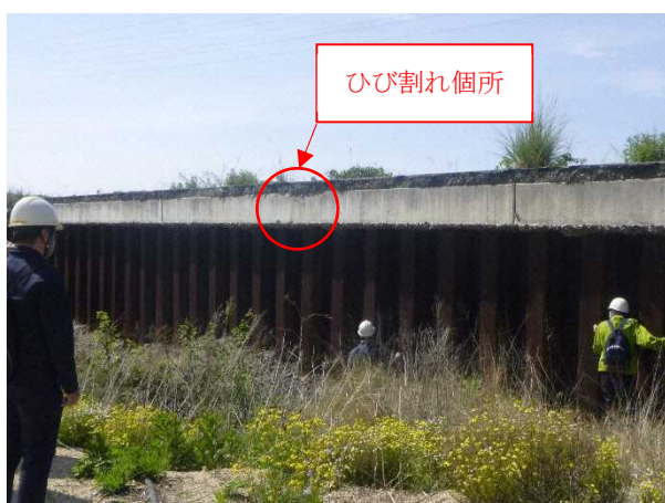
写真1 全景 (FG 測線中間付近)
