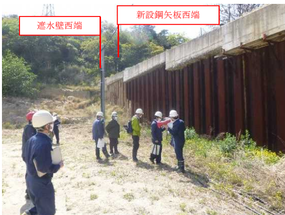
写真11 遮水壁西端部
