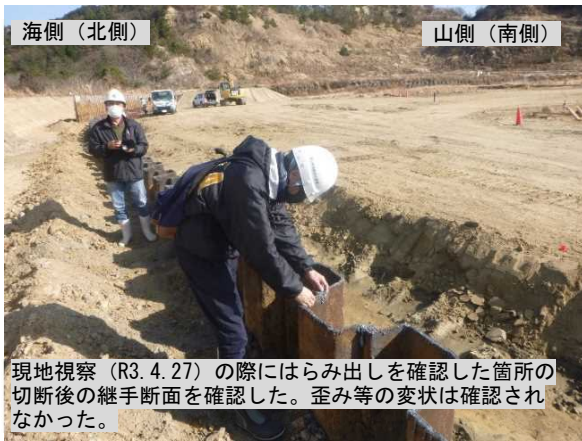
写真 35 松島委員立会状況（接手部の確認）
