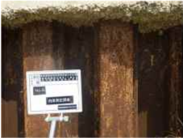
写真1 肉厚測定箇所-研磨前 (No. 6)
