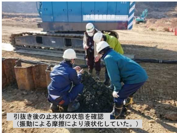
写真 29 引抜き後の確認状況 1 (バイブロハンマ)
