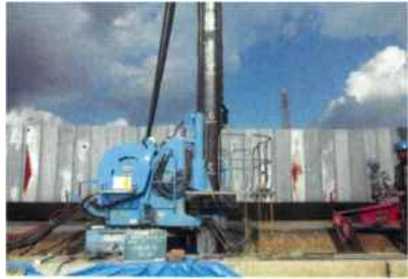
クラッシュバイラーによる圧入状況【H27北海岸トレンチドレーン撤去及び仮設矢板設置工事（第1工区）】
