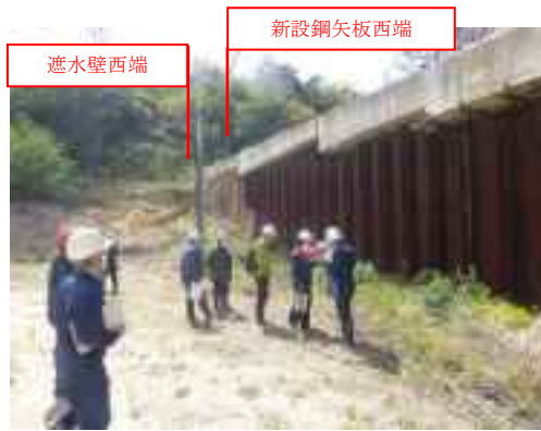
写真3 遮水壁西端部
