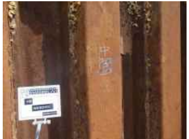
写真4 肉厚測定箇所-研磨後 (中間)
