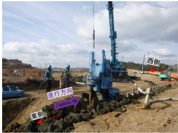
写真 28 油圧圧入引抜機による引抜き状況
