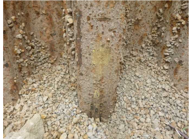
写真8 肉厚測定箇所-研磨後 (D 測線付近)
