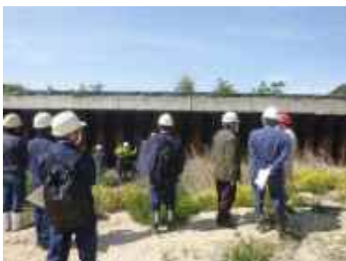
写真1 遮水壁側面部
