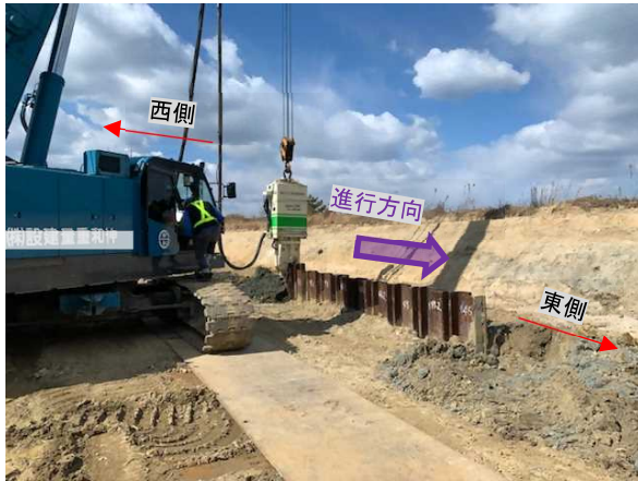
写真 27 バイブロハンマによる引抜き状況 3
