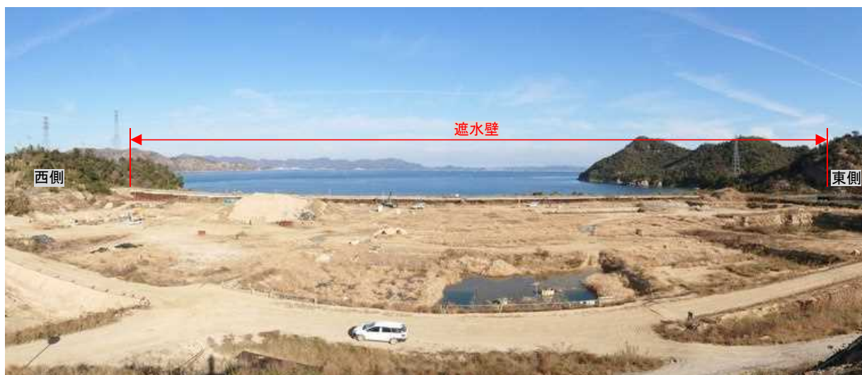
写真1 引抜き前の処分地内の状況 (令和3年11月29日)
