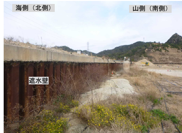
写真6 遮水壁処分地側（中央から東向き）
