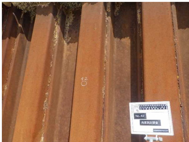
写真 5 肉厚測定箇所-研磨前 (No. 42)
