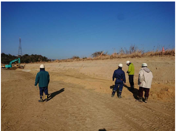
写真 38 松島委員立会状況（引抜き後の状況）
