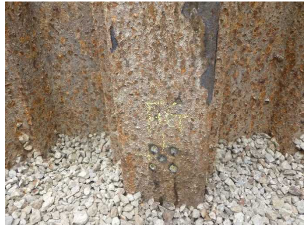
写真12 肉厚測定箇所-研磨後 (FG 中間付近)
