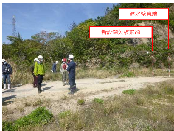
写真12 遮水壁東端部
