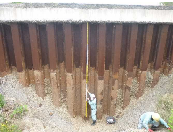
写真11 肉厚測定箇所-掘削状況 (FG 中間付近)
