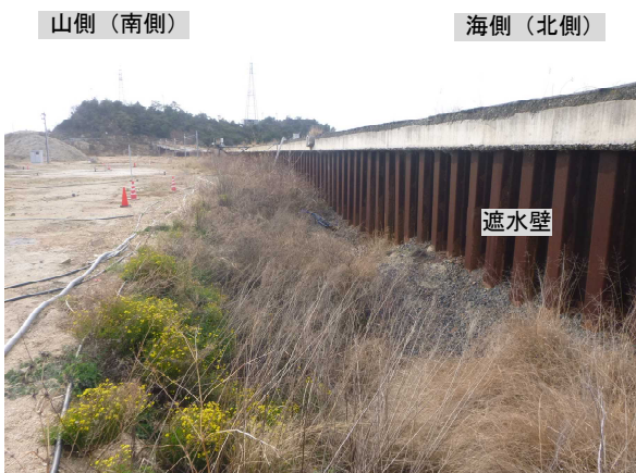
写真5 遮水壁処分地側（中央から西向き）
