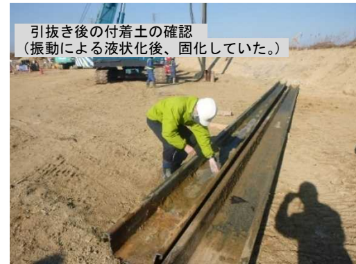
写真4 引抜き後の確認状況2 (バイブロハンマ)
