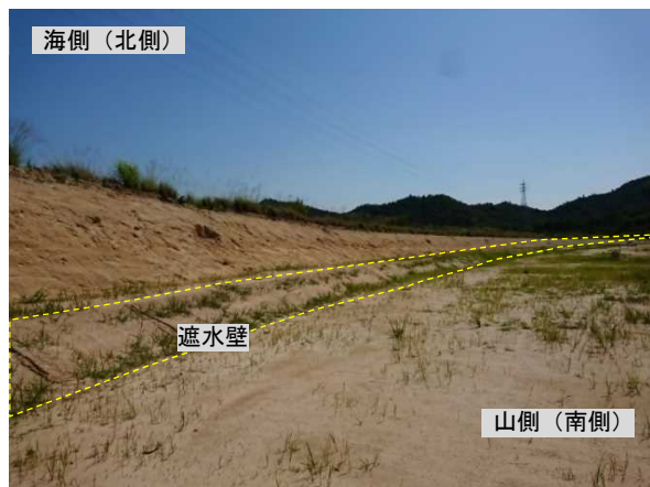
写真 42 北海岸土堰堤の全景（中央から東向き）
