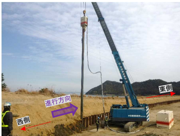
写真 25 バイブロハンマによる引抜き状況 1
