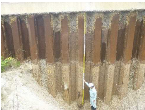
写真7 トレンチドレーン（試掘時の状況）
