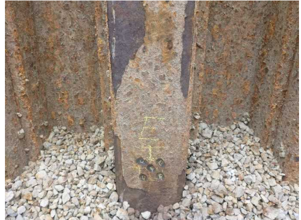
写真10 肉厚測定箇所-研磨後 (E 測線付近)
