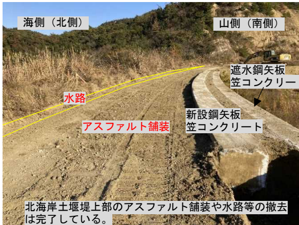
写真 17 A s 舗装等の撤去後の状況（詳細）
