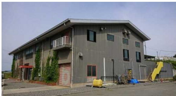
写真1 高度排水処理施設（近景）
