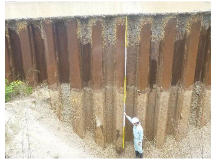
写真2 トレンチドレーン (試掘時の状況)
