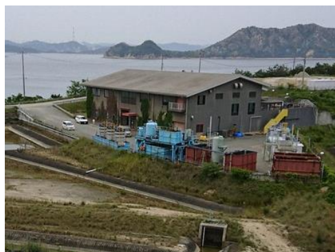
写真2 高度排水施設周辺部
