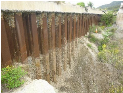
写真1 トレンチドレーン
