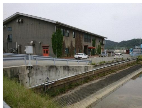
写真4 L型コンクリート擁壁
