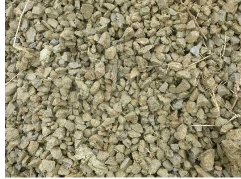
写真2 東側の試掘時の状況(近景)
