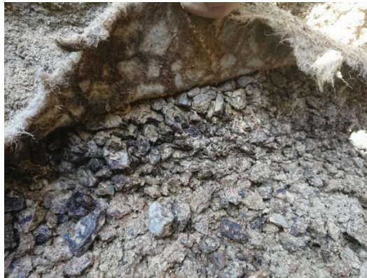
写真1 (参考) 承水路下トレンチドレーン碎石(令和3年4月)
