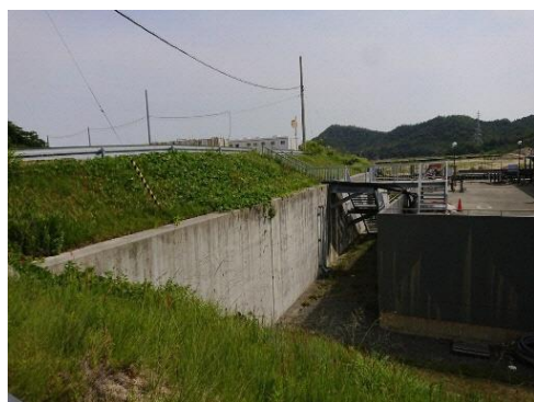
写真3 逆Tコンクリート擁壁
