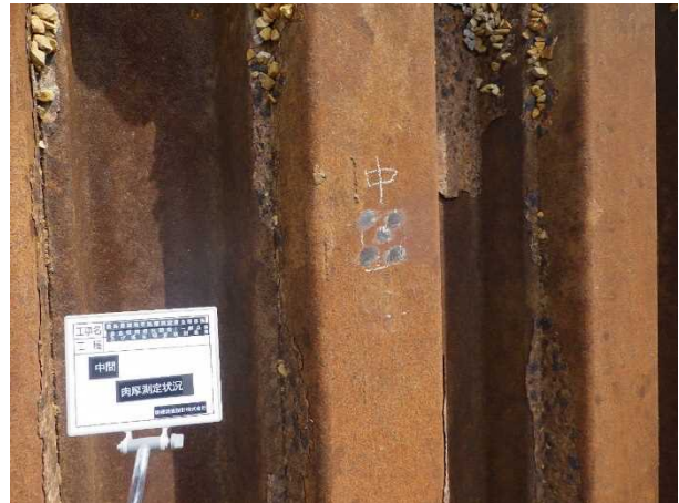
写真 4 肉厚測定箇所-研磨後 (中間)
