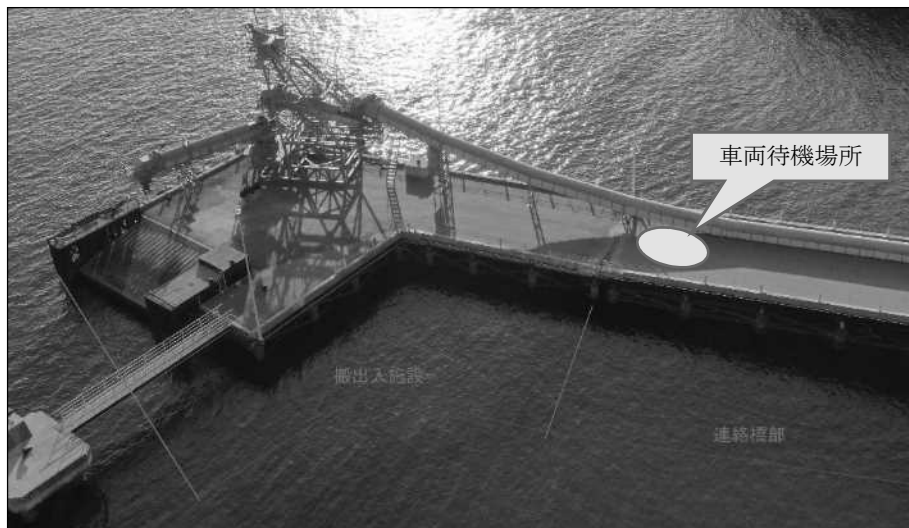
写真1 専用棧橋利用時の車両待機場所
