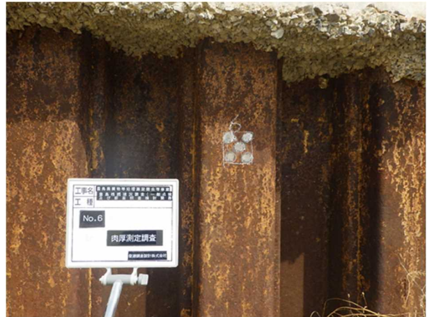
写真 2 肉厚測定箇所-研磨後 (No. 6)
