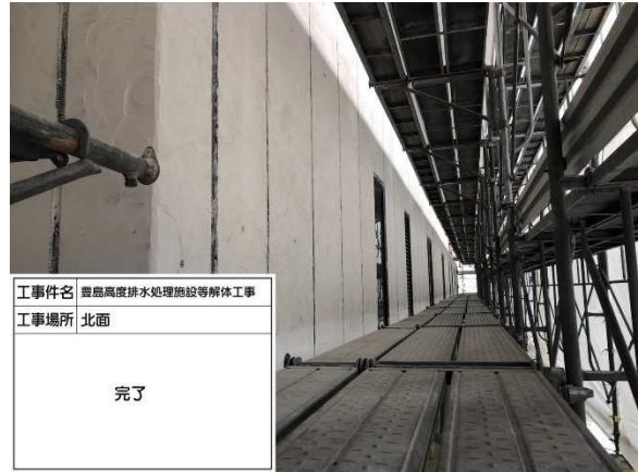
外壁完了状況
