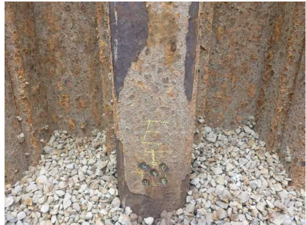
写真10 肉厚測定箇所-研磨後 (E 測線付近)
