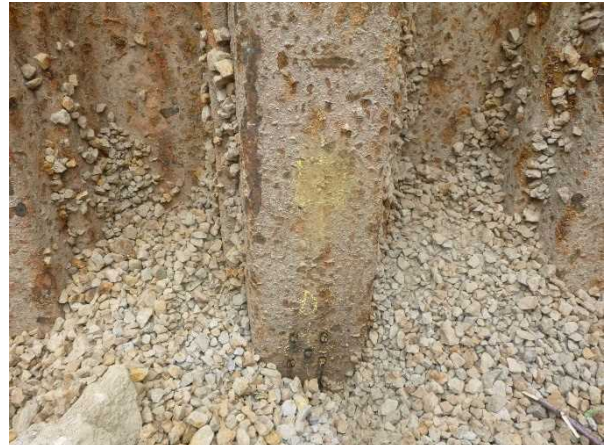
写真8 肉厚測定箇所-研磨後 (D 測線付近)
