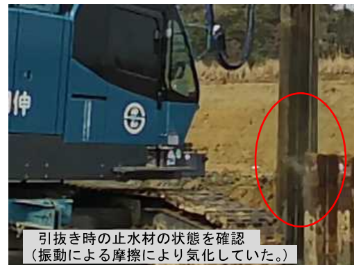
写真5 引抜き時の止水材の気化状況
