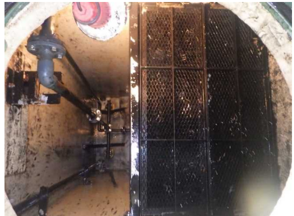
洗浄後 写真 16 再ばっ気槽
