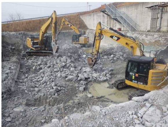
底盤解体状況
