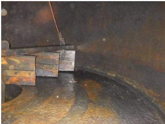
洗淨後 写真 11 凝集沈殿槽
