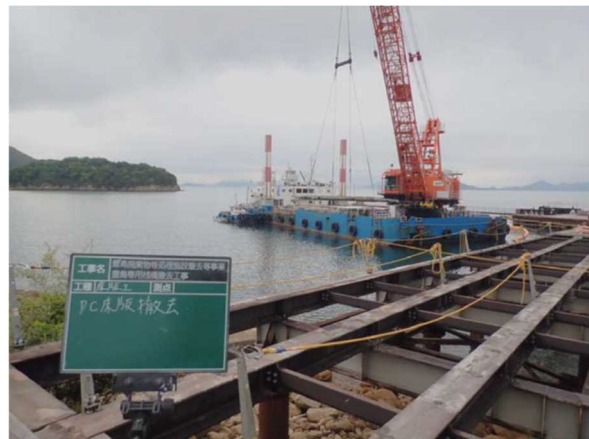
PC床版撤去状況 (遠景)
