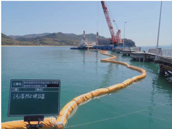
汚濁防止膜設置状況 (ドルフィン部)
