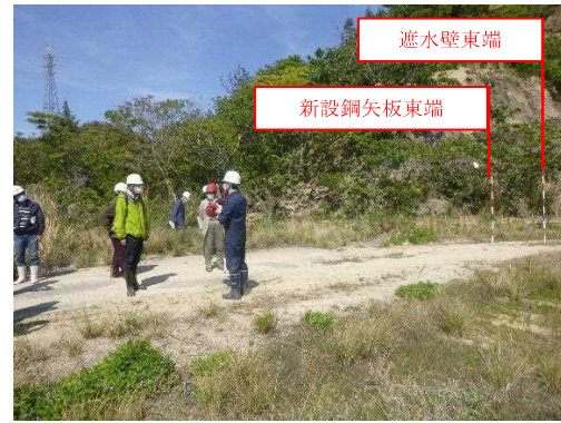
写真4 遮水壁東端部
