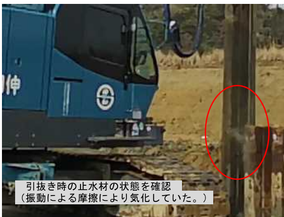
写真 31 引抜き時の止水材の気化状況
