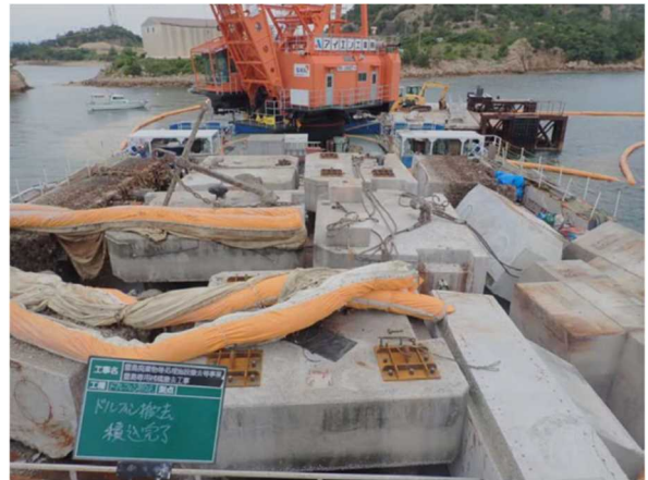
ドルフィン積込状況 (起重機船内)
