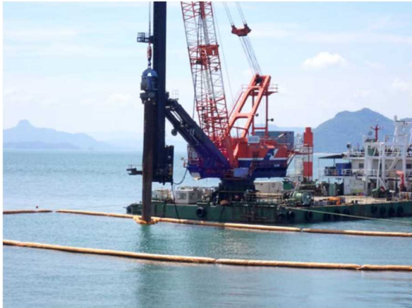
鋼管杭外周掘削状況 (ケーシング及びウォータージェット、遠景)
