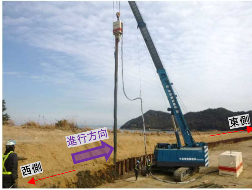
写真1 バイブロハンマによる引抜き状況
