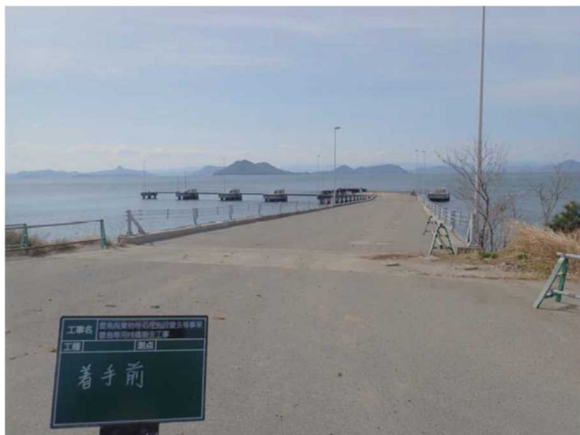
豊島専用棧橋撤去前 (陸側から撮影 1)
