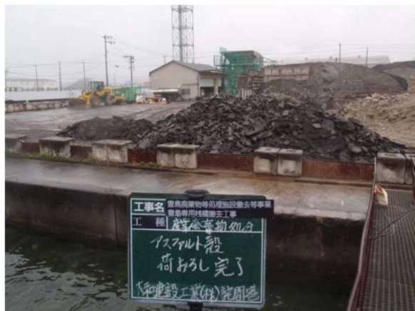
床版撤去 アスファルト塊荷下し後
