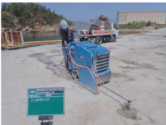
コンクリート切断状況 (コンクリートカッター)
