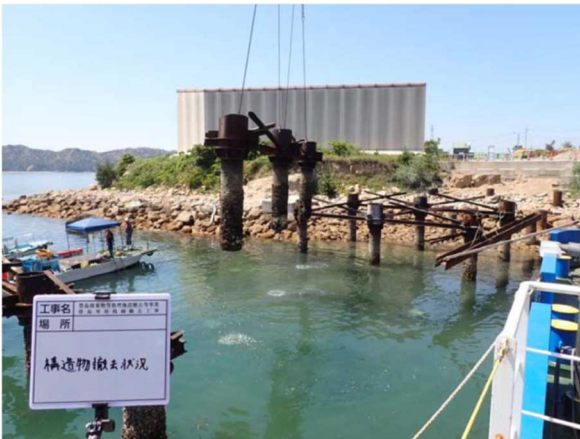
鋼材撤去状況 (橋脚部)
