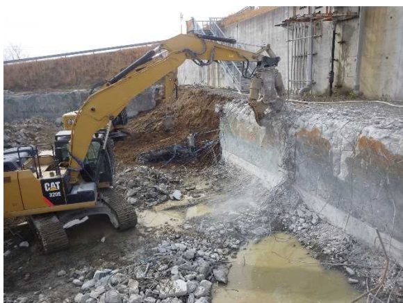
水槽部外部壁解体状況
