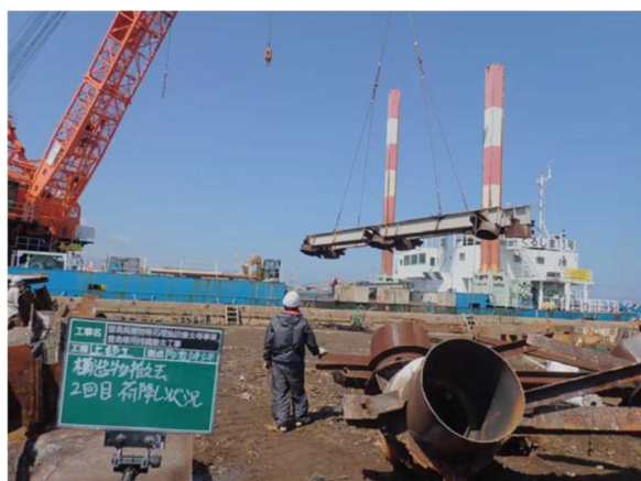
栈橋上部鋼材撤去 荷下し
