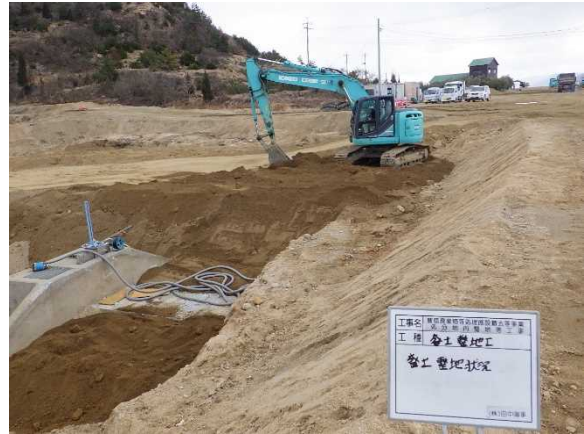
導水管呑口部付近の整地状況
