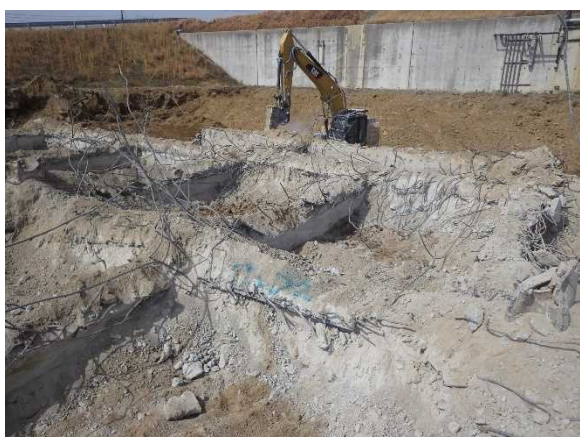
基礎解体状況
