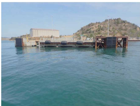
豊島専用棧橋撤去前 (海側から撮影)
