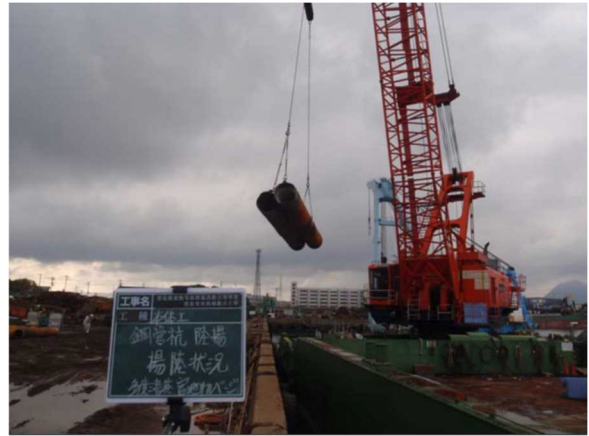
鋼管杭撤去 荷下し
