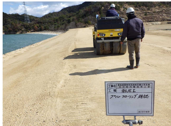
北海岸土堰堤付近の転圧状況
