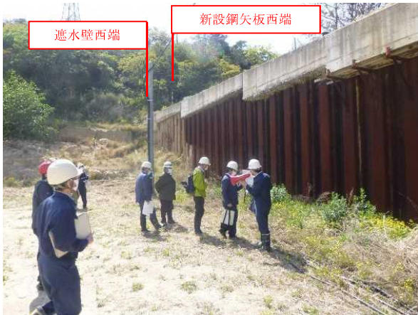
写真11 遮水壁西端部
