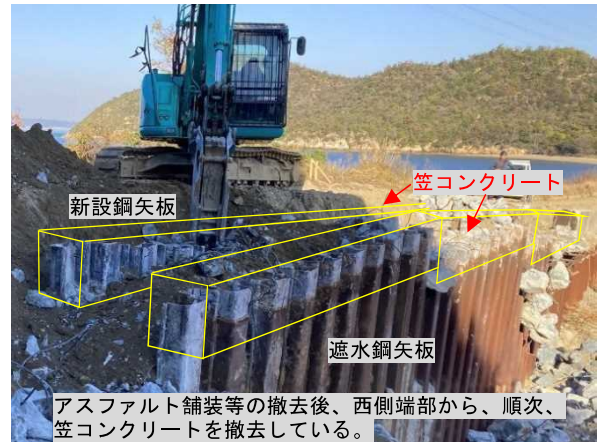
写真 18 笠コンクリートの撤去状況
