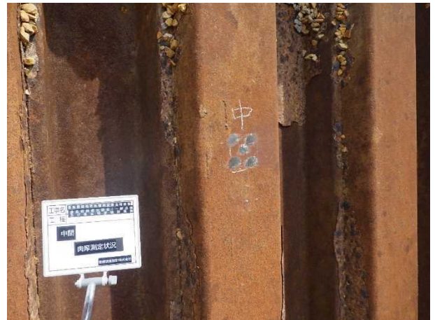
写真 4 肉厚測定箇所-研磨後 (中間)
