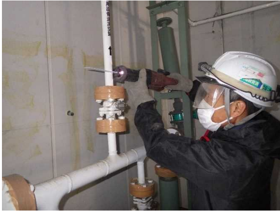
フランジガスケット前後の切断状況
