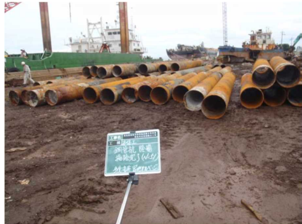
鋼管杭撤去 荷下し後
