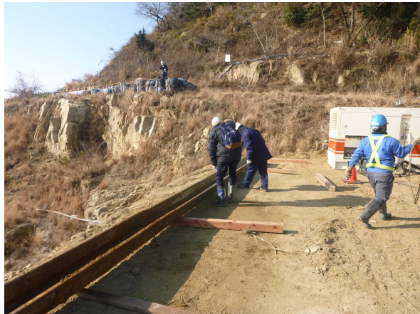
写真 34 松島委員立会状況（鋼矢板の状況）
