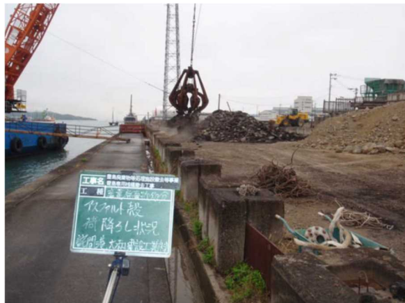
床版撤去 アスファルト塊荷下し
