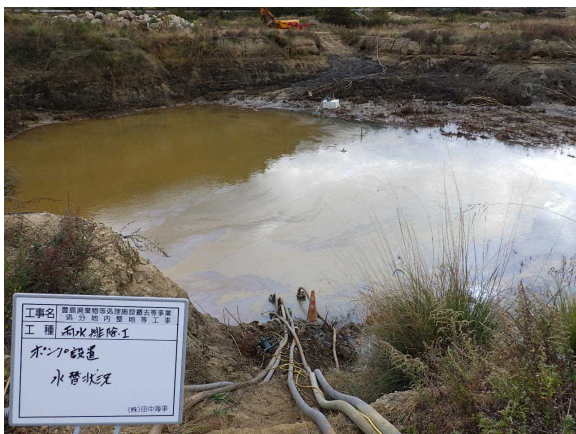
水替え状況（区画⑨）
