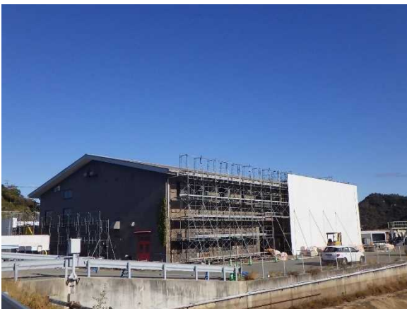
足場・シート張り（南側から撮影）
