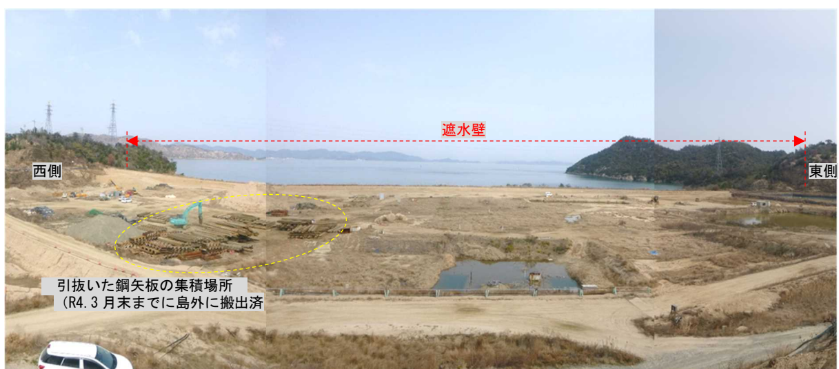
写真2 引抜き後の処分地内の状況 (令和4年3月17日)
