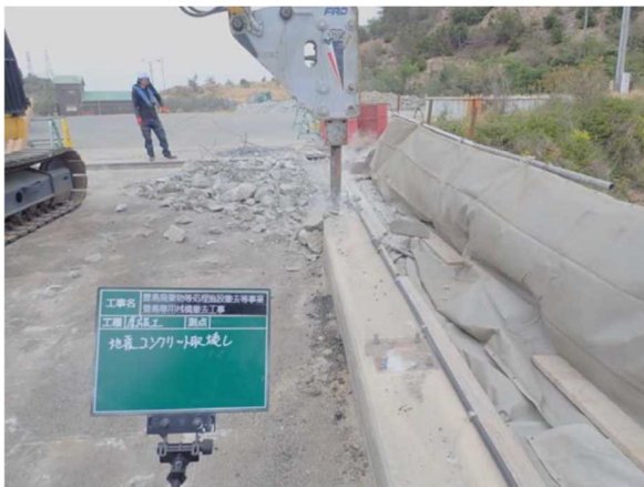
コンクリート粉碎状況
