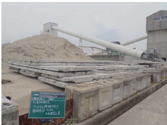
床版撤去 荷下し後
