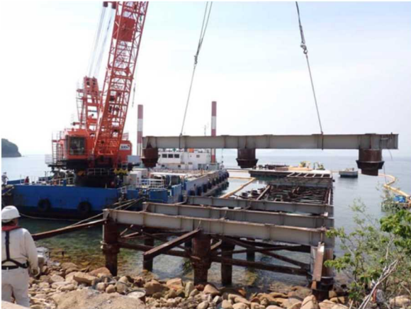
鋼材撤去状況 (桁部)
