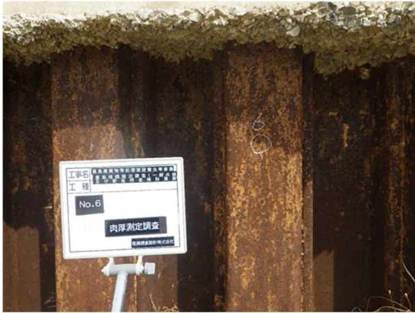
写真 1 肉厚測定箇所-研磨前 (No. 6)
