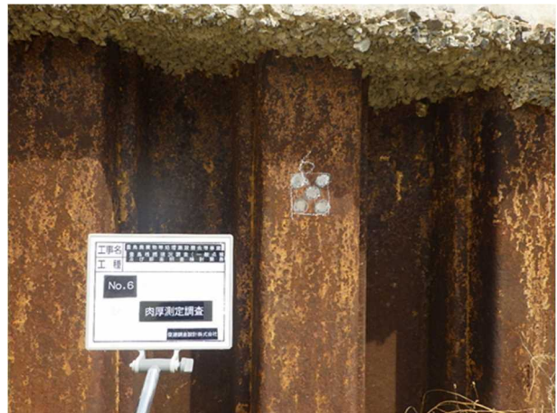
写真 2 肉厚測定箇所-研磨後 (No. 6)
