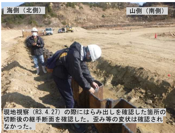
写真 35 松島委員立会状況（接手部の確認）
