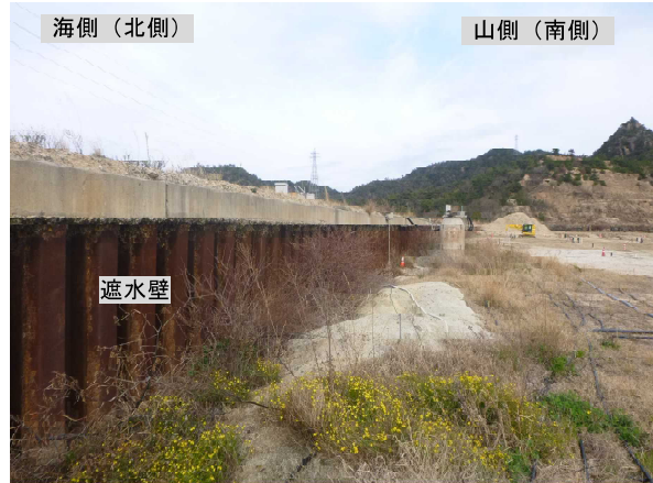
写真6 遮水壁処分地側（中央から東向き）
