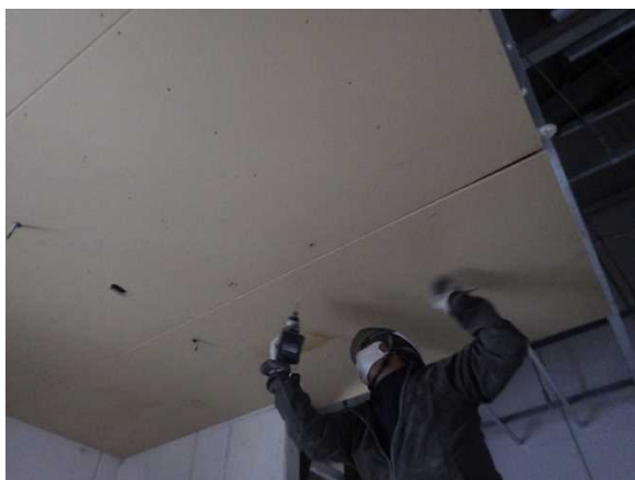
天井ボード撤去状況
