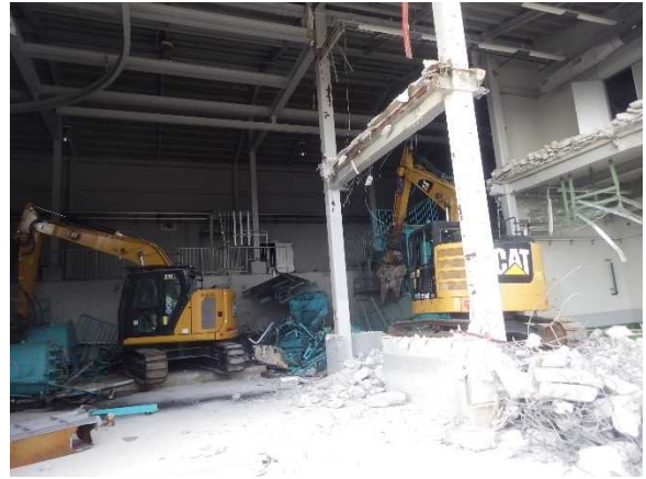
躯体内部解体状況
