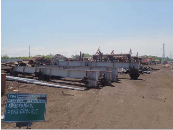
橋橋上部鋼材撤去 荷下し後
