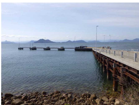
豊島専用棧橋撤去前 (陸側から撮影 2)
