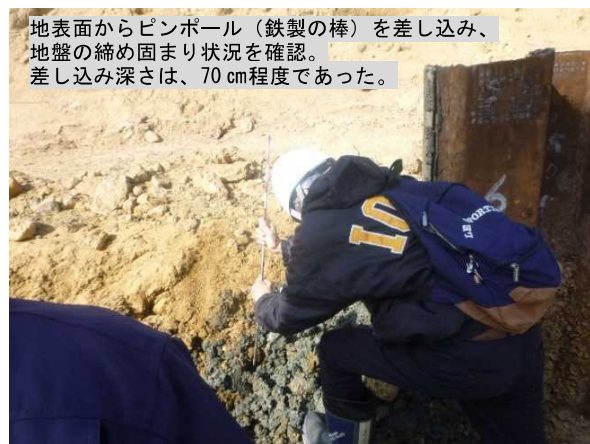
写真 36 松島委員立会状況（引抜き跡）
