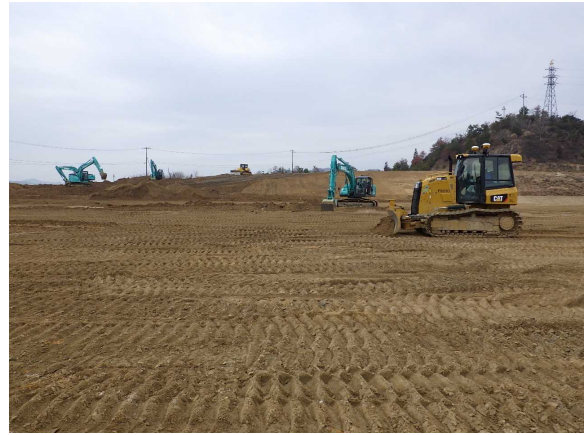
処分地内の整地状況
