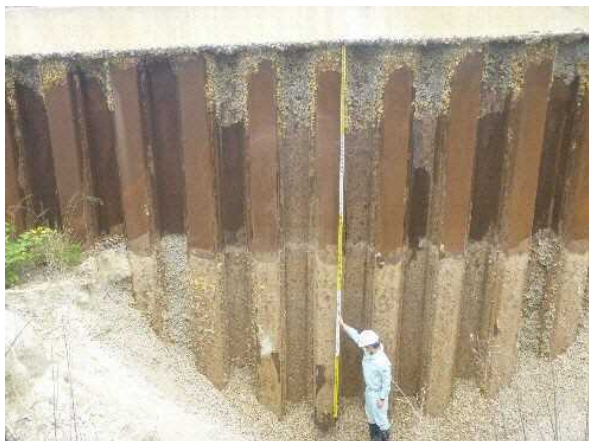
写真7 トレンチドレーン（試掘時の状況）
