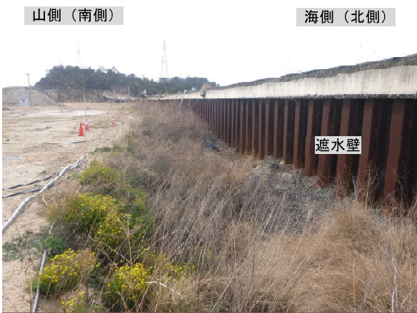
写真5 遮水壁処分地側（中央から西向き）
