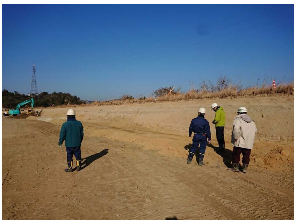
写真 38 松島委員立会状況（引抜き後の状況）
