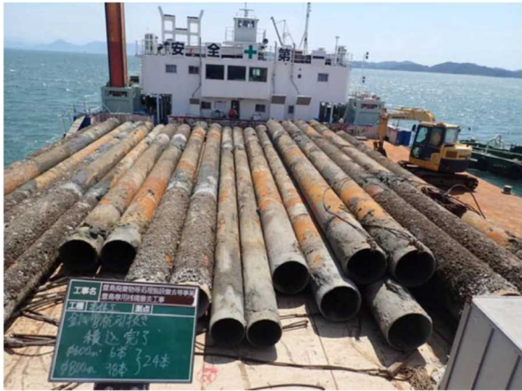
鋼管杭積込状況 (起重機船内)
