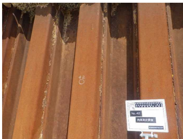
写真 5 肉厚測定箇所-研磨前 (No. 42)
