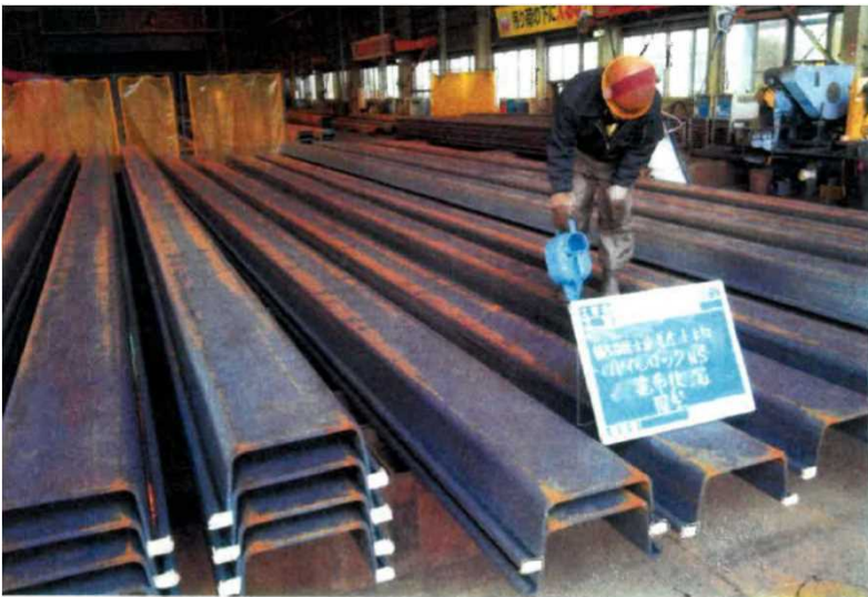
鋼矢板への止水材塗布状況【H27北海道トレンチドレーン撤去及び仮設矢板設置工事（第1工区）】
