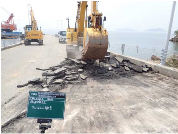
アスファルト粉碎状況
