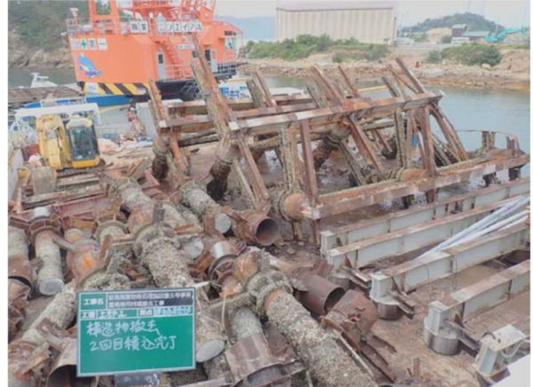
鋼材積込状況 (起重機船内)
