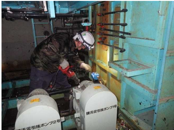
屋内設備撤去状況
