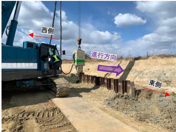
写真 27 バイブロハンマによる引抜き状況 3
