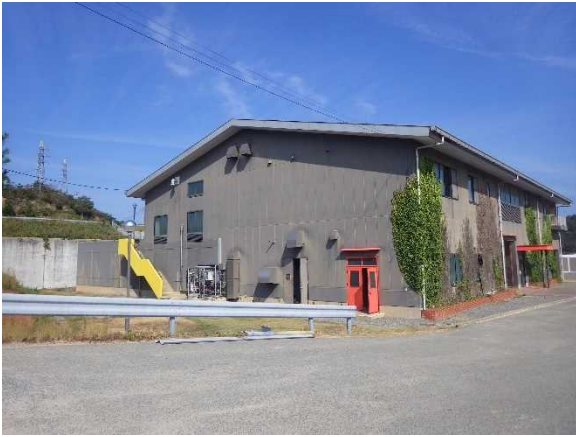
建屋解体前（南側から撮影）
