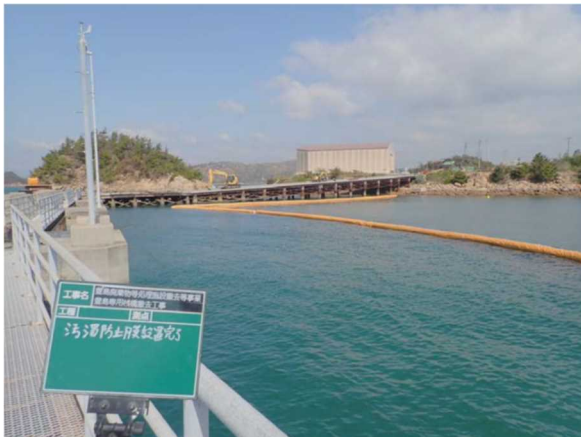
汚濁防止膜設置状況 (東側)
