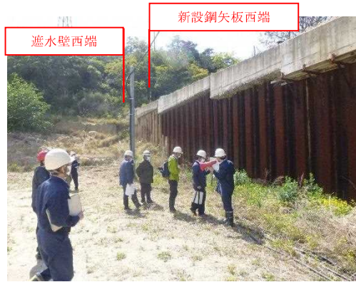
写真3 遮水壁西端部
