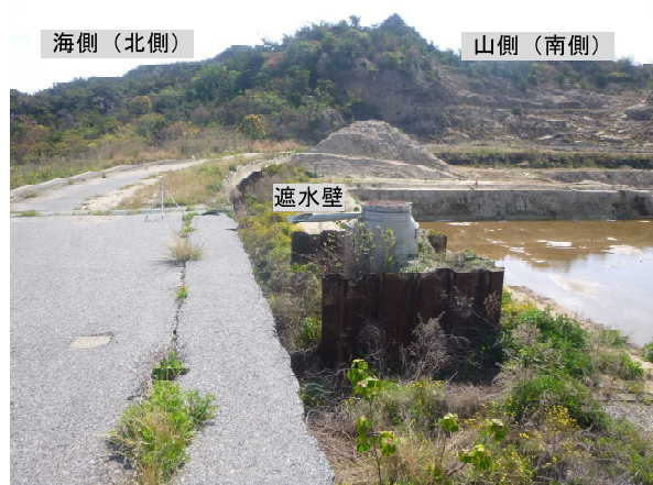
写真4 遮水壁上部（中央から東向き）
