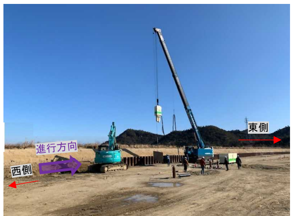
写真 26 バイブロハンマによる引抜き状況 2
