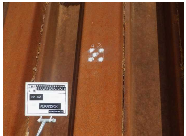
写真 6 肉厚測定箇所-研磨後 (No. 42)
