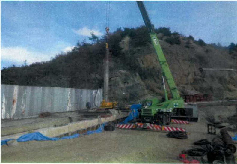
ダウンザホールハンマによる先行掘削状況【H27北海道トレンチドレーン撤去及び仮設矢板設置工事（第1工区）】
