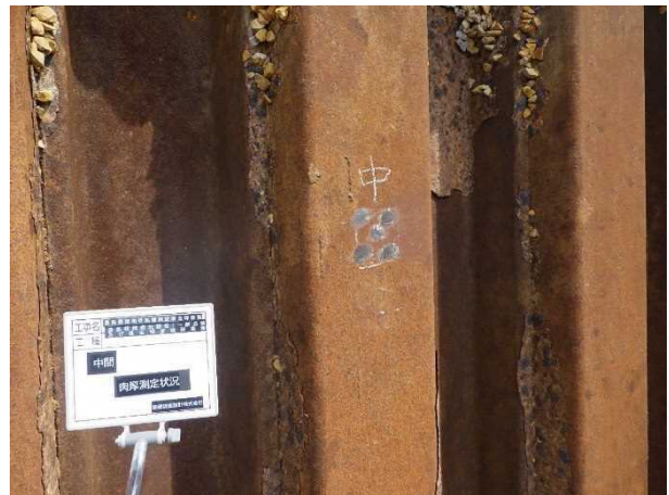
写真 4 肉厚測定箇所-研磨後 (中間)
