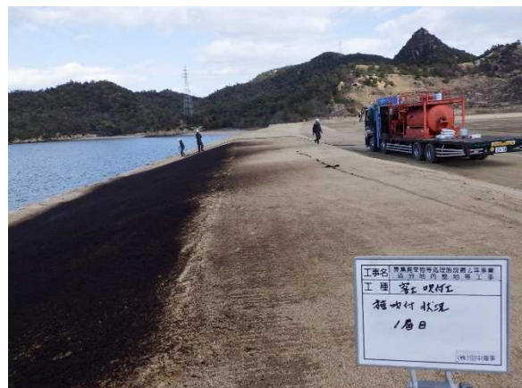
北海岸土堰堤付近の吹付状況
