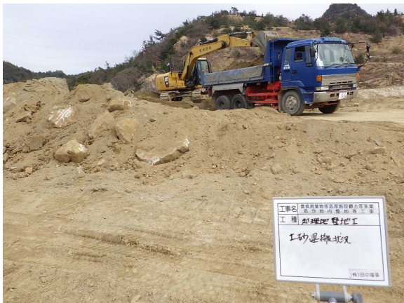
処分地内土砂の積込み・運搬状況（その2）
