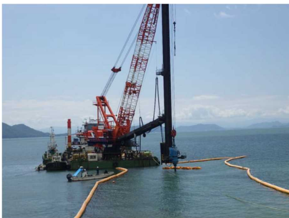
鋼管杭中掘削状況 (アースオーガ、遠景)
