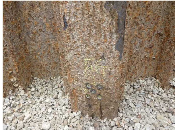
写真12 肉厚測定箇所-研磨後 (FG 中間付近)
