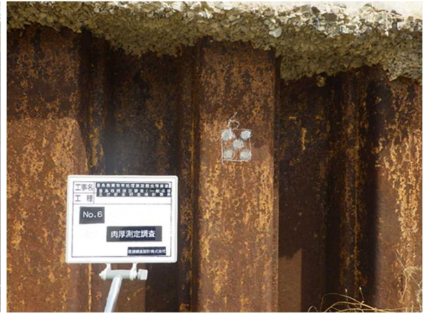
写真 2 肉厚測定箇所-研磨後 (No. 6)
