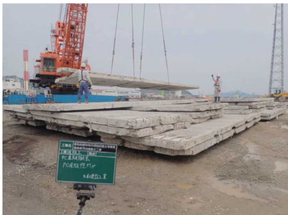
床版撤去 荷下し
