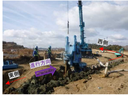
写真2 油圧圧入引抜機による引抜き状況
