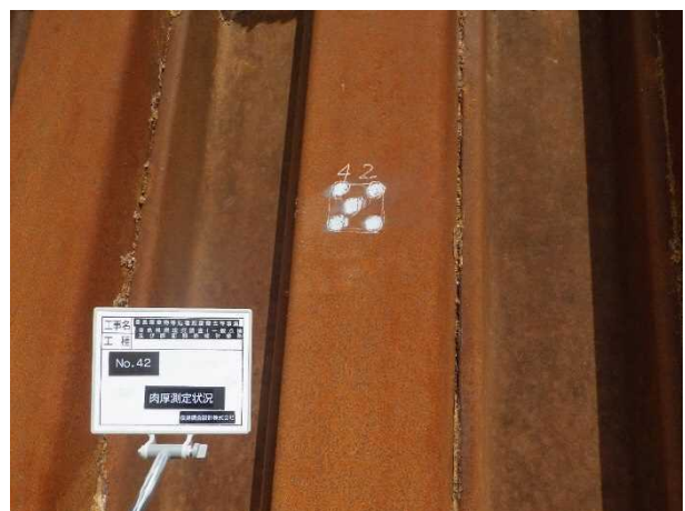
写真 6 肉厚測定箇所-研磨後 (No. 42)
