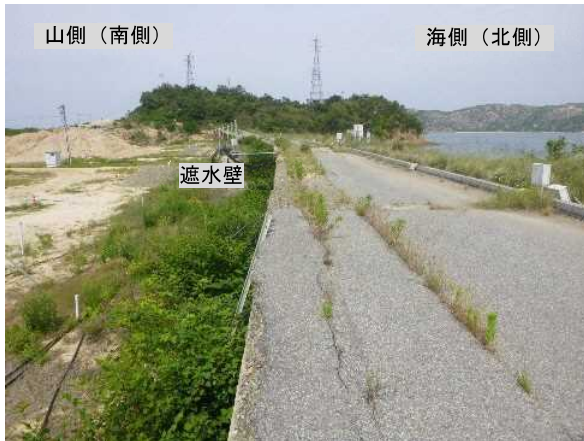
写真3 遮水壁上部（中央から西向き）
