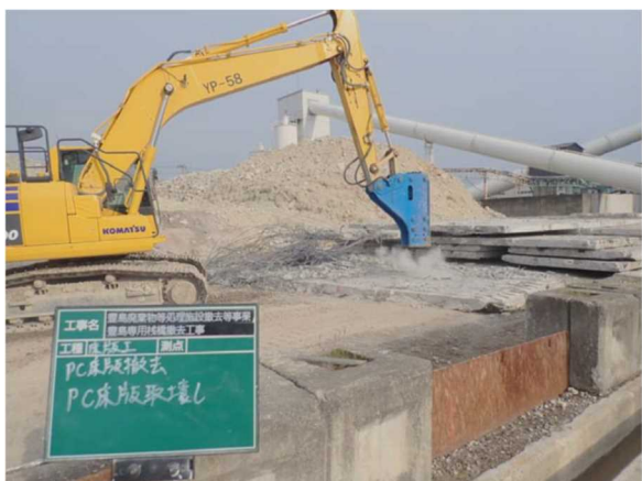
床版撤去 コンクリート破碎状況
