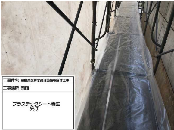
外壁シート養生状況
