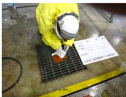
写真2 拭き取り実施中
