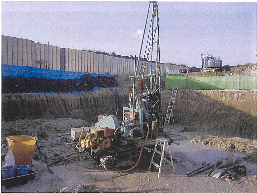
写真3 観測井 No. 2 掘削状況
