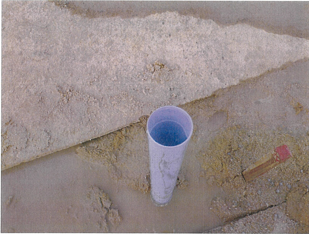
写真9 観測井 No. 2 最上部地下水
