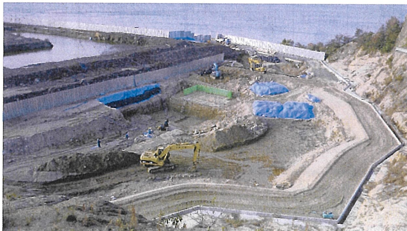
写真 H測線東側掘削状況（H24.11.19）
