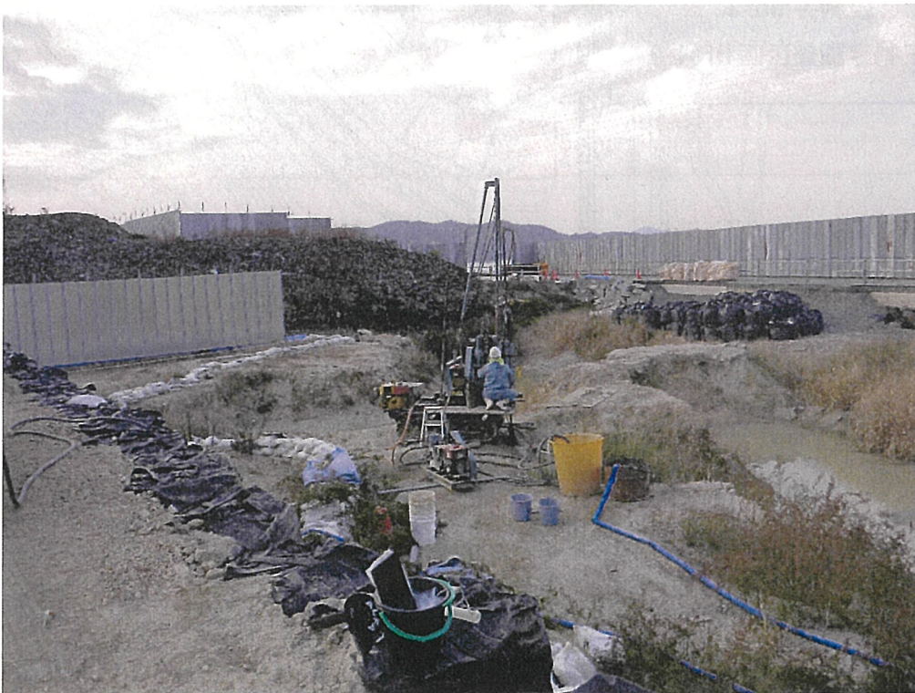
写真2 観測井 No.1 掘削状況
