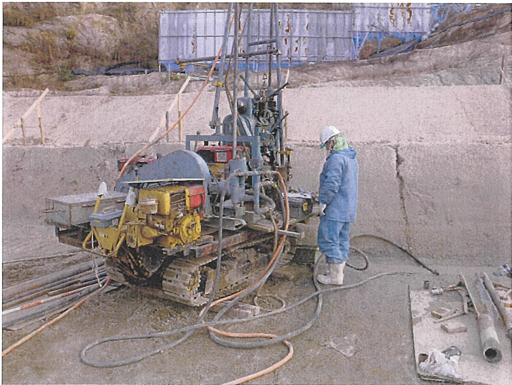
写真4 観測井 No. 3 掘削状況
