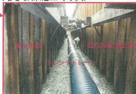
(暗きよ部施工時写真)
