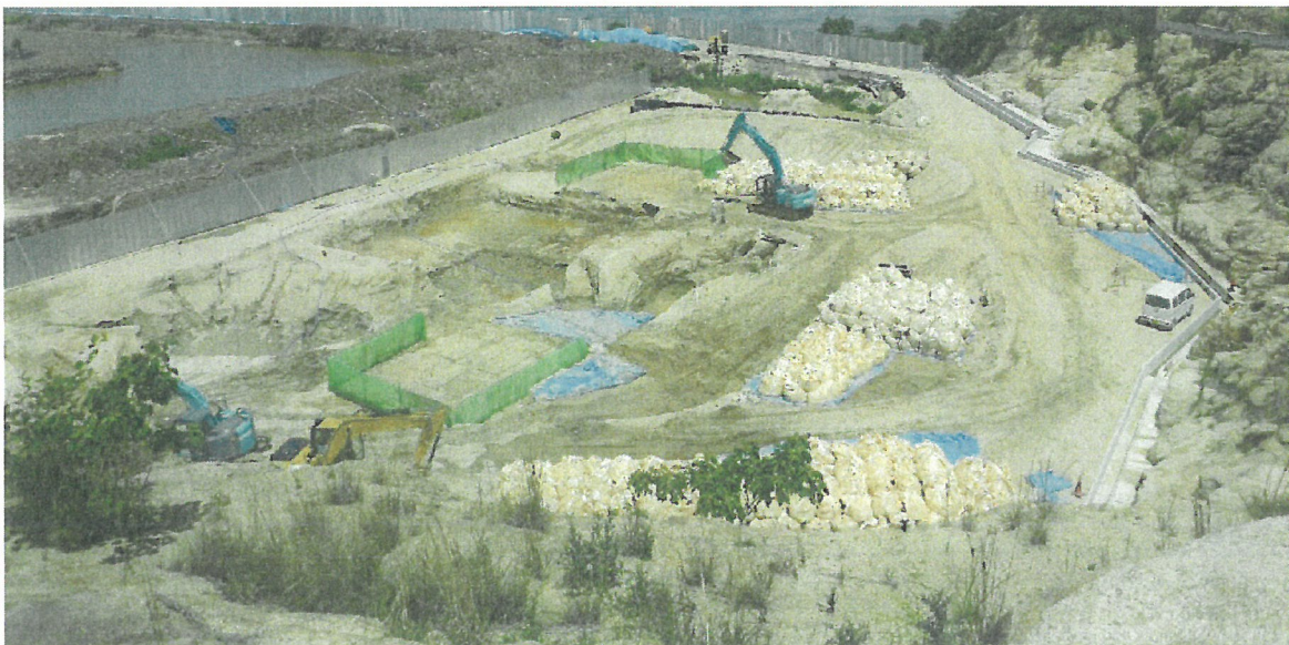
写真 H測線東側掘削状況(平成24年6月28日)
