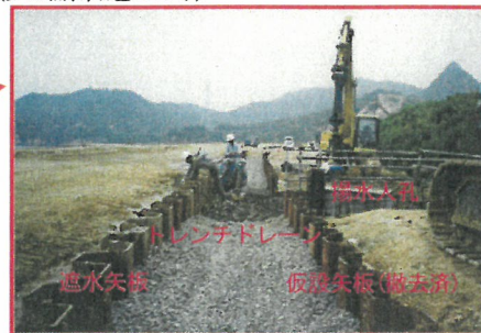
(天端部施工時)
