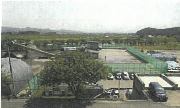
3. 受入れヤード及び防塵ネット
