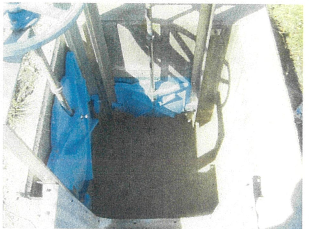
写真8 切替水門清掃後
