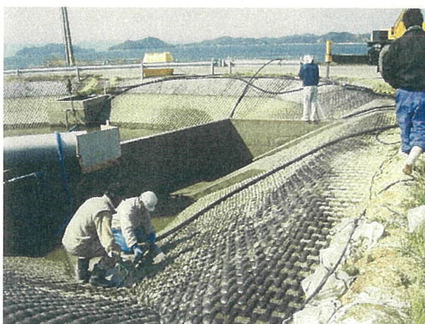
写真4 初期雨水貯留槽清掃
