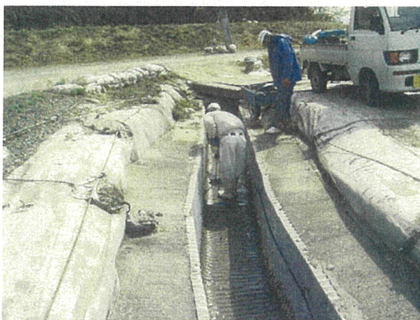
写真1 第4工区雨水排水路清掃
