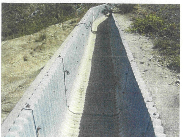
写真10 第4工区雨水排水路清掃後
