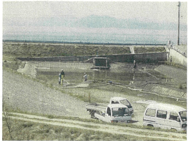
写真 12 沈砂池 1 清掃
