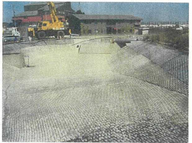
写真6 沈砂池2清掃後
