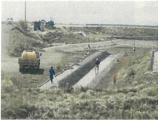
写真 11 沈砂池 1 清掃
