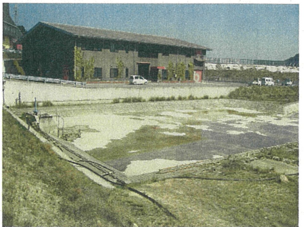
写真 15 沈砂池 1 清掃後
