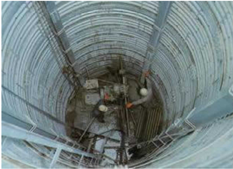
写真1 集水井内部及び集水ボーリング施工状況（参考）
