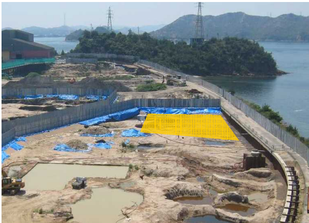
写真1 (F,1) 付近の底面掘削完了の確認
