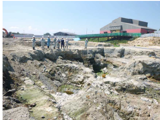
写真 14 底面掘削完了確認の様子 (H28.8.8)
