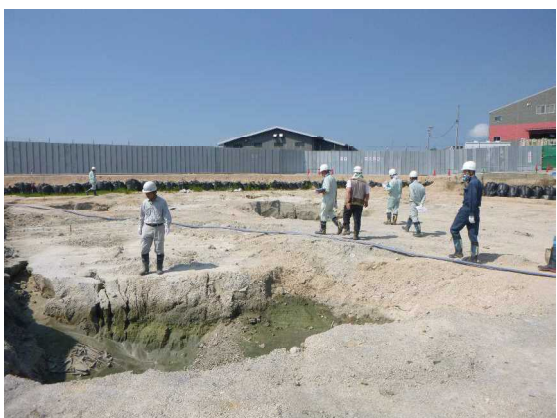
写真 15 底面掘削完了確認の様子 (H28.7.6)
