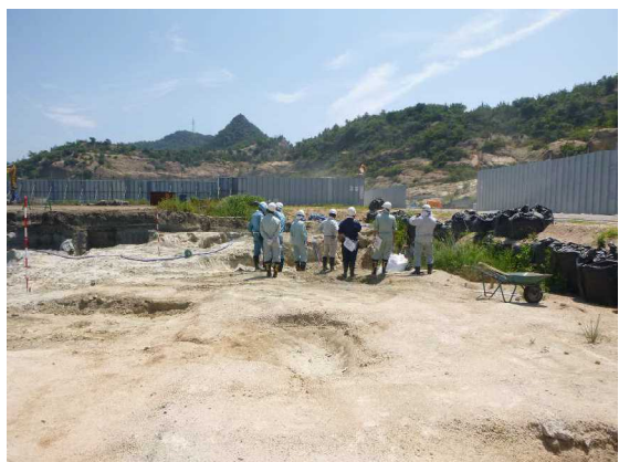
写真 16 底面掘削完了確認の様子 (H28.8.8)
