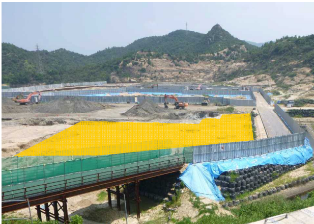
写真3 (C-D,3-4) 付近の底面掘削完了の確認
