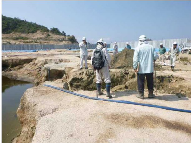
写真 19 BH 掘削確認の様子 (①)
