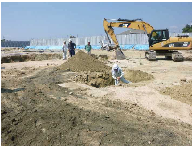
写真 28 再探査実施状況 (②)
