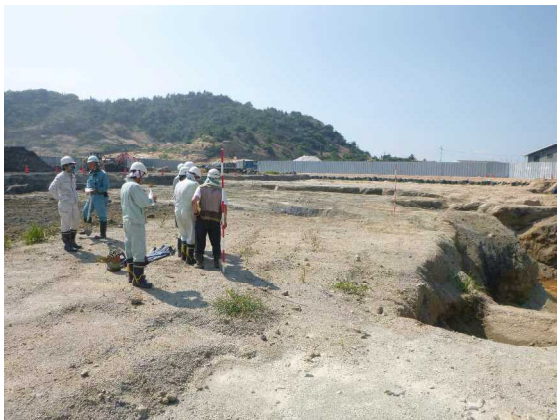
写真 11 底面掘削完了確認の様子 (H28.7.6)
