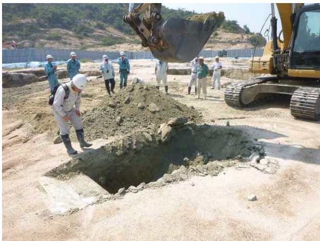
写真 23 BH 掘削確認の様子 (③)
