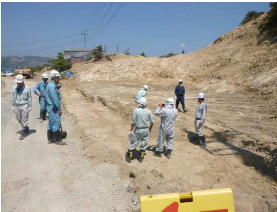
写真 18 黒色物質除去確認の様子 (H28. 8. 8)
