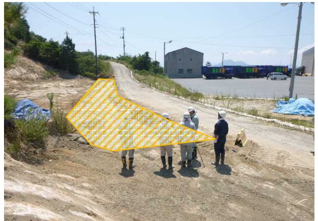
写真4 進入路下の黒色物質除去確認
