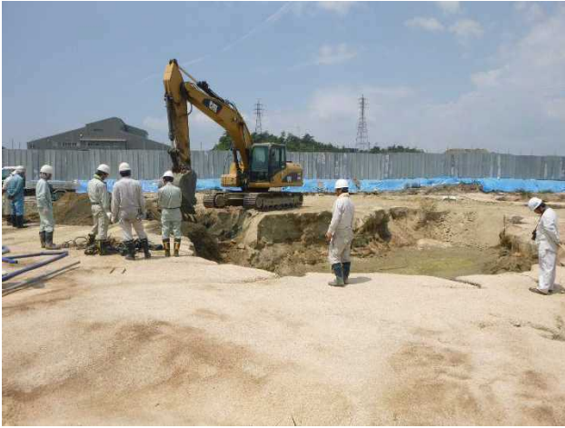
写真 25 BH 掘削確認の様子 (④)
