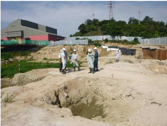
写真7 底面掘削完了確認の様子 (H28. 7. 6)
