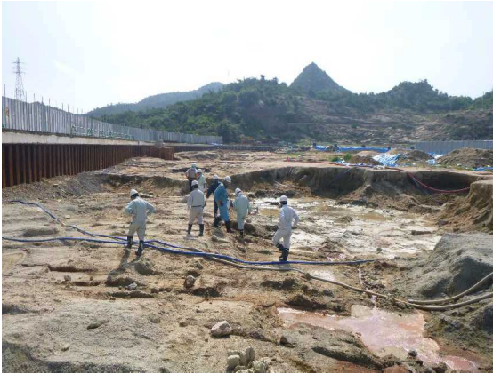
写真5 底面掘削完了確認の様子 (H28. 7. 6)
