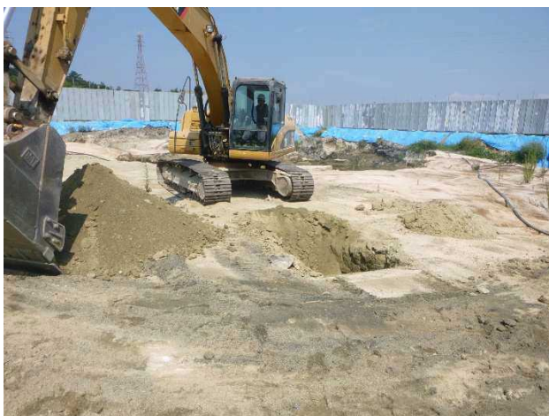
写真 21 BH 掘削確認の様子 (②)
