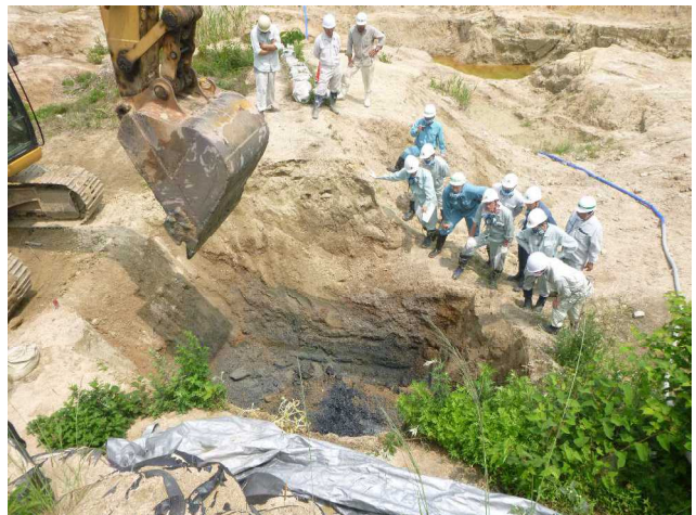
写真6 底面掘削完了確認の様子（H28.5.27）
