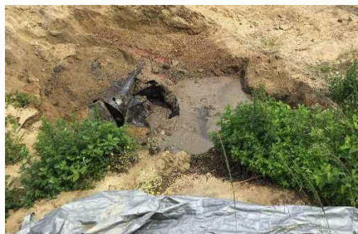
写真3 ドラム缶埋設状況
