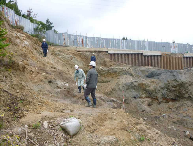
写真3 掘削完了判定の様子（H28.4.28）
