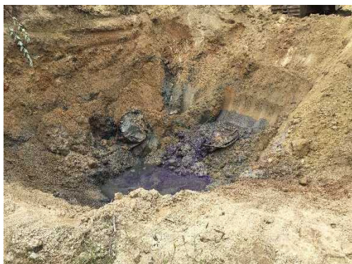
写真4 ドラム缶埋設状況
