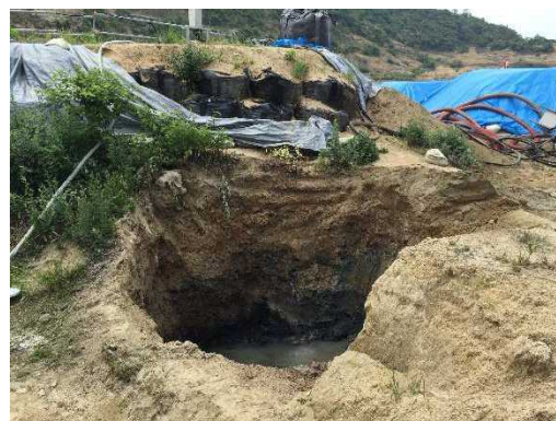
写真5 掘削除去後（たまり水は湧水）
