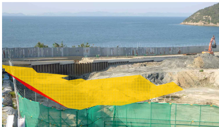
写真1 (B-C, 2) 付近の掘削完了判定等の実施
