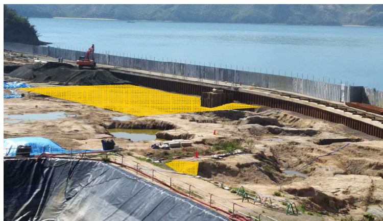
写真2 (G, 1)、(H+20, 1+30) 付近の底面掘削完了の確認
