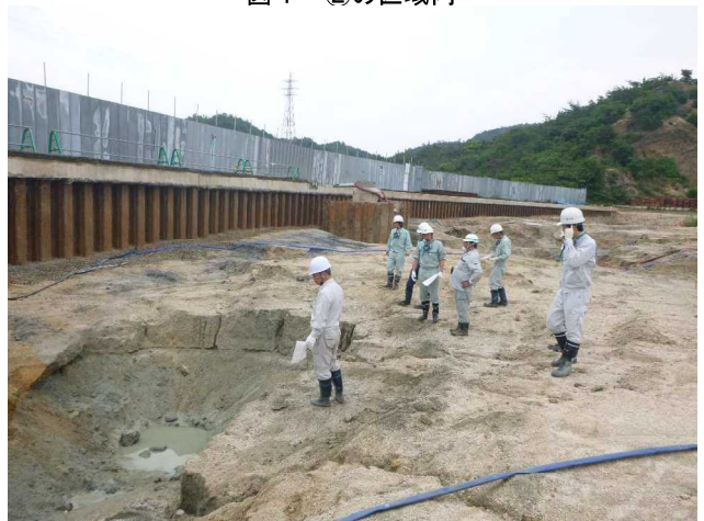
写真5 底面掘削完了確認の様子（H28.5.27）
