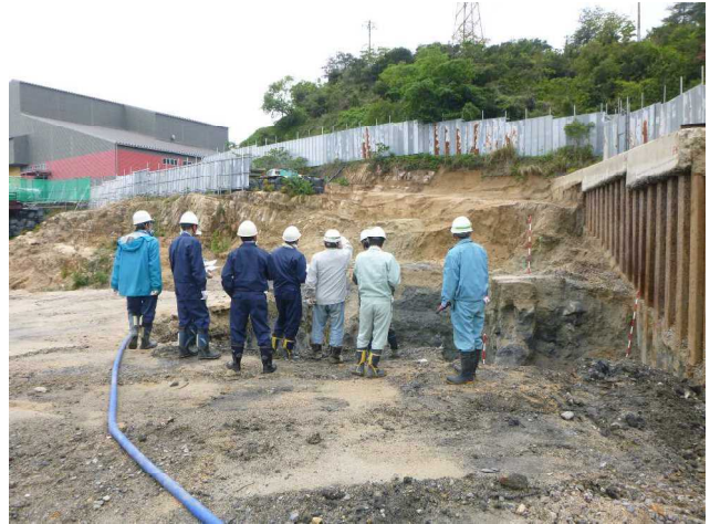
写真4 底面掘削完了確認の様子（H28.4.28）
