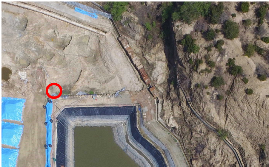
写真1 電磁法探査でドラム缶が見つかった地点
