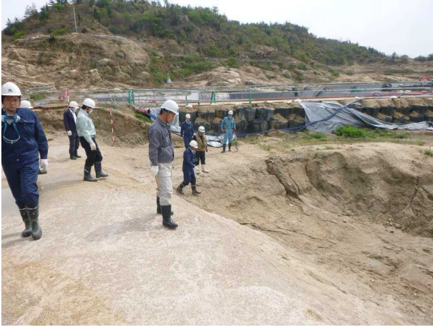
写真2 掘削完了判定の様子 (H28.4.8)
