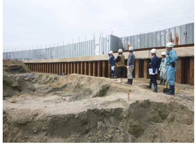
写真3 底面掘削完了確認の様子 (H28.4.8)
