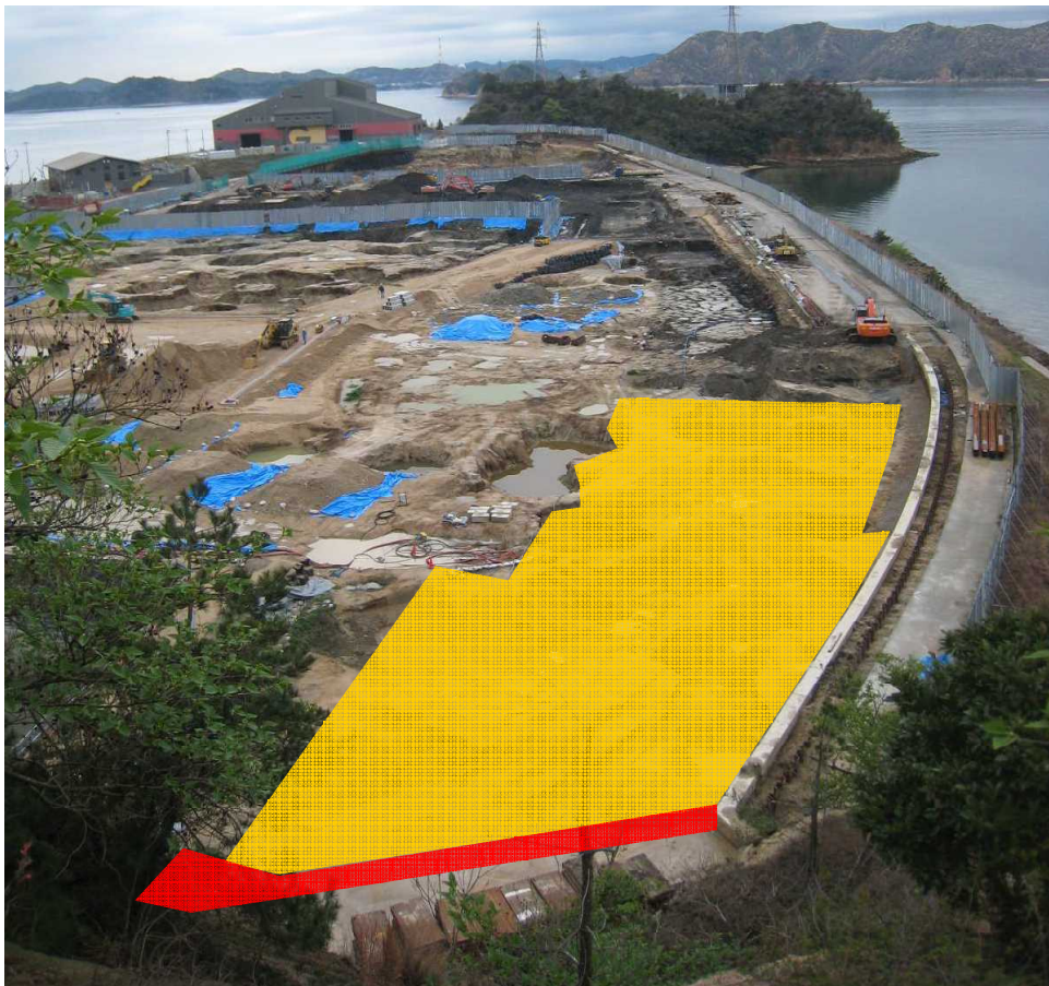
写真1 (H-I, 1) 付近の掘削完了判定等の実施
