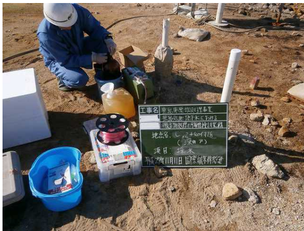
フィールドポンプによる採水状況
