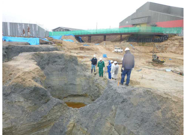
写真8 底面掘削完了確認の様子（H28.2.29）
