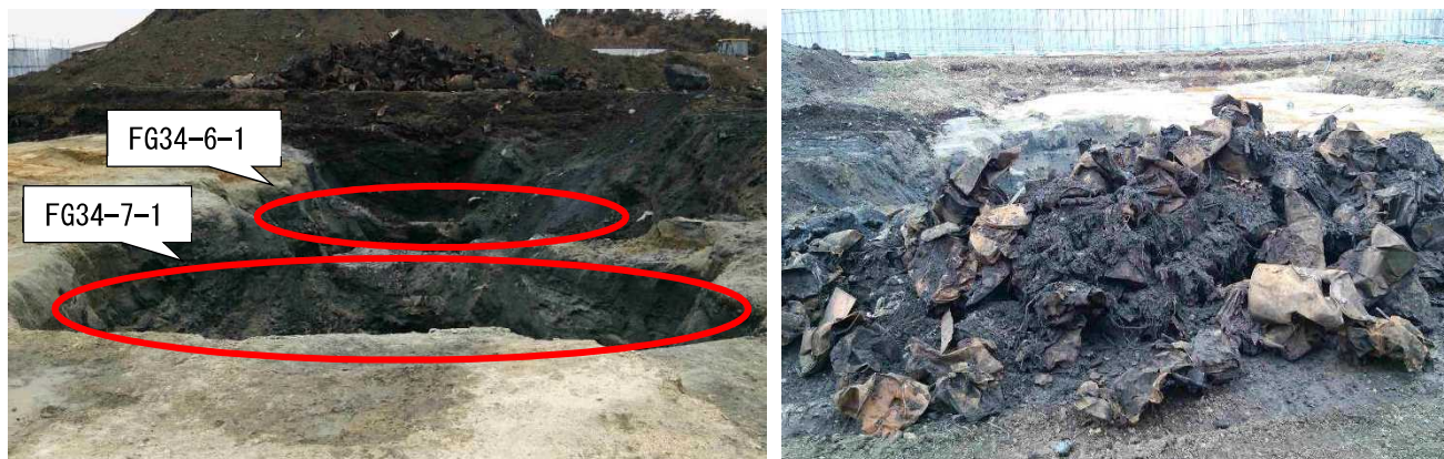
①掘削後の状況 (H27. 1. 29)
