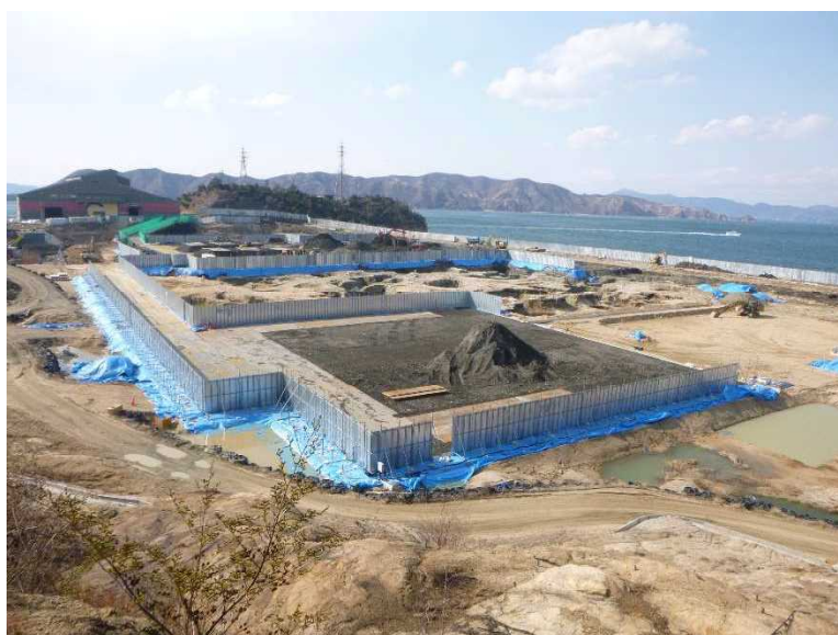
写真1 最終混合面の施工状況
