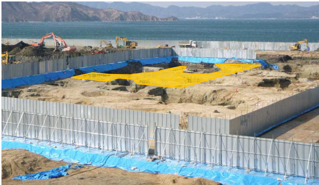
写真1 (E-F, 2-3) 付近の底面掘削完了の確認
