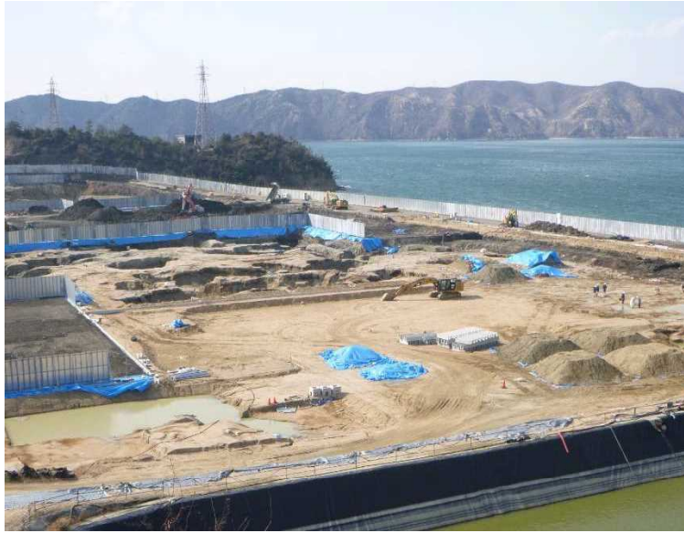
写真3 廃棄物仮置きヤード及び廃棄物搬入路の施工状況
