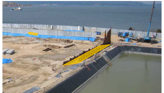
写真2 (H+15, 2) 付近の底面掘削完了の確認
