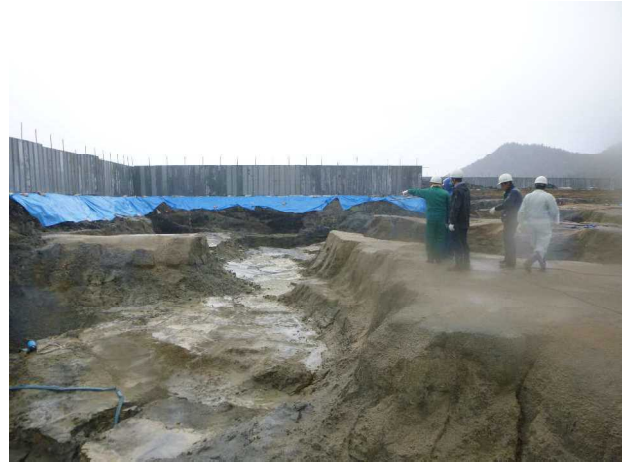
写真6 底面掘削完了確認の様子（H28.2.29）
