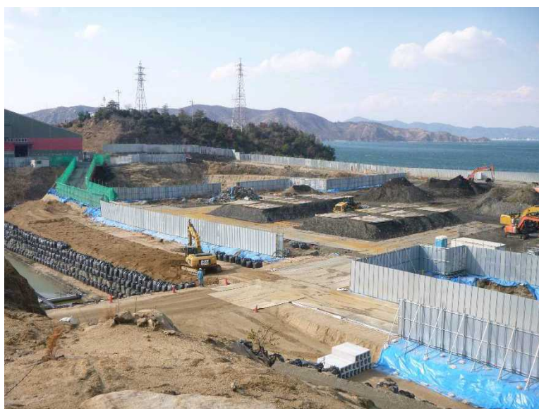
写真2 搬出道路の施工状況
