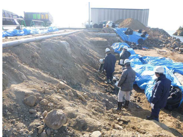
写真9 黒色物質撤去確認の様子 (H28.1.22)
