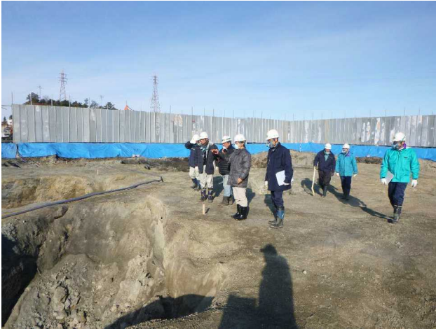
写真5 底面掘削完了確認の様子（H28.1.22）
