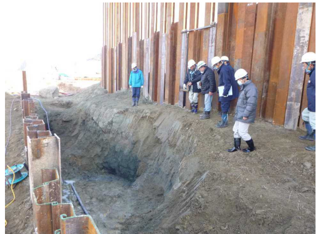
写真7 底面掘削完了確認の様子（H28.1.22）
