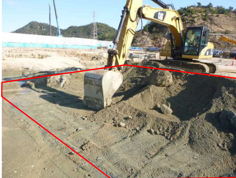
写真-1 範囲 B-1 の掘削状況
