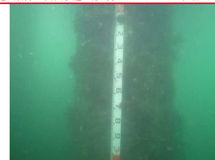
⑦ 鋼材の表面状態 (杭頭コンクリート・下端-2m～-3m)
