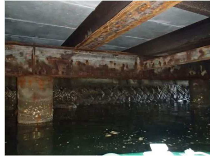
② 鋼材の表面状態
