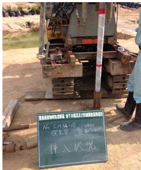
保孔管の挿入状況
