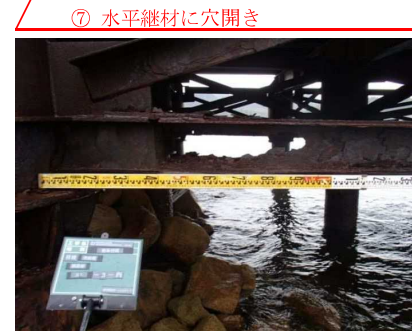
⑦ 水平継材に穴開き
