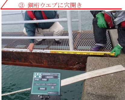
③ 鋼桁ウェブに穴開き
