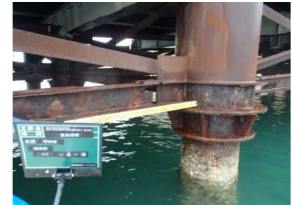
⑥ 水平継材に穴開き
