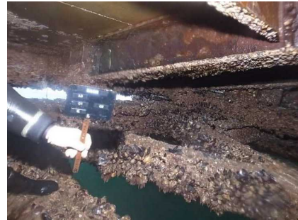
② 鋼材の表面状態
