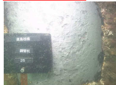
④ 付着物を除去した鋼材表面
