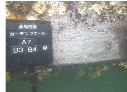
⑥ 鋼材の表面状態 (付着物除去)
