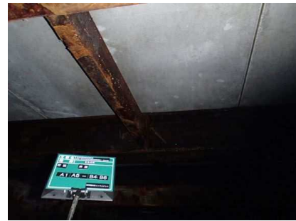
② PC床版の表面状態 (特に変状なし)
