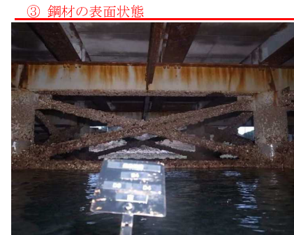
③ 鋼材の表面状態
