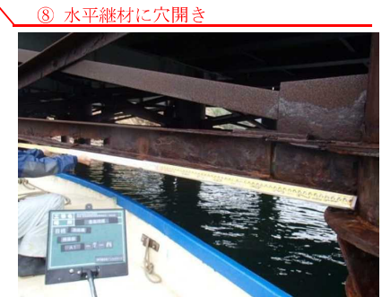
⑧ 水平継材に穴開き
