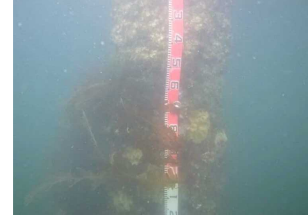
⑥ 鋼材の表面状態 (杭頭金物・下端1.3m~2m)
