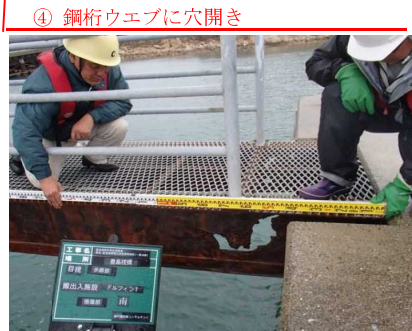
④ 鋼桁ウェブに穴開き
