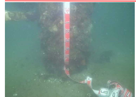
⑧ 鋼材の表面状態 (杭頭金物・下端3m~海底地盤面)
