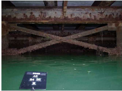
① 鋼材の表面状態
