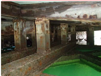
③ 鋼材の表面状態
