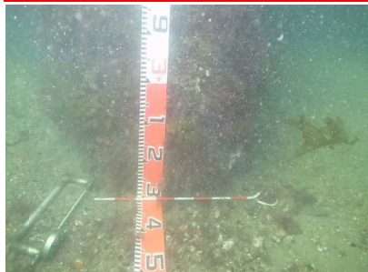
③ 鋼材の表面状態 (桁受・下端-3m～海底地盤面)
