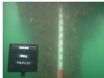
⑤ 鋼材の表面状態 (杭頭コンクリート・下端-1m)
