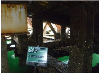
① 鋼材の表面状態
