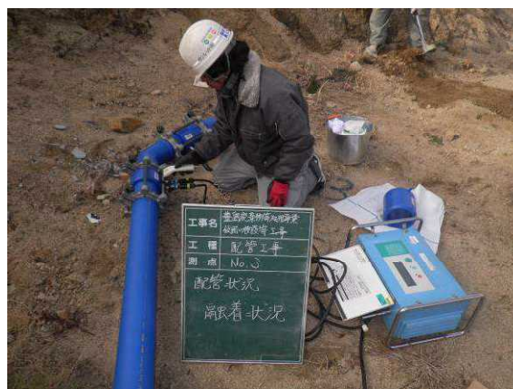
写真3 継手融着作業状況
