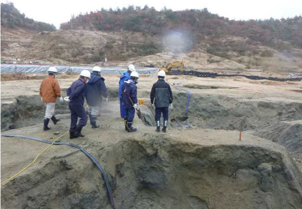
写真5 底面掘削完了確認の様子（H26.11.25）
