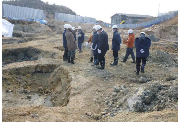
写真4 底面掘削完了確認の様子（H27.1.8）
