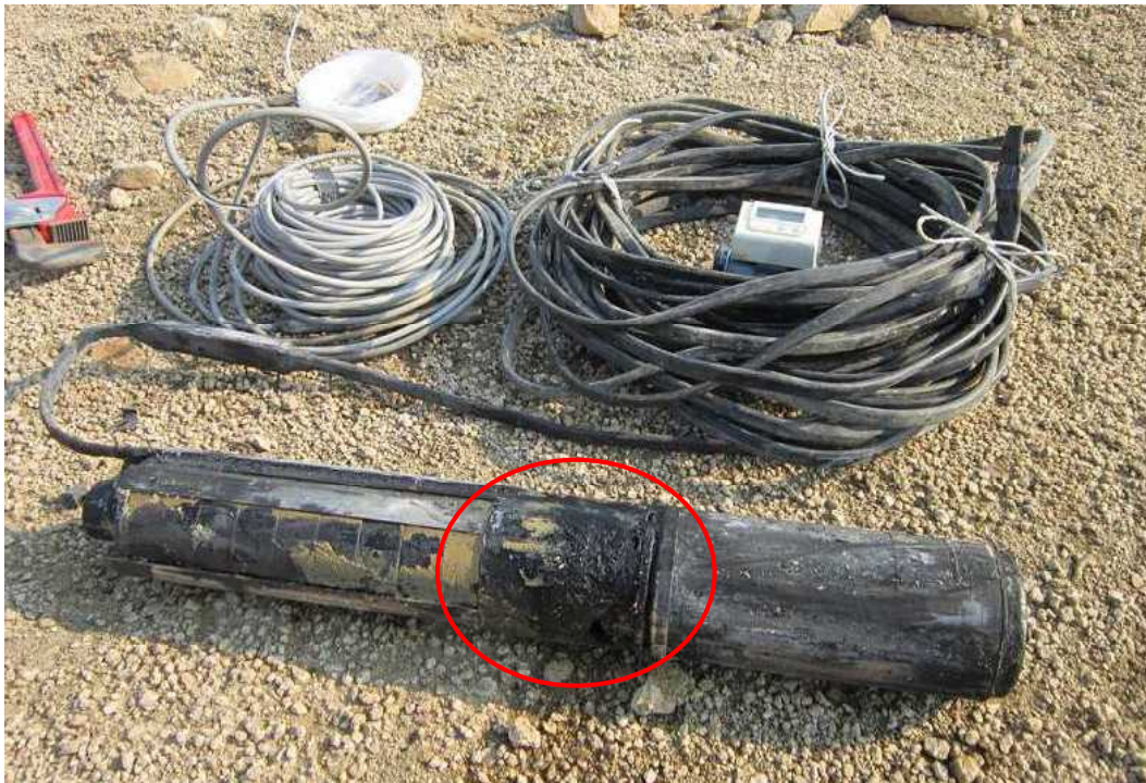
引き上げた (C, 2+40) 地点の揚水ポンプ等 (赤丸がストレーナ)
