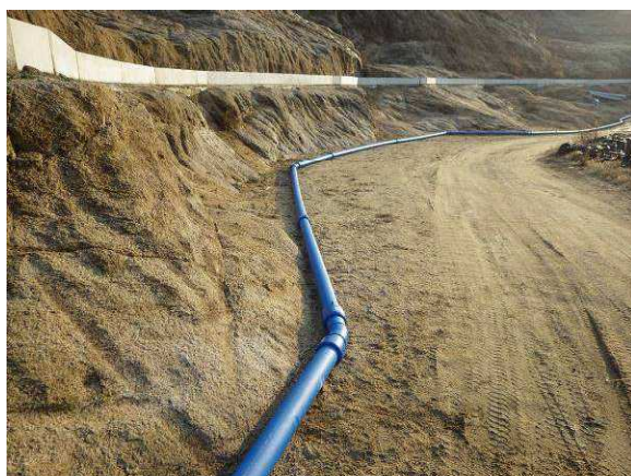
写真2 配管敷設状況
