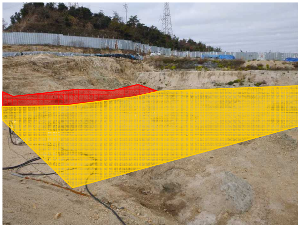
写真1 D測線西側付近の掘削完了判定等の実施
