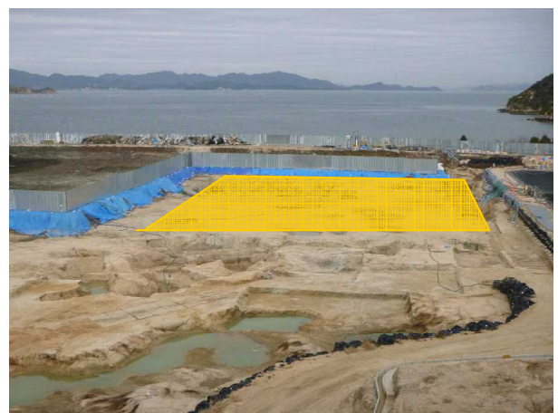
写真2 (G-H、2-3)付近の底面掘削完了の確認
