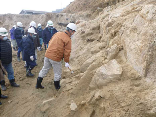
写真3 掘削完了判定の様子（H27.1.8）
