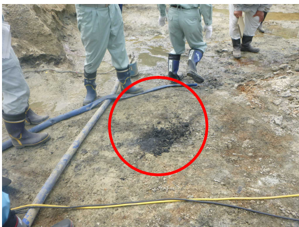
写真3 掘削完了判定等の様子 (H26. 7. 22)
