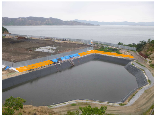
写真2 H+20 付近の底面掘削完了の確認
