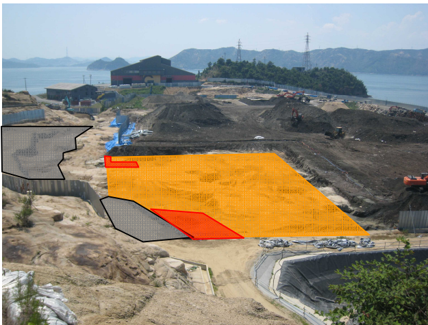
写真1 GH-34 付近の掘削完了判定等の実施
