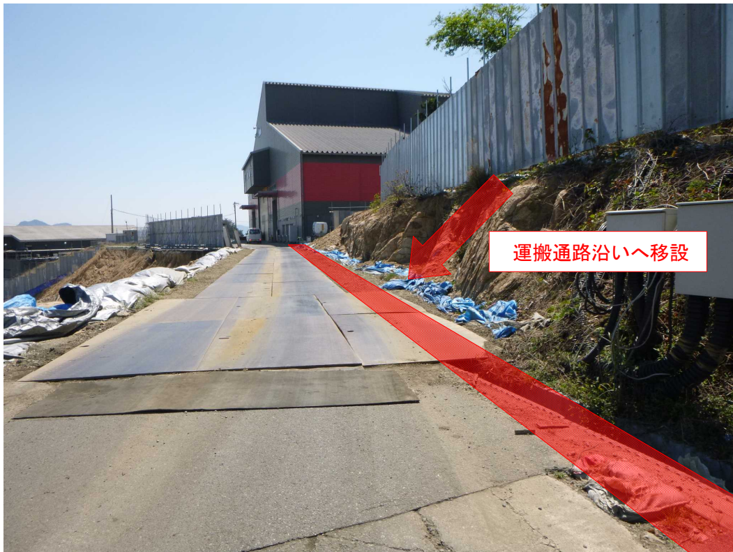
写真6 施工予定箇所を北側から見た写真
