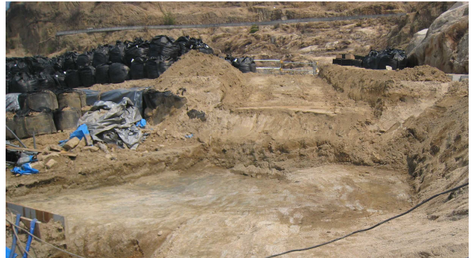
写真6 岩盤まで掘削した状況
