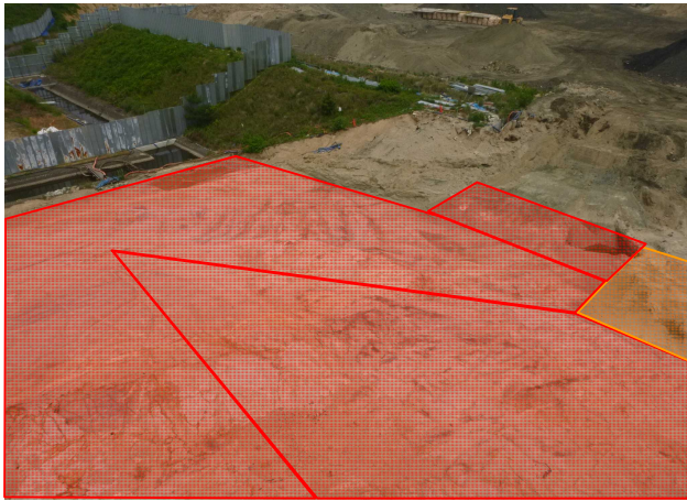
写真1 EF-45 付近の掘削完了判定等の実施（西側）
