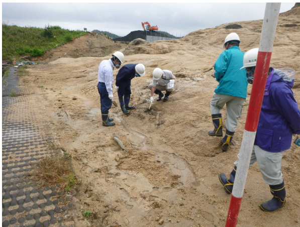
写真3 掘削完了判定等の様子（H26.6.6）
