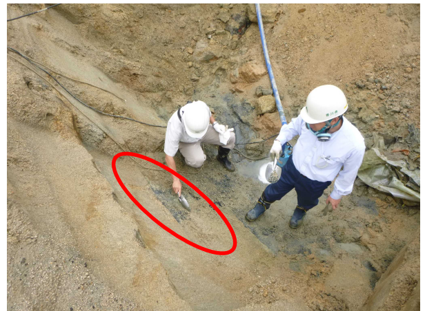
写真4 廃棄物が混ざった土壌（H26.6.6）
