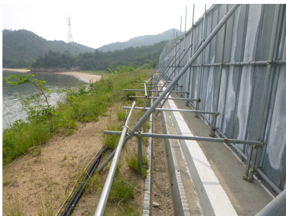
写真3 止水コンクリート設置状況（E測線から東）
