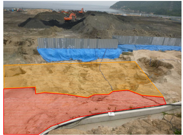
写真2 EF-45 付近の掘削完了判定等の実施箇所（東側）
