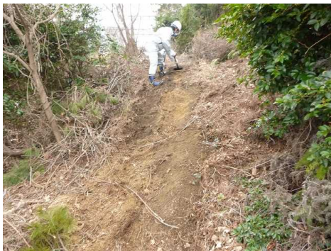
写真3 土壌の除去作業
