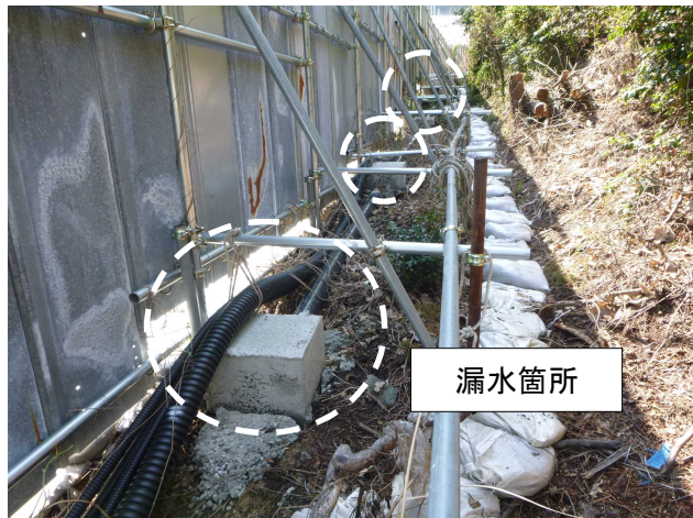
写真4 接合部をコンクリートで固めた状況
