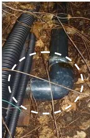
写真1 漏水箇所
