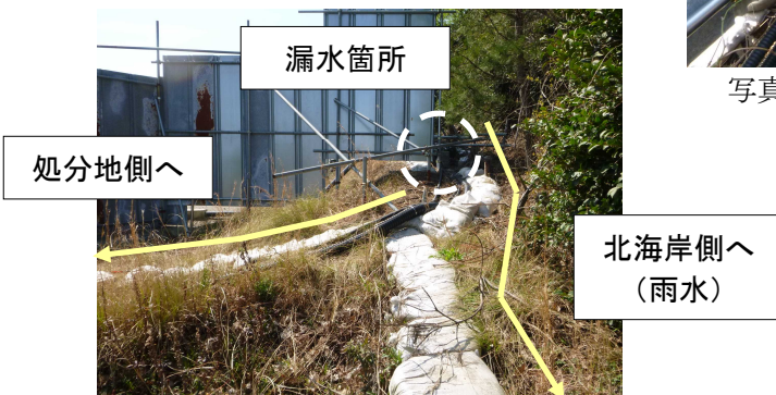
写真5 土のう設置状況
