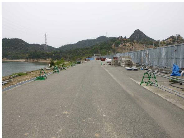
写真1 着工前 (E測線から東)
