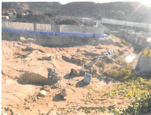
写真2 3測線南側の状況 (3+20より南)
