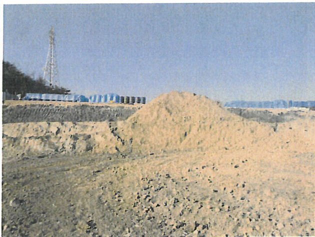
写真5 分別した土砂の仮置き状況
