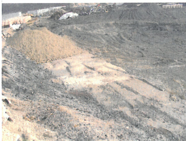
写真3 3測線北側の状況 (2+20より北)
