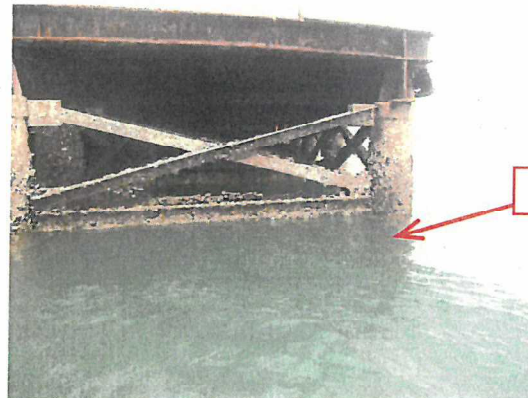
写真7 鋼管杭の状況
