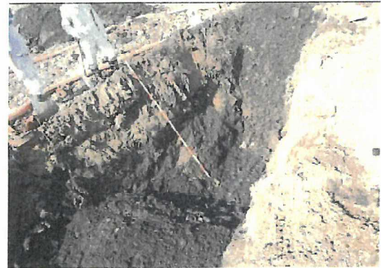
写真2 : G 測線南側の試掘状況 (H25. 8. 19)
