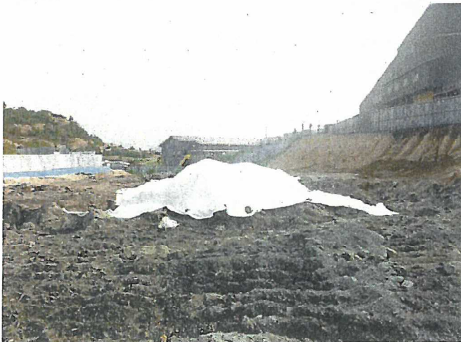
掘削したドラム缶にシート掛けした状況
