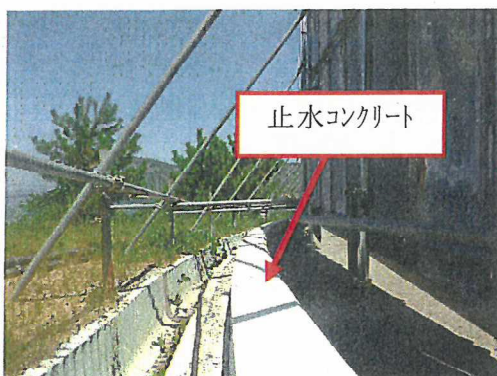
写真1 止水コンクリート施工状況
