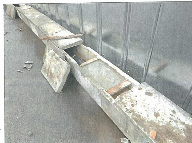
しみ出し箇所をコンクリートで固めたところ
