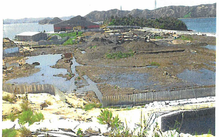
写真2：大雨後の状況（9/16撮影）
