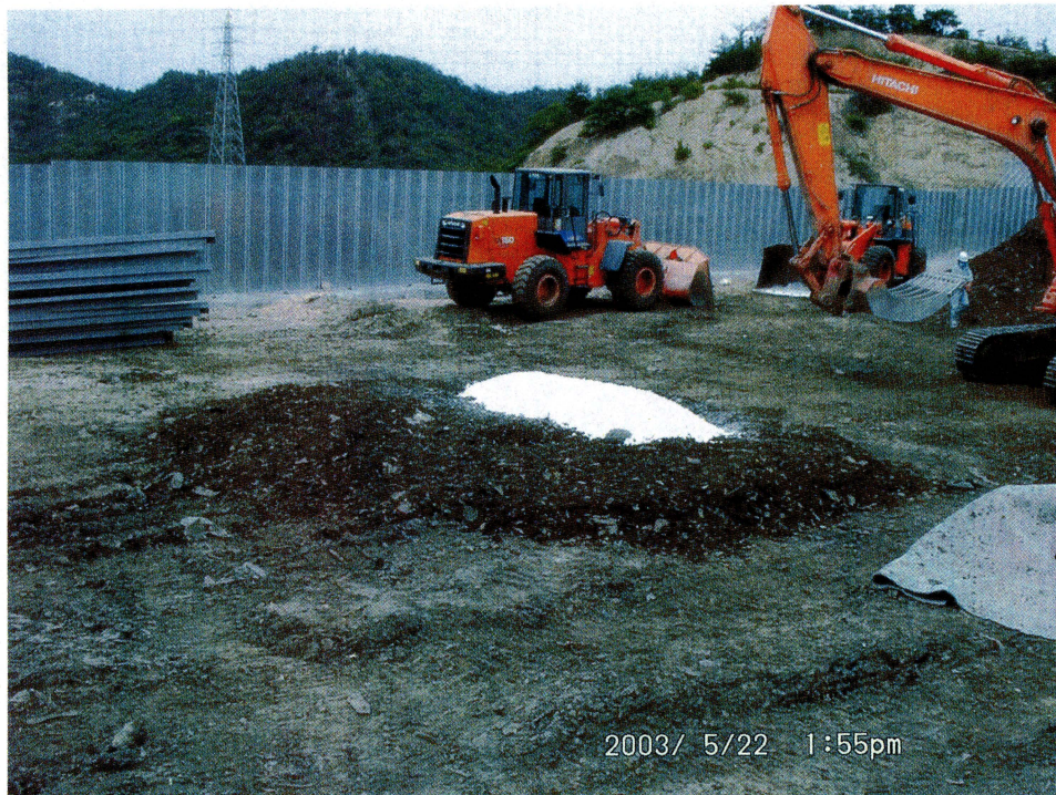
そのまま放置後混合する区画 500kgの生石灰添加直後
