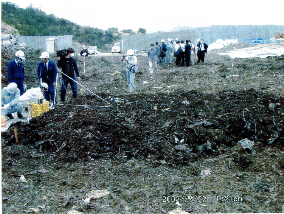
直ちに混合する区画 温度調査中
