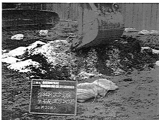
写真1 粒体 CaO 混合作業中
