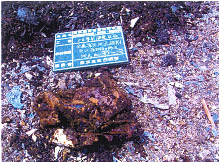
写真-2 ③ブロック 異常箇所 No.3 で発掘 されたドラム缶
