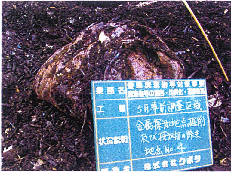
写真-1 ①ブロック 異常箇所 No.4 で発掘 されたドラム缶
