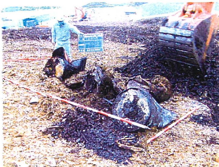
写真-6 ①ブロック異常箇所 No.36 で発掘されたドラム缶
