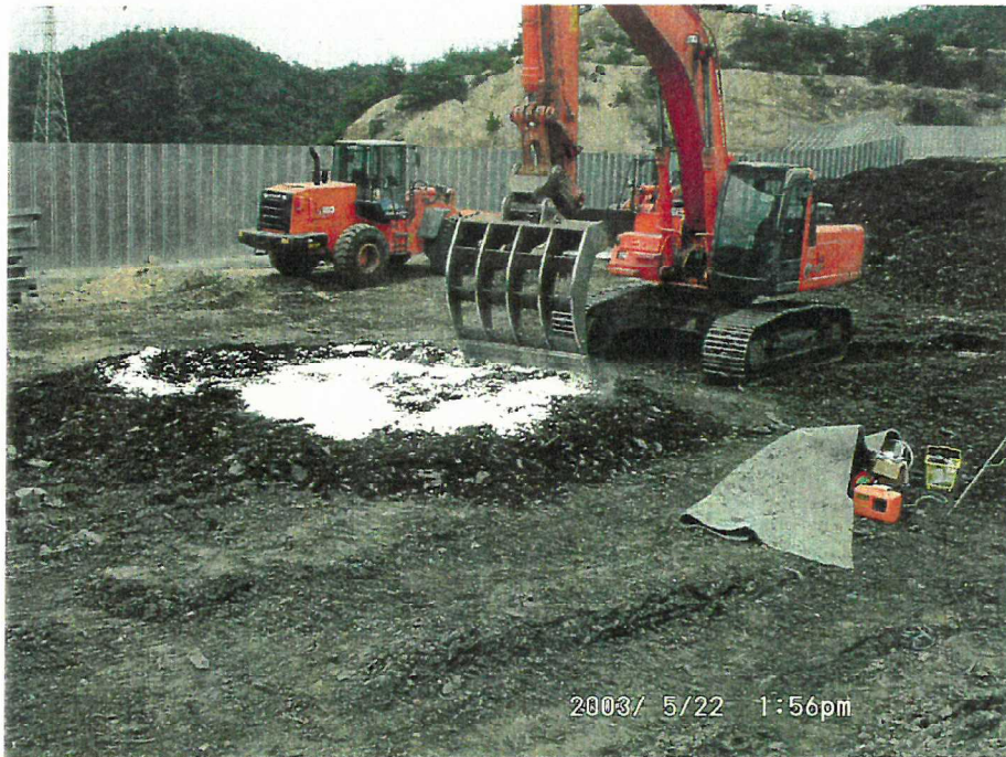
そのまま放置後混合する区画 生石灰を表面で均一化中
