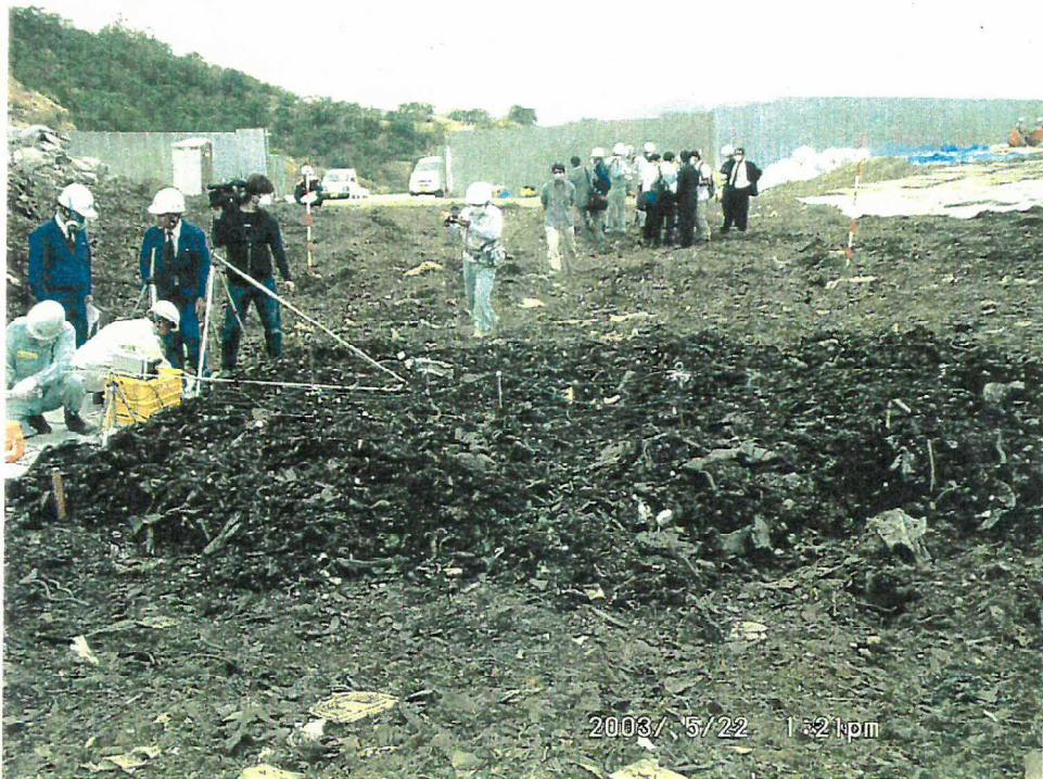
直ちに混合する区画 温度調査中
