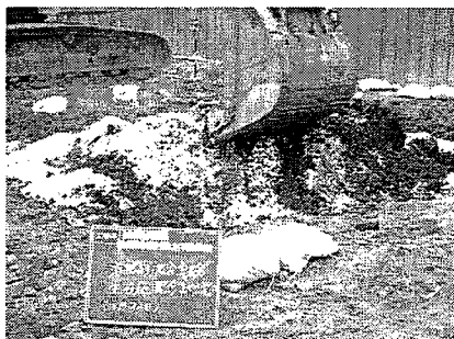
写真1-1 粒体CaO混合作業中
