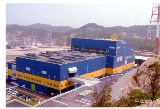
直島・中間処理施設
