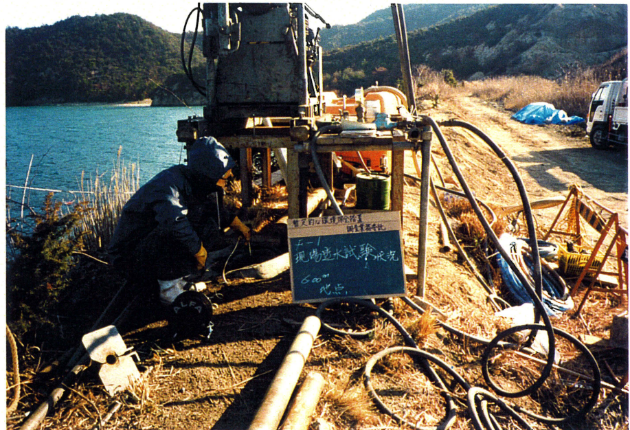
現場透水試験(ケーシング法)状況
