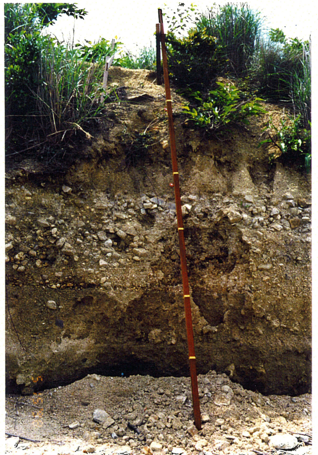
5月15日の変状状況 (測点③④付近が崩落)
