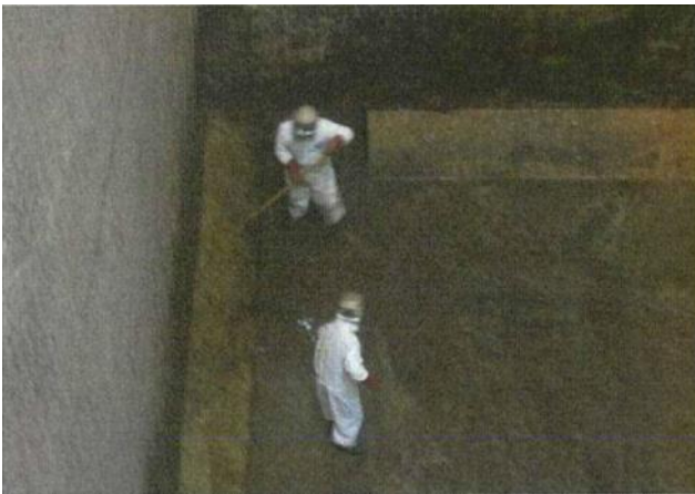
研り作業による底面除去・除染作業中 (上から壁面を撮影)
