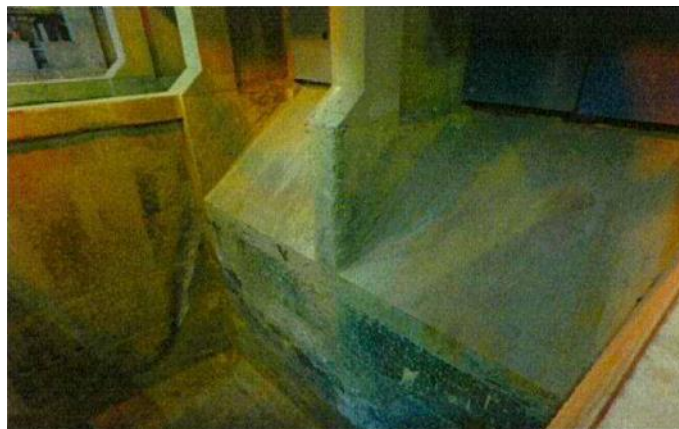
投入口付近除去・除染作業前 (上から撮影)
