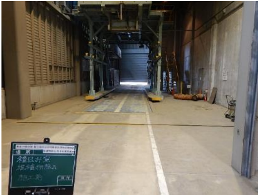
積込室除去・除染作業前 (北向きに撮影)
