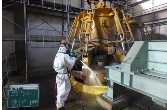
高圧洗浄による除染作業中
