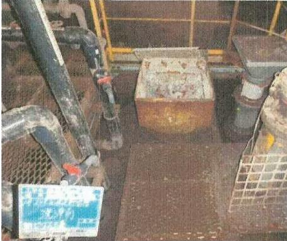
除去・除染作業前 (飛灰貯留槽点検口付近を撮影)
