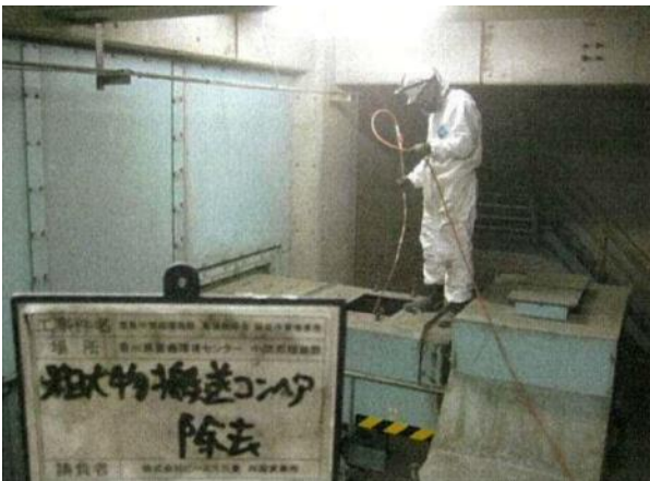
吸引による除去・除染作業中 (コンベヤ外側を撮影)
