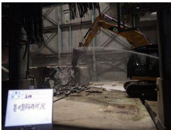
溶融炉基礎解体撤去中
