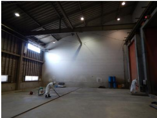
床面除去作業中（西方向に撮影）
