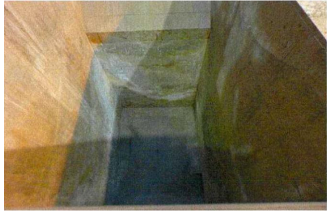
底面の除去・除染作業前 (上から撮影)
