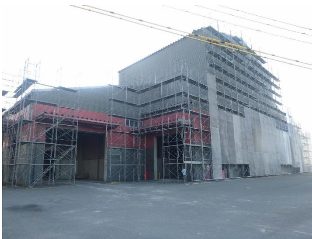
建屋解体前（北西側から撮影）
