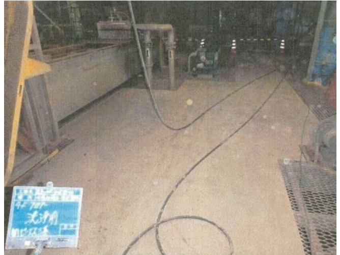
除去・除染作業前 (4階フロアを北向きに撮影)
