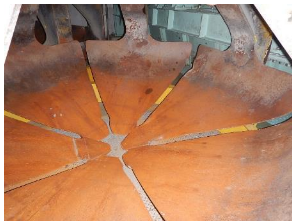
除去・除染作業後
