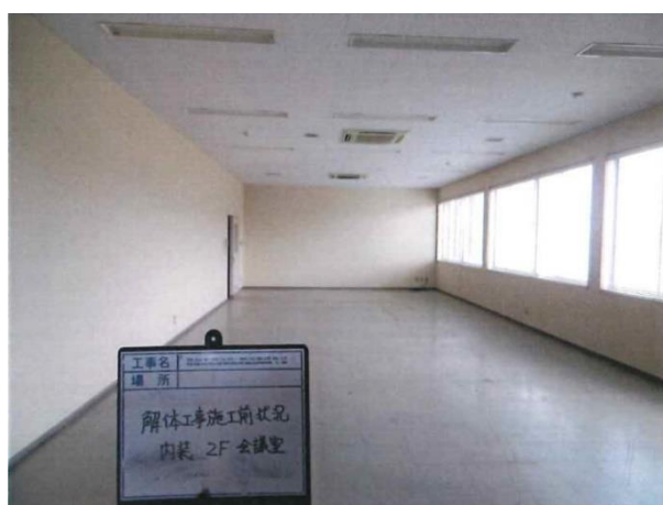
会議室付近内装解体前 （南方向から撮影）
