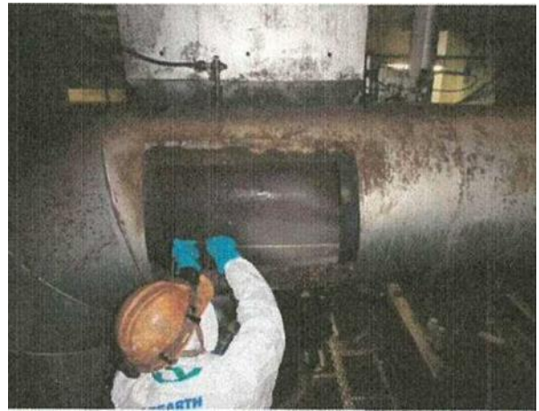
高圧洗浄による除去・除染作業中 (煙道切取り部分を撮影)
