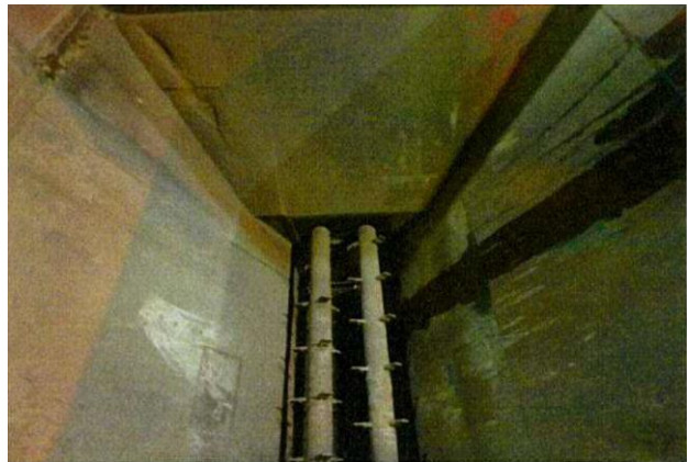
除去・除染作業前 (上からホッパを撮影)
