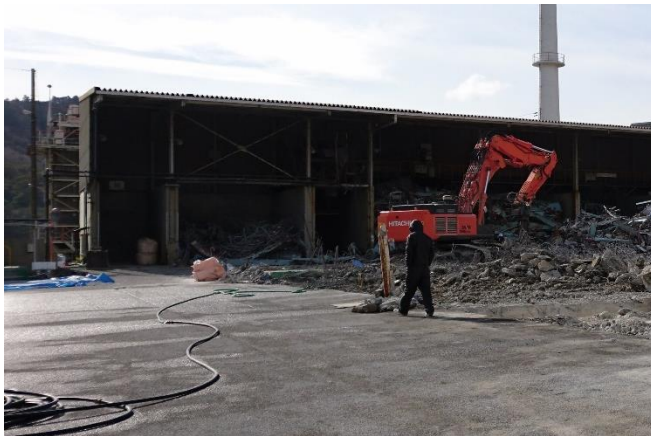
スラグヤード等（北から撮影）
