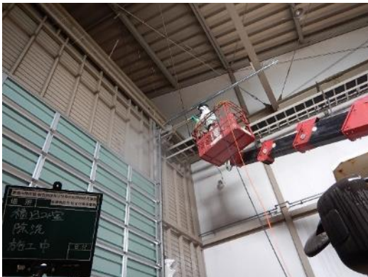
高所作業車による除染作業中
