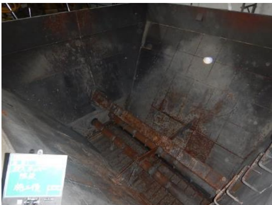
投入ホッパー内部除去・除染作業後
