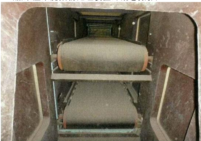
除去・除染作業後 (漁業産業廃棄物処理装置内部を撮影)
