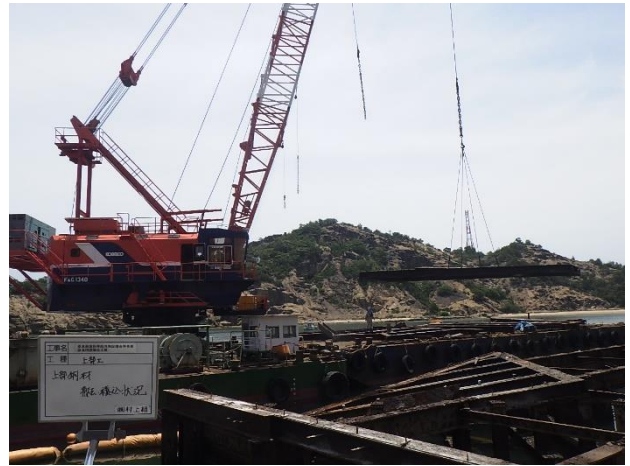
H鋼撤去状況
