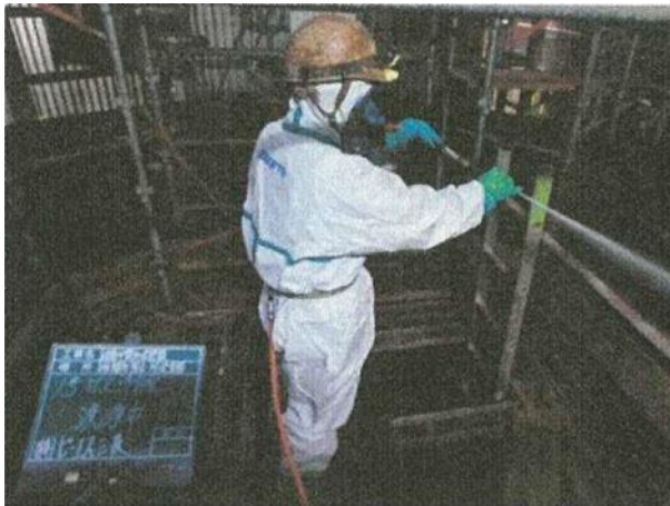
高圧洗浄による除去・除染作業中 (ガス冷却設備内部を撮影)
