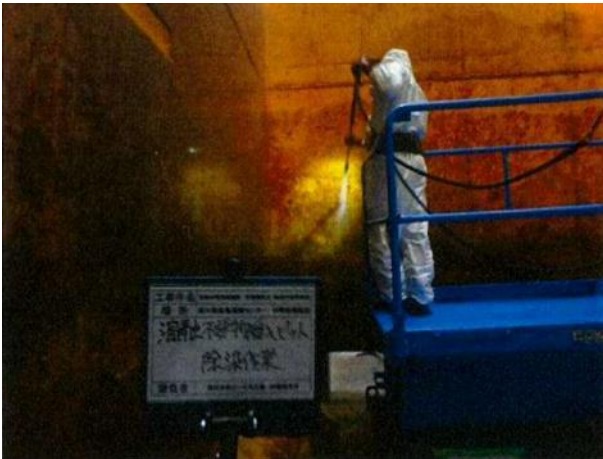
高圧洗浄によるピット内除去・除染作業中
