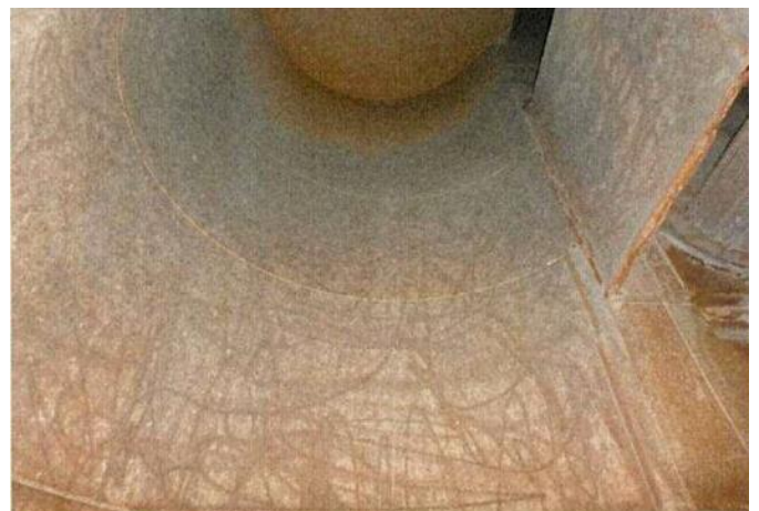
除去・除染作業後 (下から破碎機内部を撮影)
