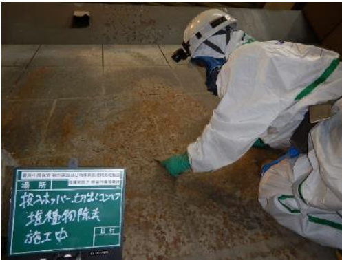
手作業による除去作業中
