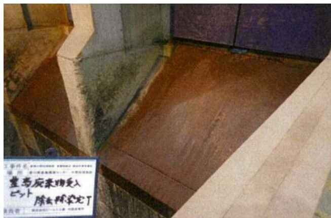
高圧洗浄による投入口付近除去・除染作業中 (上から撮影)
