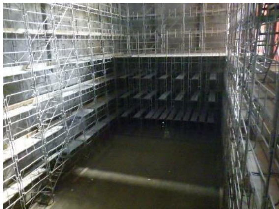
ピット足4面足場設置(西から撮影)
