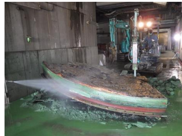
溶融炉ケーシング（除染作業中）
