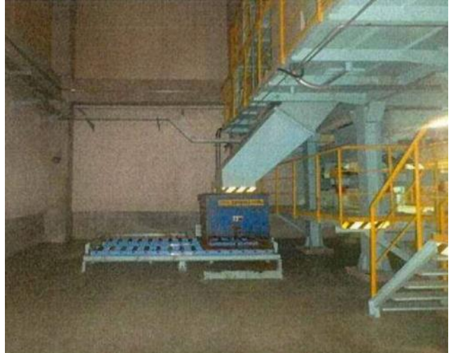
除去・除染作業前 (1階から北方向に撮影)
