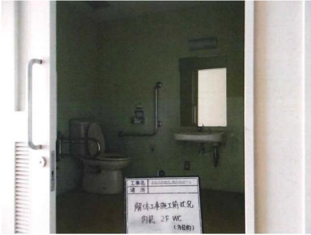
多目的トイレ内装解体前 (東方向から撮影)
