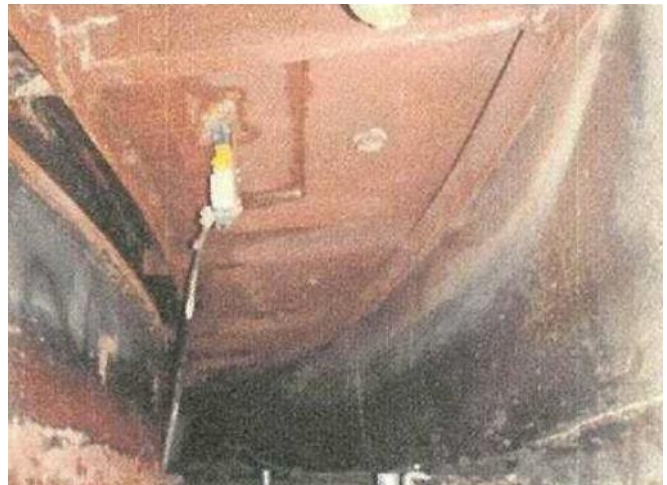
除去・除染作業後 (溶融炉内部を撮影)
