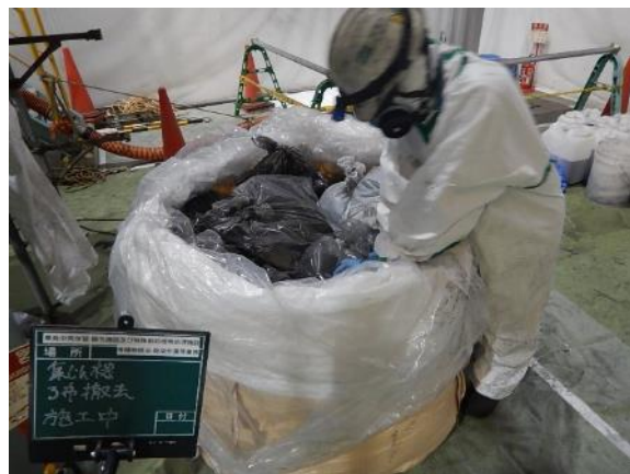
ろ布撤去作業中
