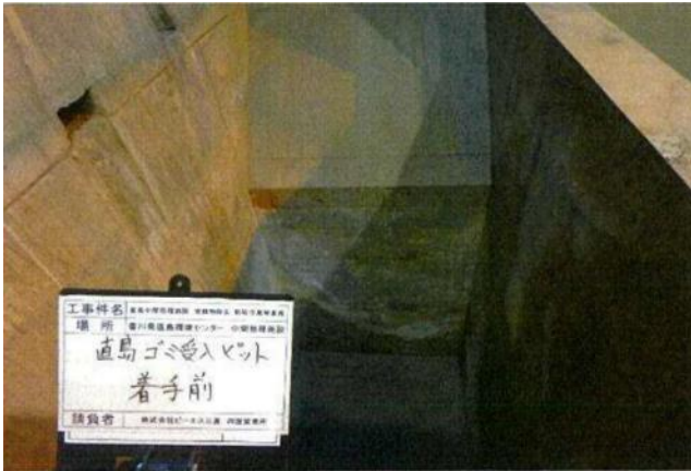
壁面の除去・除染作業前 (上から撮影)
