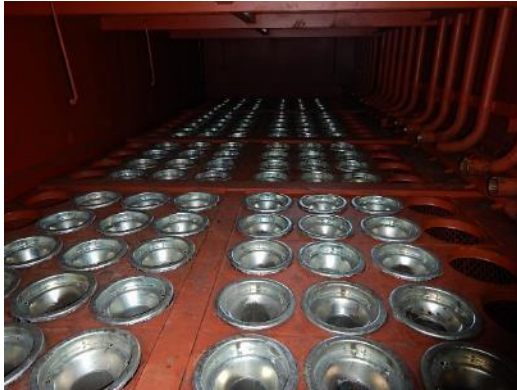
集塵機点検口作業終了後
