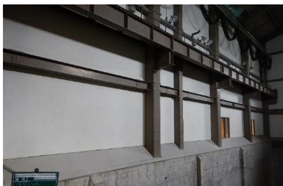
ピット壁面除去・除染作業後
