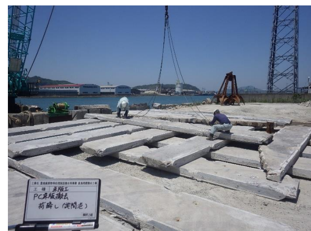
PC床板撤去 荷下し後
