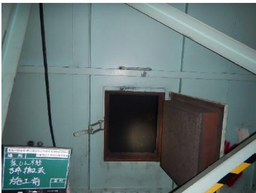
集塵機点検口 作業前
