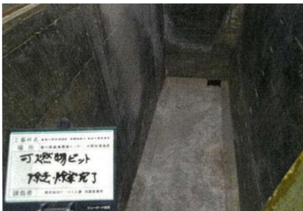
高圧洗浄による壁面除去・除染作業中 (東から撮影)
