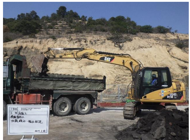
PC床板アスファルトガラ搬出
