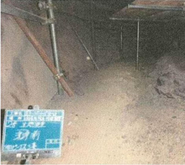
除去・除染作業前 (溶融炉内部を撮影)
