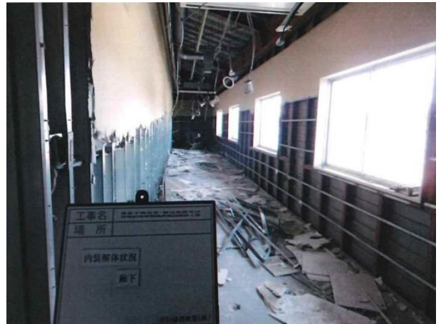
廊下付近内装解体中 (南方向から撮影)
