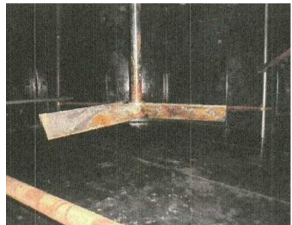
除去・除染作業後 (飛灰貯留槽内部を撮影)
