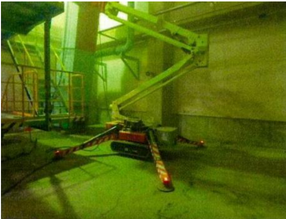
高所作業装置による除去・除染作業中 (作業装置撮影)
