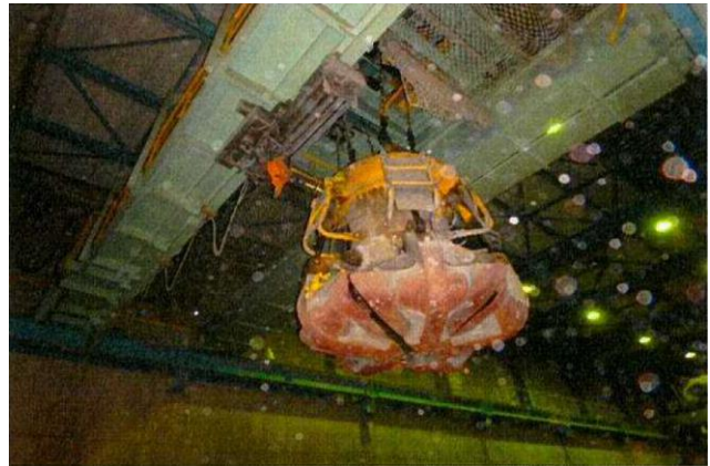
除去・除染作業前 (下から撮影)
