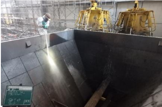
高圧洗浄による除染作業中
