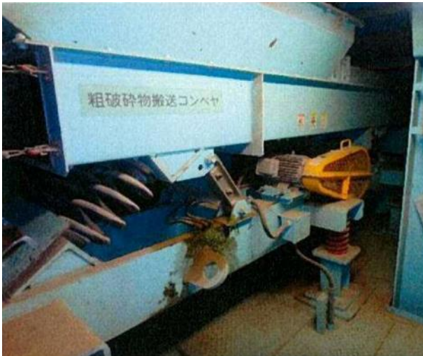
除去・除染作業前 (コンベヤ外装を撮影)
