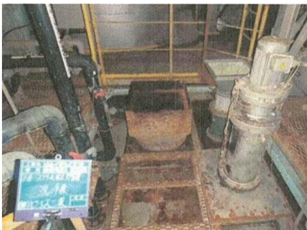
除去・除染作業後 (飛灰貯留槽点検口付近を撮影)
