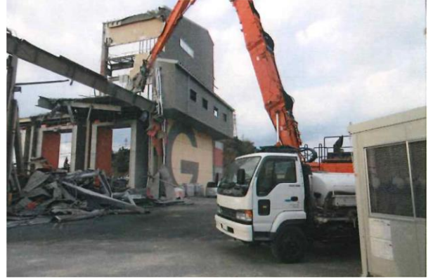
投入前室付近の解体（南東側から撮影）
