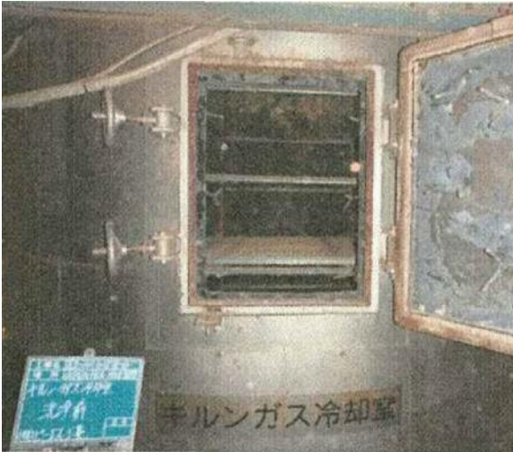
除去・除染作業前 (キルンガス冷却室点検口付近を撮影)
