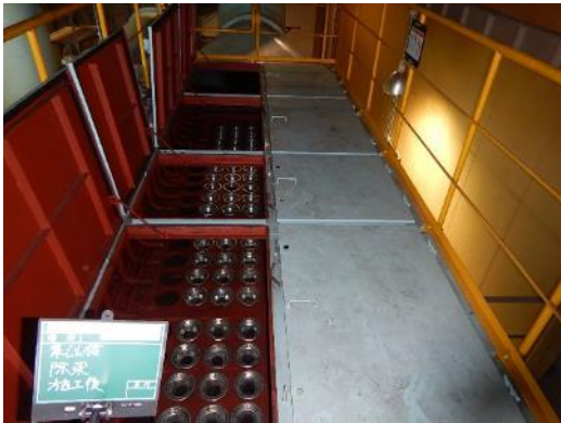
集塵機点検口作業終了後
