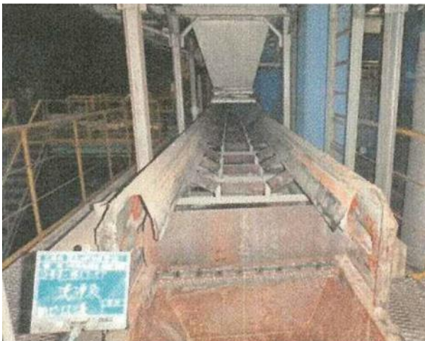
除去・除染作業後 (投入コンベヤを撮影)
