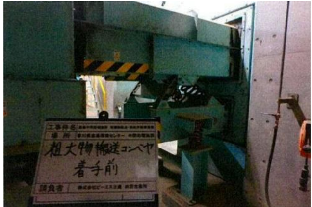
除去・除染作業前 (コンベヤ出口付近を撮影)
