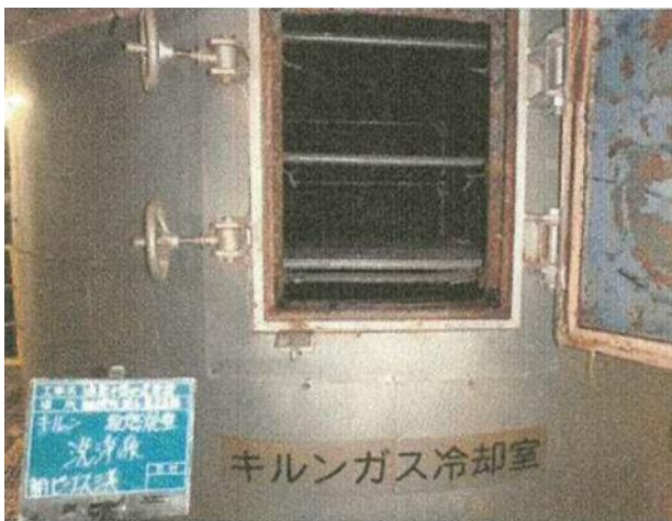
除去・除染作業後 (キルンガス冷却室点検口付近を撮影)
