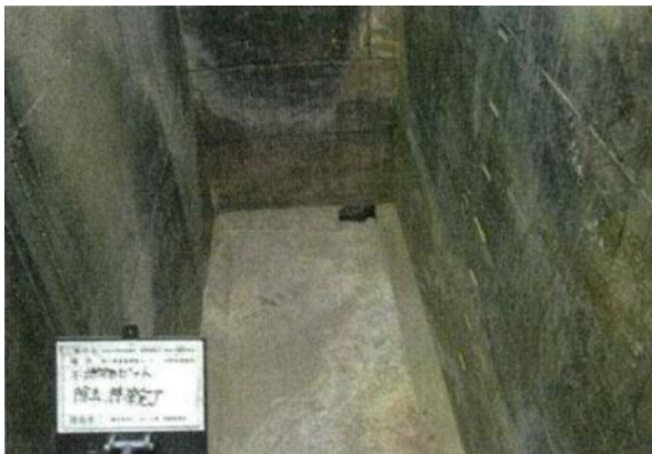
研り作業による底面除去・除染作業中 (上から底面を撮影)
