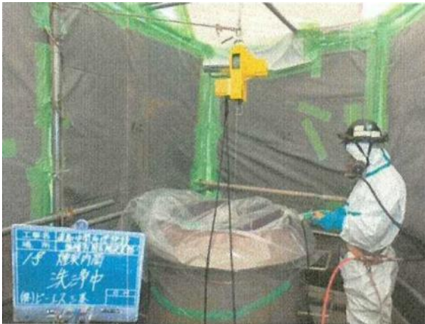
高圧洗浄による除去・除染作業中 (煙突上端部にて撮影)
