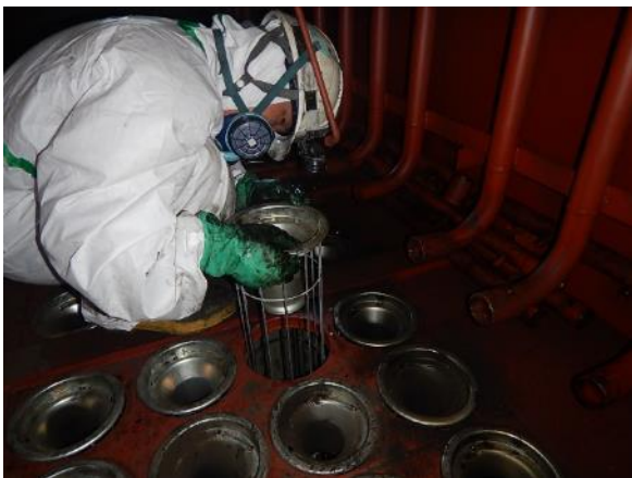
ろ布 撤去作業中
