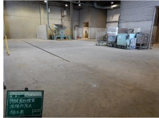
特殊前処理室除去・除染作業前 (南西向きに撮影)
