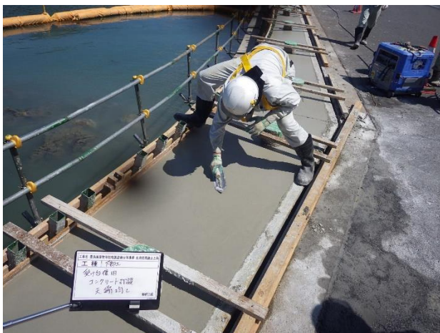
受け台復旧 コンクリート打設天端均し
