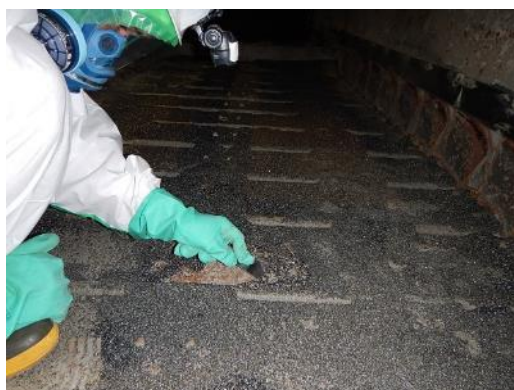
手作業による除去作業中
