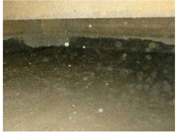
除去・除染作業前 (汚水貯留槽撮影)
