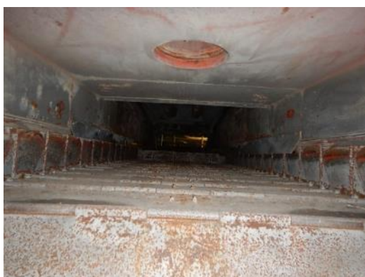
切出しコンベヤ内部除去・除染作業後
