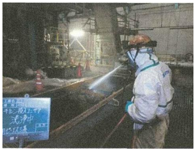
高圧洗浄による除去・除染作業中 (投入コンベヤを撮影)
