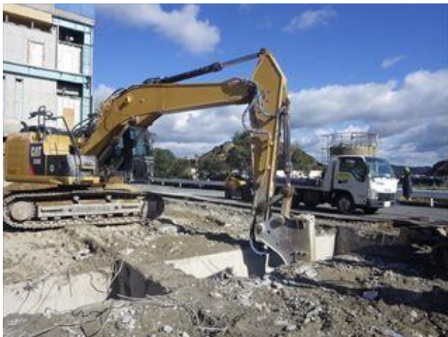
南棟土間・基礎撤去中（南西から撮影）
