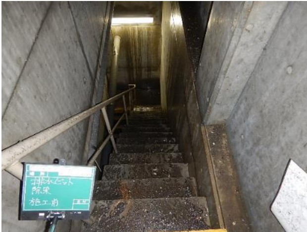
階段除去・除染作業前
