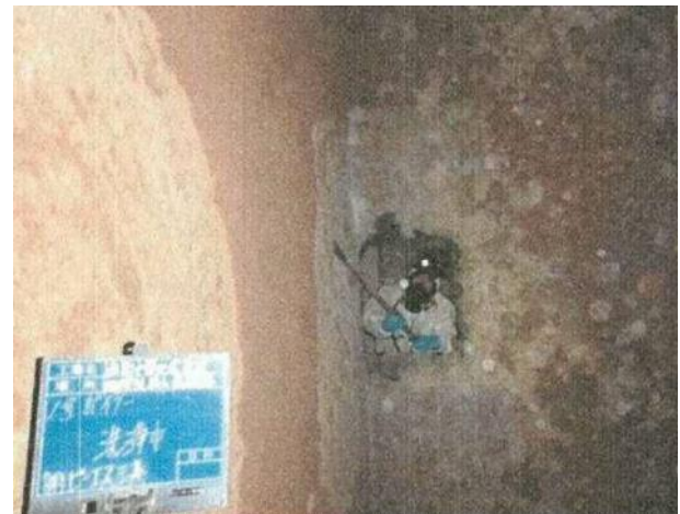
高圧洗浄による除去・除染作業中 (ボイラ点検口より撮影)
