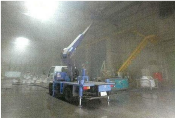
高圧洗浄による除去・除染作業中 (プラットホームを北向き撮影)
