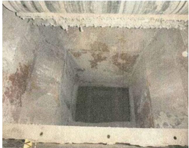
除去・除染作業前 (投入ホッパーを撮影)
