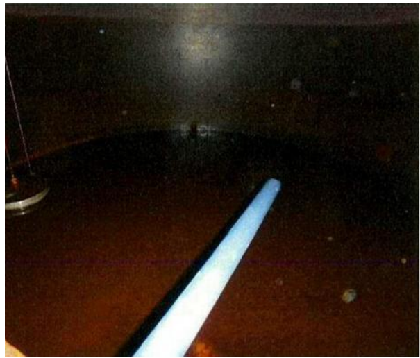
除去・除染作業前 (苛性ソーダ貯留槽内部を撮影)
