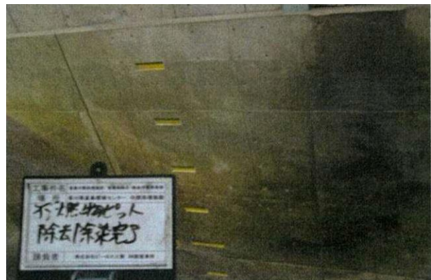
高圧洗浄による側面除去・除染作業中 (横から撮影)
