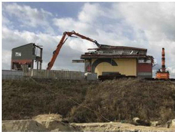
特殊前処理室付近の解体（東側から撮影）
