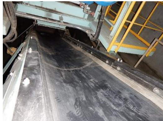
コンベヤ除去・除染作業後
