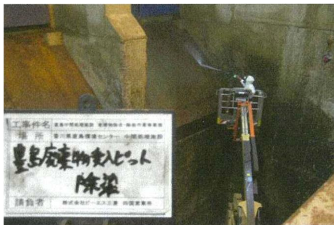
高圧洗浄による投入口付近除去・除染作業中 (上から撮影)
