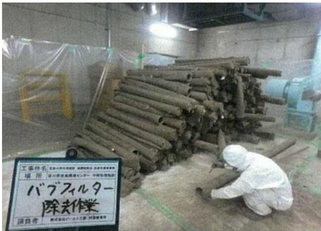
バグフィルタ撤去作業
