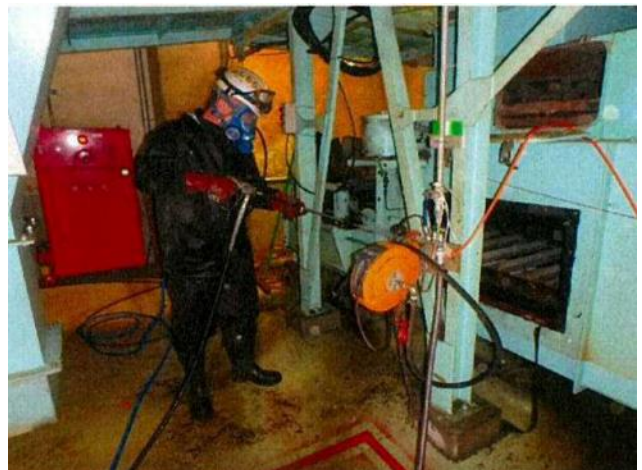
高圧洗浄による除去・除染作業中 (側面点検口を撮影)
