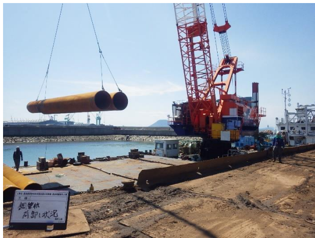
鋼管杭 荷下し
