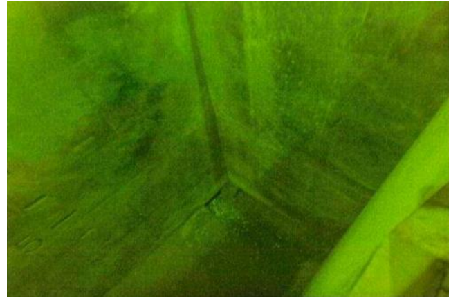
除去・除染作業前 (上から底面を撮影)
