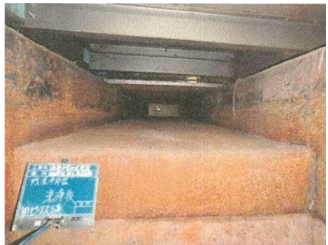
除去・除染作業後 (キルン残さライン内部を撮影)
