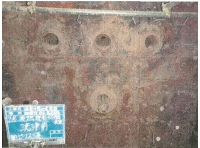
除去・除染作業前 (後燃焼室内部を撮影)
