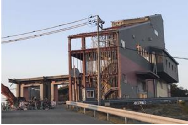
建屋解体の状況（南側から撮影）
