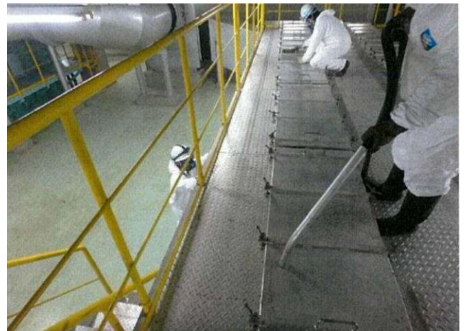
ウエス等による除去・除染作業前
