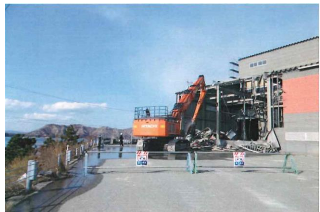
積込室付近解体中 （南東側から撮影）
