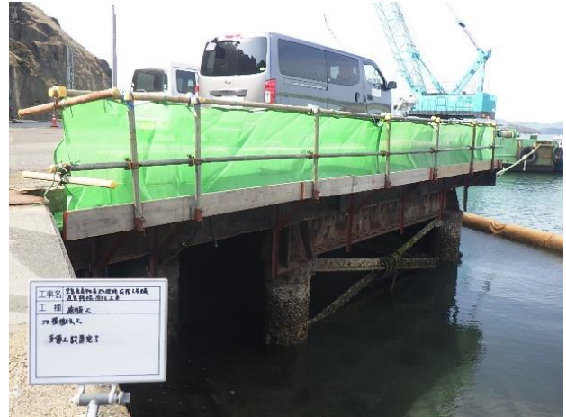
落下防止柵設置
