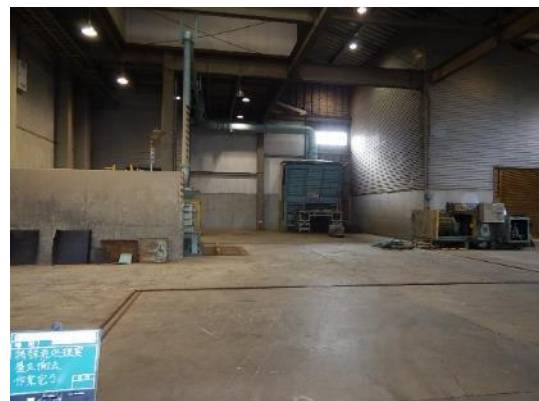
除去・除染作業後 (特殊前処理室撮影)
