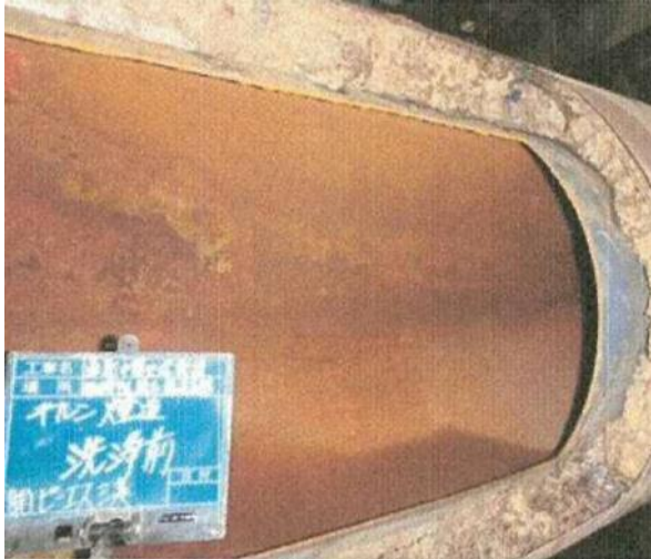
除去・除染作業前 (煙道切取り部分を撮影)
