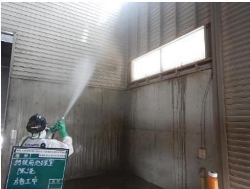
高圧洗浄による除染作業中
