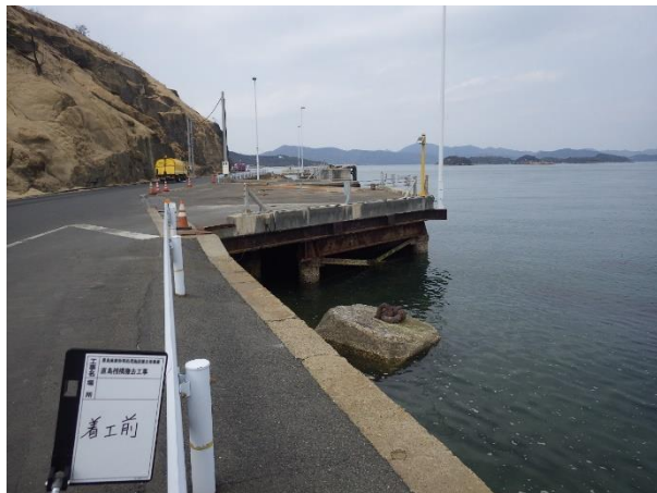
直島専用棧橋解体前 (南側から撮影)
