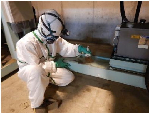
手作業による除去作業中
