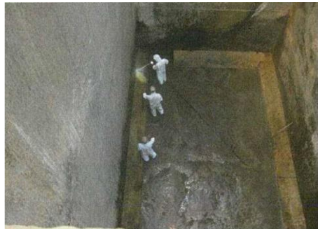
高圧洗浄による底面除去・除染作業中 (上から底面を撮影)
