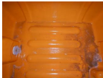
薬剤抜き取り後（タンク内部を撮影）
