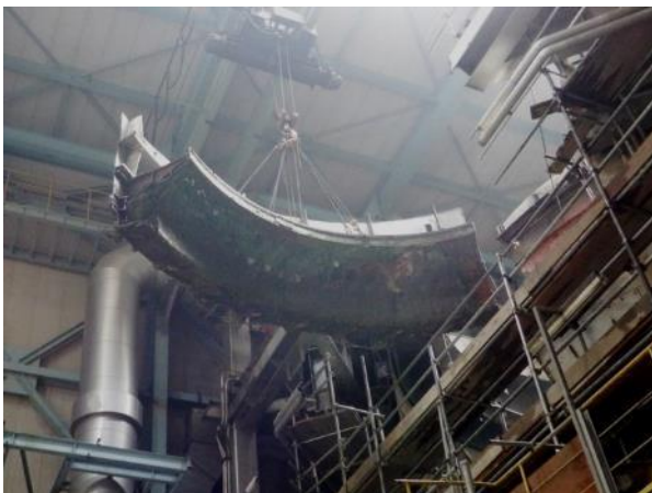
溶融炉ケーシング（吊り降ろし中）
