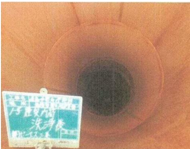
除去・除染作業後 (上から煙突内を撮影)
