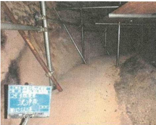
除去・除染作業後 (溶融炉内部を撮影)
