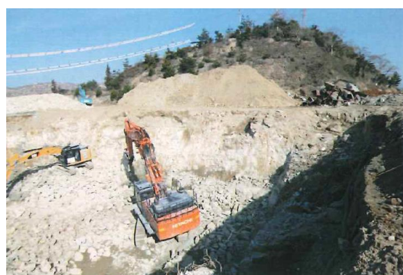
ピット壁撤去の状況 (東側から撮影)
