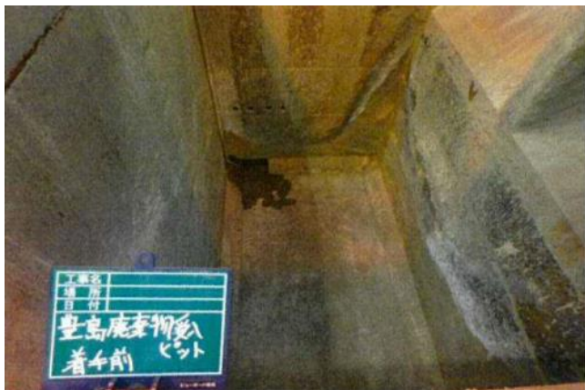
底面除去・除染作業前 (上から撮影)
