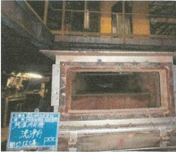
除去・除染作業前 (キルン残さラインの点検口付近を撮影)
