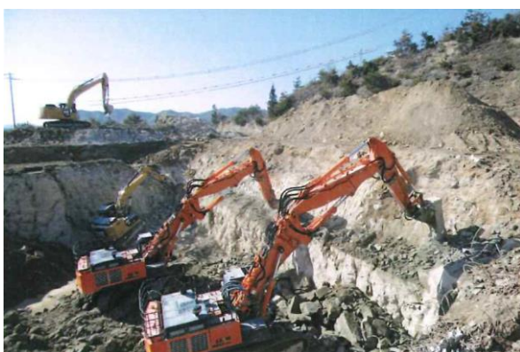
ピット壁撤去の状況 (東側から撮影)
