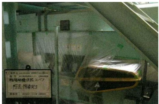
高圧洗浄による除去・除染作業中 (レベル3 保護具着用コンベヤ内部を撮影)
