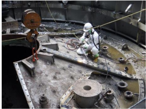
溶融炉上部（ガス溶断中） （レベル3保護具着用）
