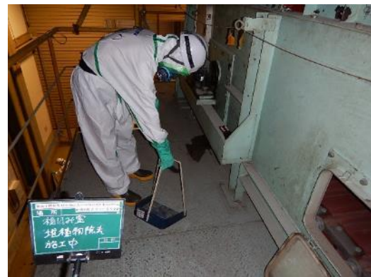
投入コンベヤ周り除去作業中
