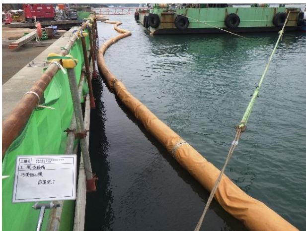
汚濁防止膜設置状況
