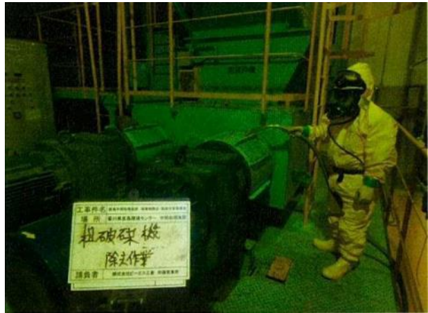
吸引による除去・除染作業中 (レベル3 保護具着用点検口より吸引中を撮影)
