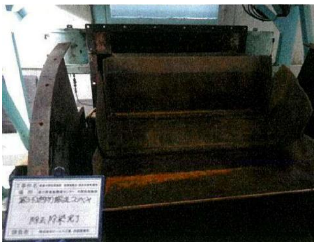
除去・除染作業後 (末端部点検口を撮影)
