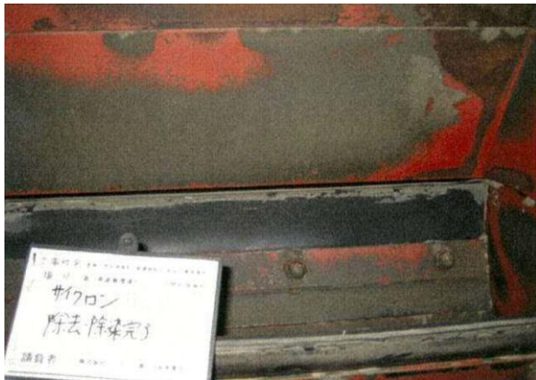
吸引による除去・除染作業後
