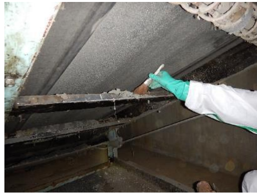
手作業によるコンベヤ下除去作業中
