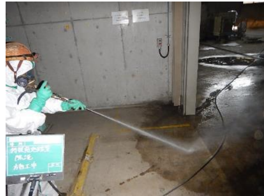
高圧洗浄による床面除染作業中
