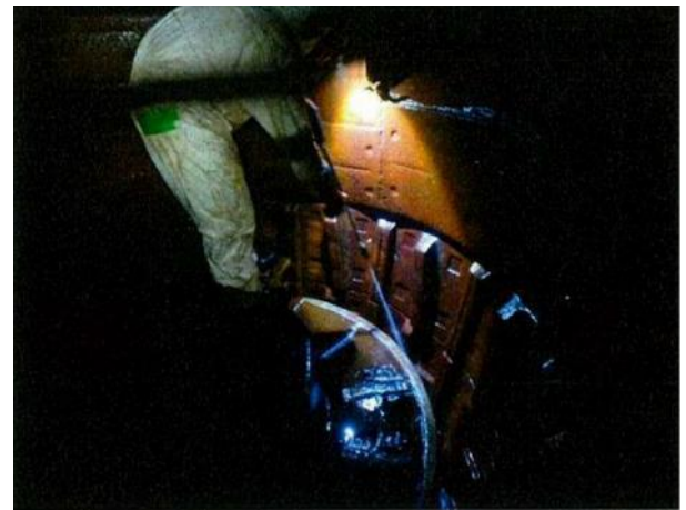
高圧洗浄による除去・除染作業中 (破碎機内部を撮影)
