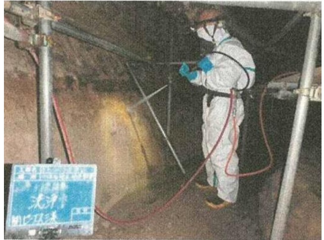
高圧洗浄による除去・除染作業中 (溶融炉内部を撮影)
