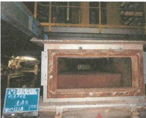
除去・除染作業後 (キルン残さラインの点検口付近を撮影)
