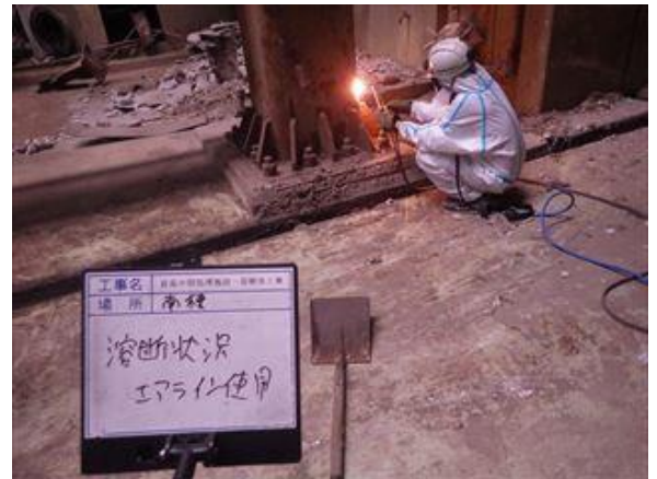
ガス溶断作業中 (レベル3保護具着用)
