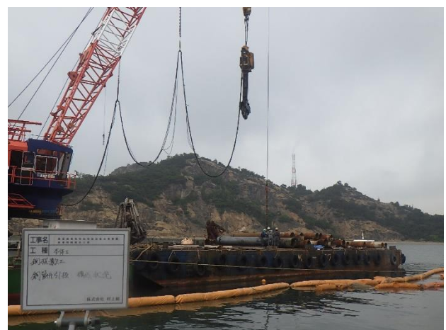
鋼管杭積込狀況
