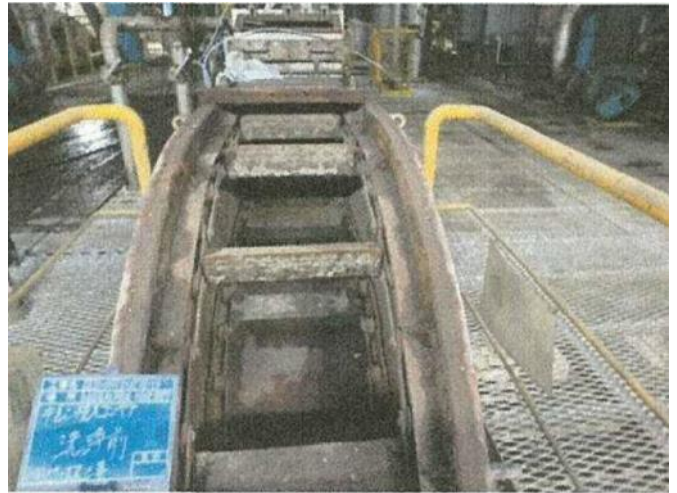
除去・除染作業前 (投入コンベヤを撮影)
