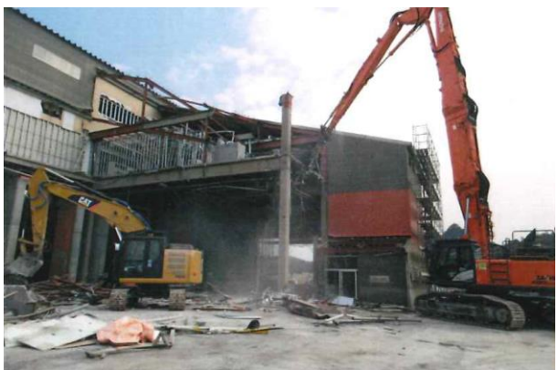
中央操作室付近解体中（西側から撮影）
