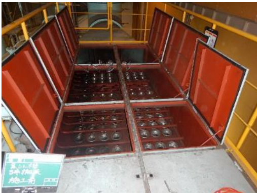
集塵機点検口 作業前
