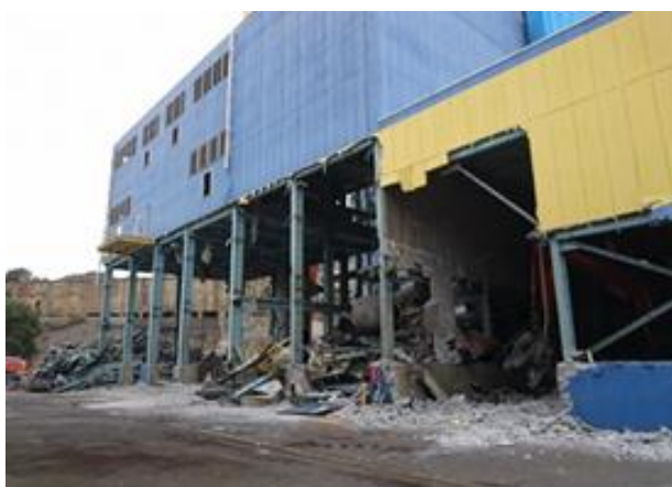
南棟建屋解体中（南東側から撮影）
