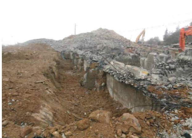
基礎・地中梁解体の状況 (東側から撮影)
