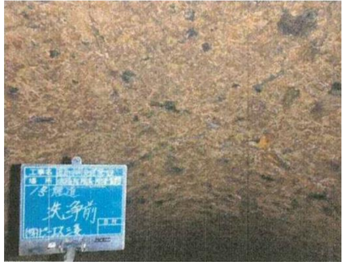
除去・除染作業前 (煙道内部を撮影)
