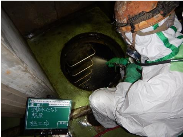
高圧洗浄による地下ピット除染作業中
