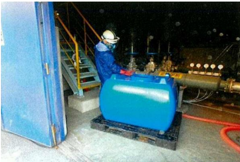
除去・除染作業後 (残留物の保管状況を撮影)
