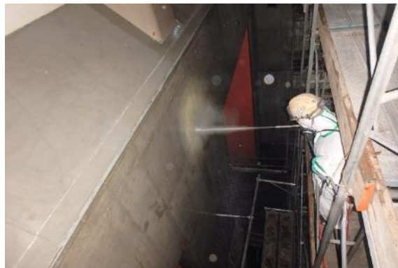
ピット壁面除染作業中
