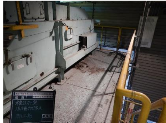
コンベヤ周り除去・除染作業前
