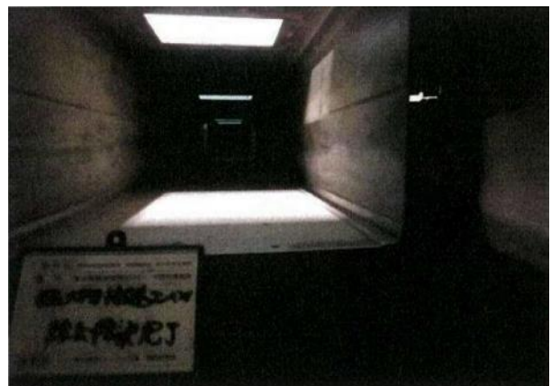
除去・除染作業後 (コンベヤ内部を撮影)
