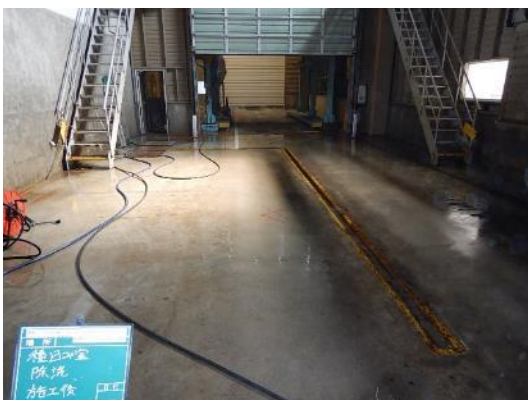
除去・除染作業後（南向きに撮影）
