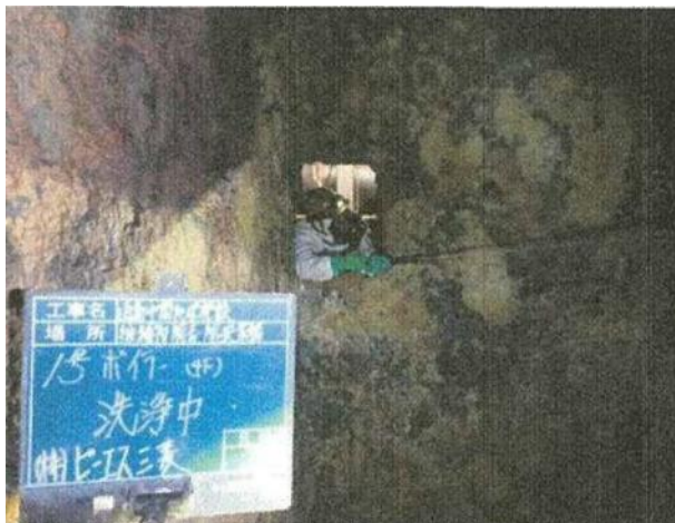
高圧洗浄による除去・除染作業中 (4階ボイラ点検口より撮影)
