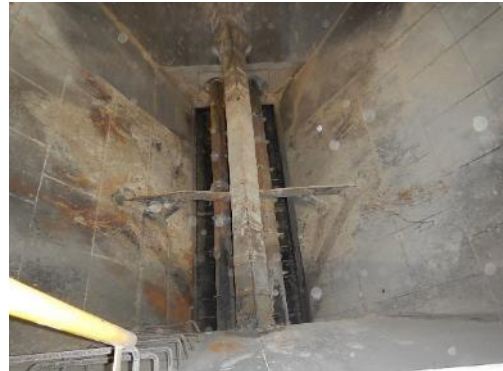
投入ホッパー内部除去・除染作業前
