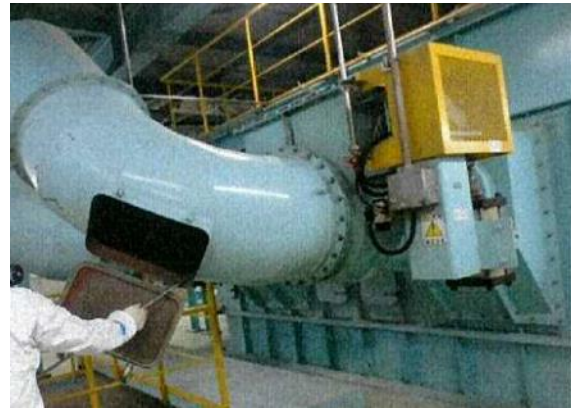
吸引による除去・除染作業前 (サイクロン配管を撮影)
