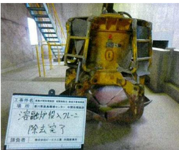
除去・除染作業後 (横から撮影)
