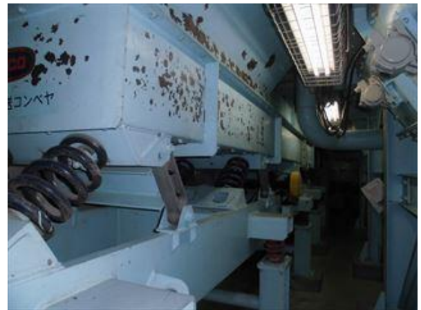
粗大物搬送コンベヤ解体作業前 (2階コンベヤを西方向に撮影)
