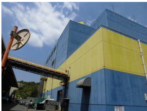
南棟建屋解体前（南東側から撮影）
