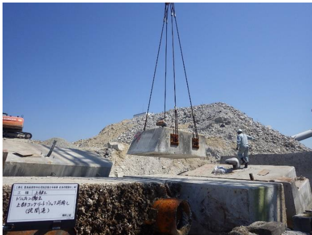
ドルフィン撤去 荷下し
