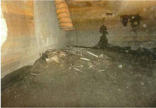
除去・除染作業前 (汚水貯留槽撮影)
