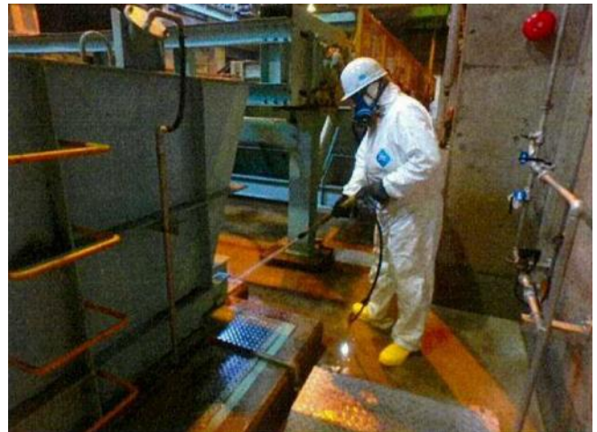
高圧洗浄による除去・除染作業中 (グリズリ外側撮影)
