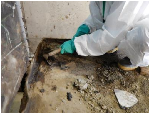
手作業による除去作業中
