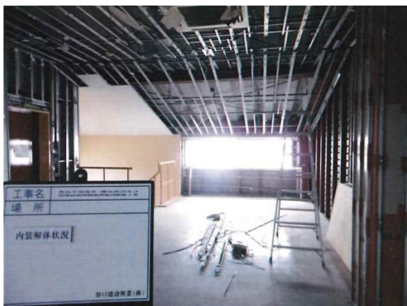
2階エレベータホール付近内装解体中 (北側から撮影)
