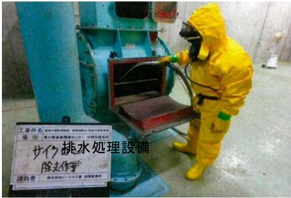
吸引による除去・除染作業中 (レベル3 保護具着用)
