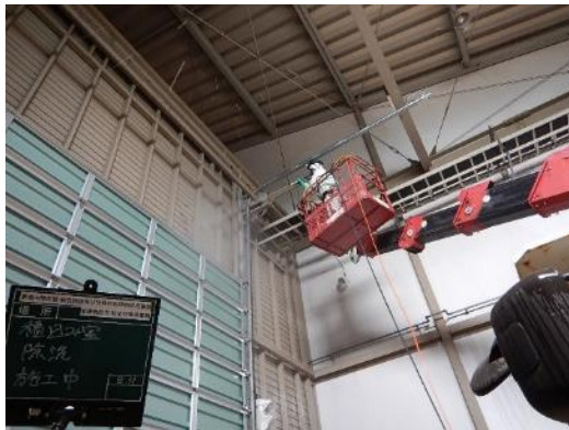
高所作業車による除染作業中
