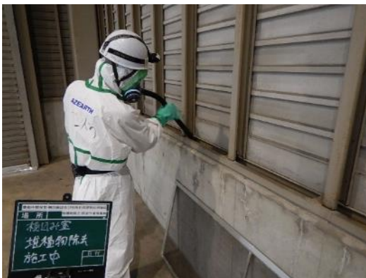
吸引による積込室除去作業中
