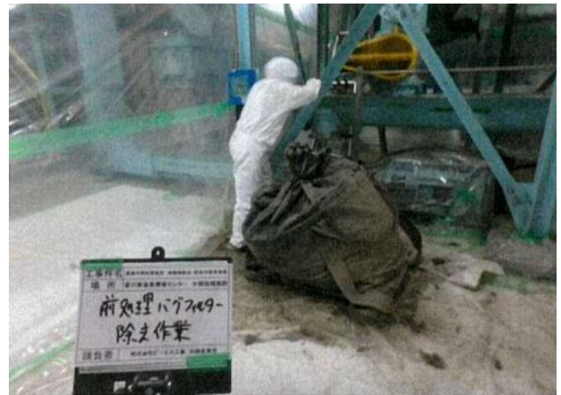
バグフィルタ撤去作業
