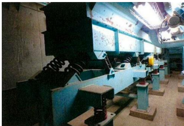
除去・除染作業後 (コンベヤ外装を西方向に撮影)
