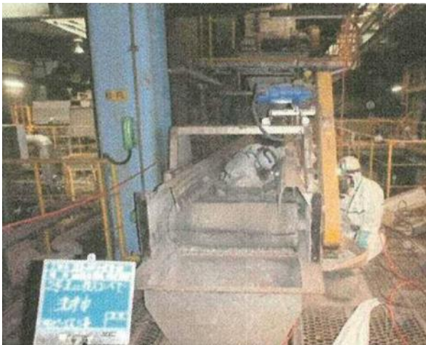
コンベヤベルト除去作業中 (投入コンベヤを撮影)
