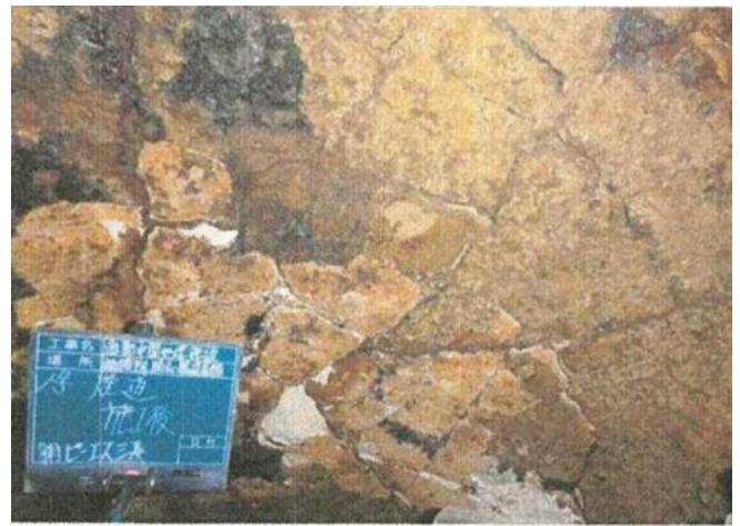
除去・除染作業後 (煙道内部を撮影)
