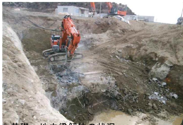
基礎・地中梁解体の状況 (西側から撮影)
