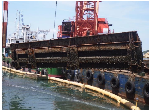
カーテンウォール撤去状況
