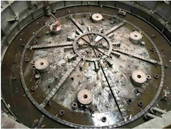
溶融炉上部（機器類撤去後） （溶融炉上部を撮影）
