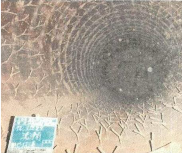
除去・除染作業前 (ロータリーキルン内部を撮影)
