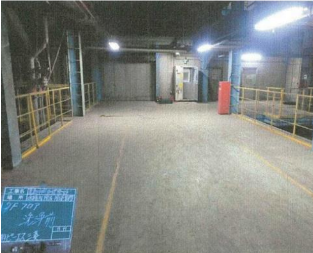
除去・除染作業前 (南棟2階フロア付近を撮影)
