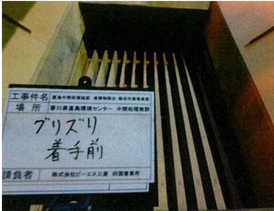
除去・除染作業前 (上からグリズリを撮影)
