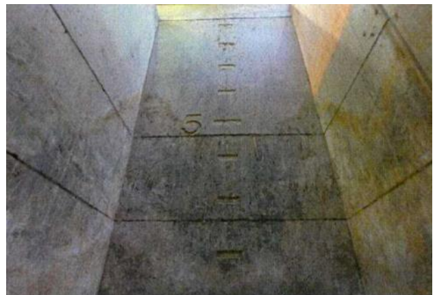
ピット内除去・除染作業後 (下から上に壁面を撮影)
