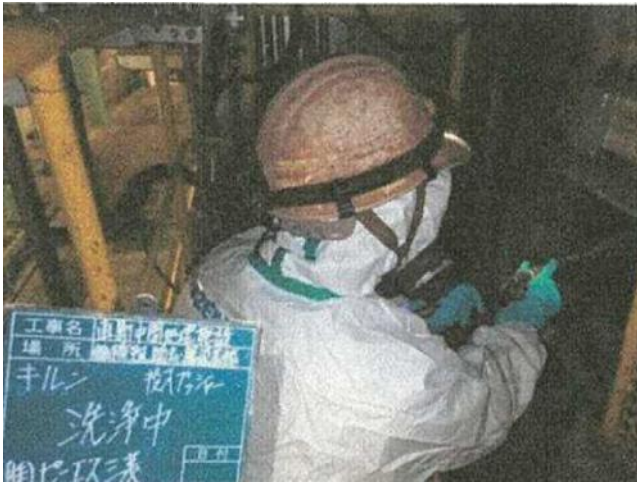
高圧洗浄による除去・除染作業中 (投入プレッシャー洗浄中撮影)
