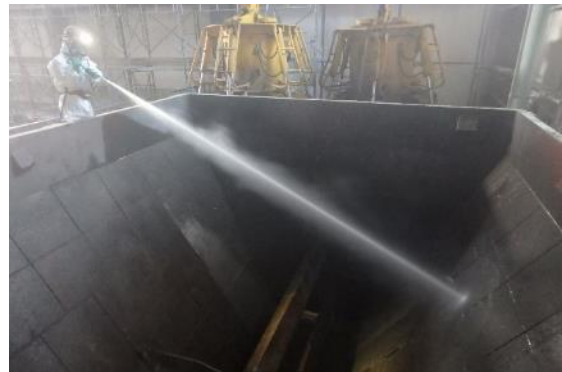
高圧洗浄による除染作業中
