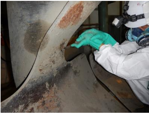
手作業による除去作業中
