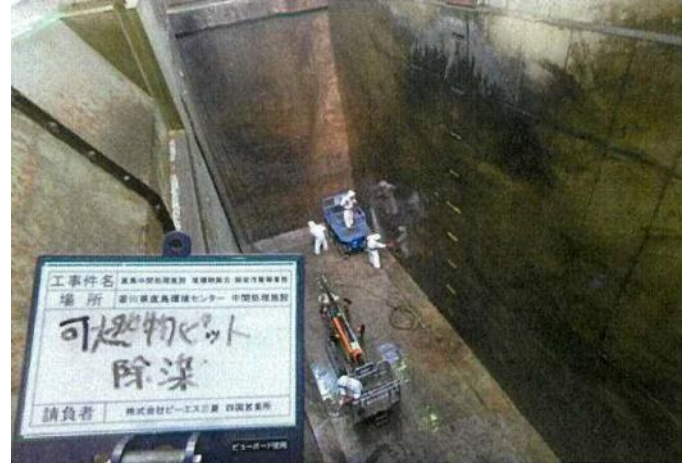
研り作業による底面除去・除染作業中 (上から底面を撮影)
