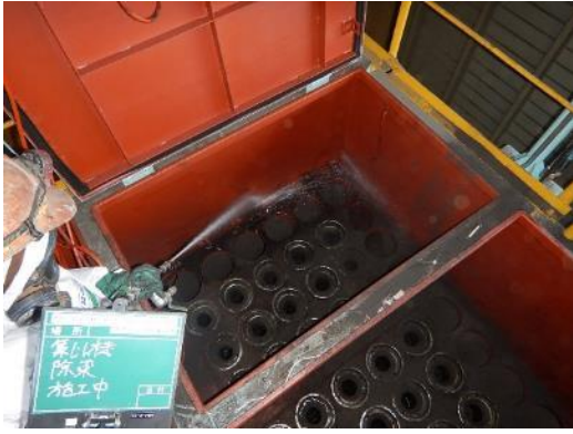
高圧洗浄による集塵機点検口除染作業中
