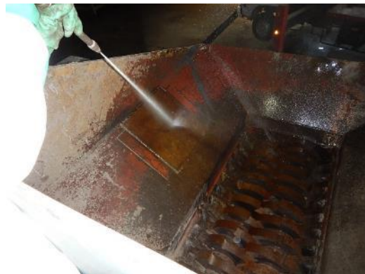
高圧洗浄による二軸破碎机除染作業中
