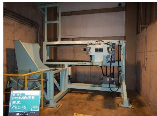
除去・除染作業後
