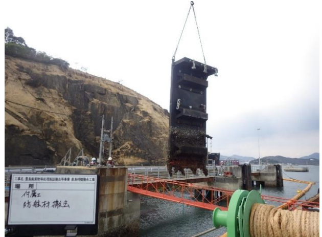
防舷材撤去状況
