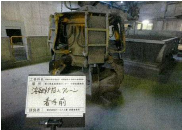
除去・除染作業前 (横から撮影)
