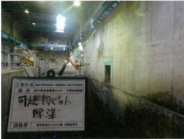
高圧洗浄による壁面除去・除染作業中 (東から撮影)
