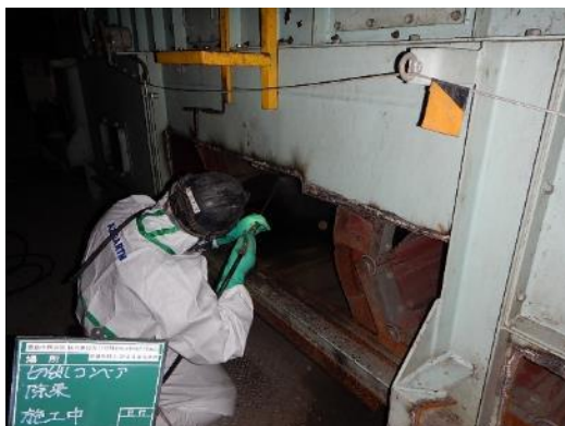
高圧洗浄による除染作業中
