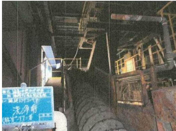
除去・除染作業前 (第1 破碎スラグコンベヤを撮影)
