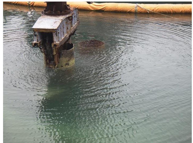
鋼管杭引拔狀況（近景）
