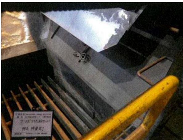
除去・除染作業後 (上からグリズリを撮影)
