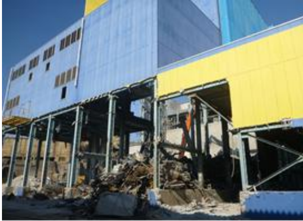
南棟建屋解体中（南東側から撮影）
