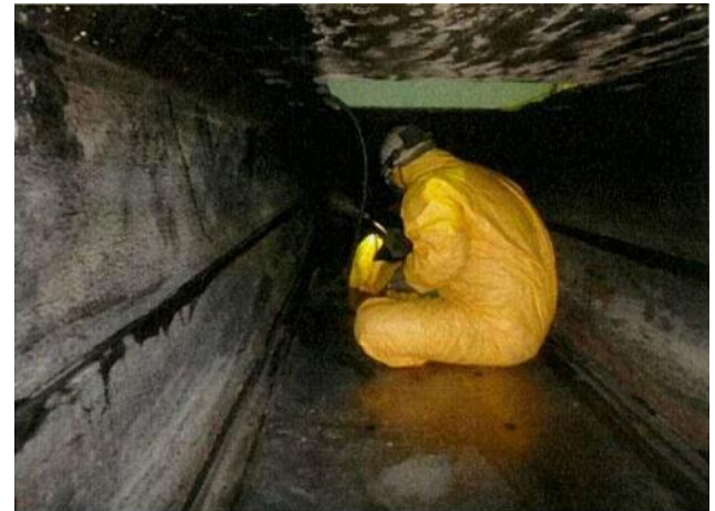
高圧洗浄による除去・除染作業中 (レベル3 保護具着用コンベヤ内部を撮影)
