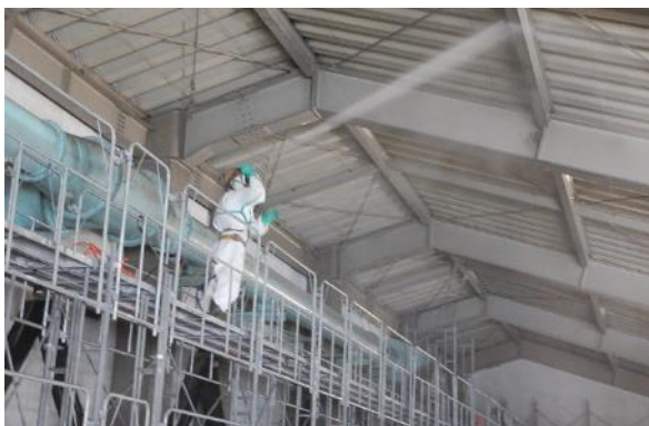
ピット屋根除染作業中
