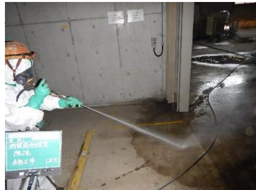
高圧洗浄による除染作業中
