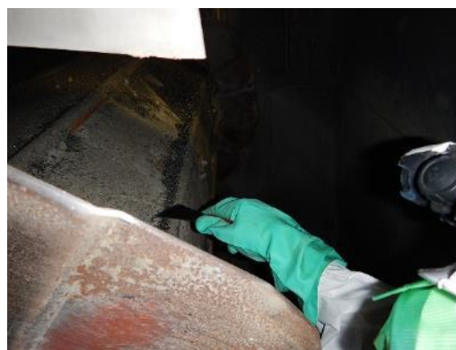
手作業による除去作業中
