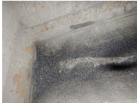
コンベヤ下除去・除染作業前
