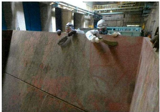
ブラシによる除去・除染作業中 (H29. 7. 29 内側を撮影)
