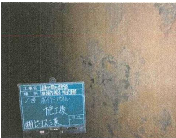
除去・除染作業後 (ボイラ点検口より撮影)
