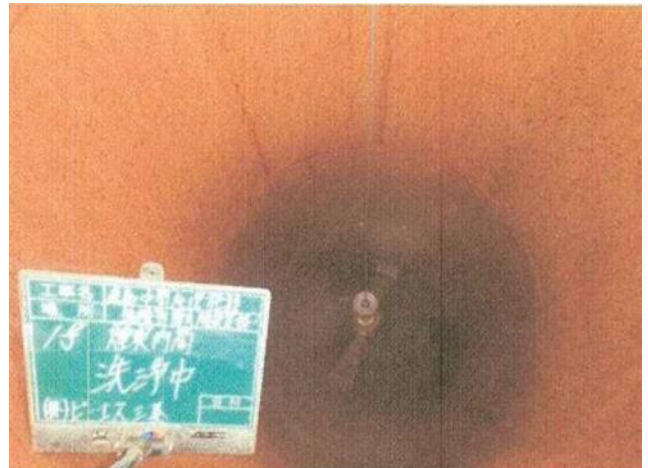
高圧洗浄による除去・除染作業中 (上から煙突内を撮影)
