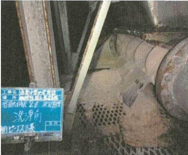
除去・除染作業前 (飛灰計量槽コンベヤを撮影)
