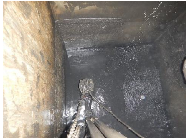
地下排水ピット除去・除染作業前
