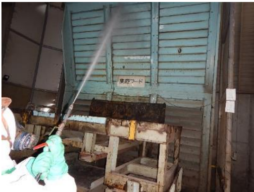
高圧洗浄による除染作業中
