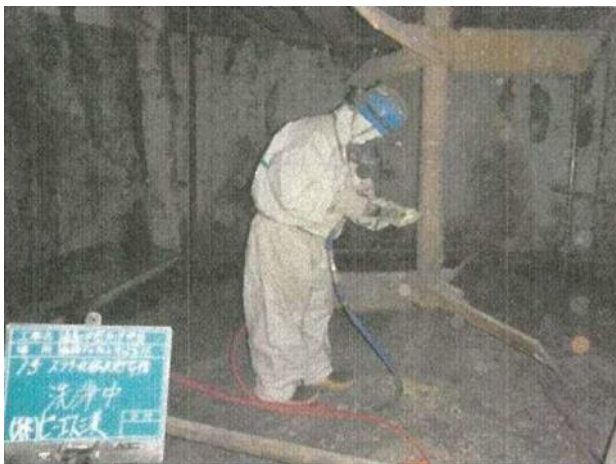
高圧洗浄による除去・除染作業中 (飛灰貯留槽内部を撮影)
