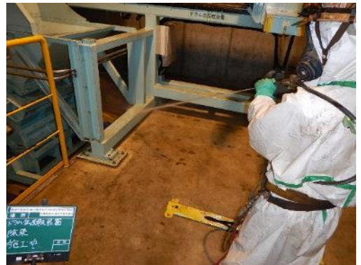
高圧洗浄による除染作業中
