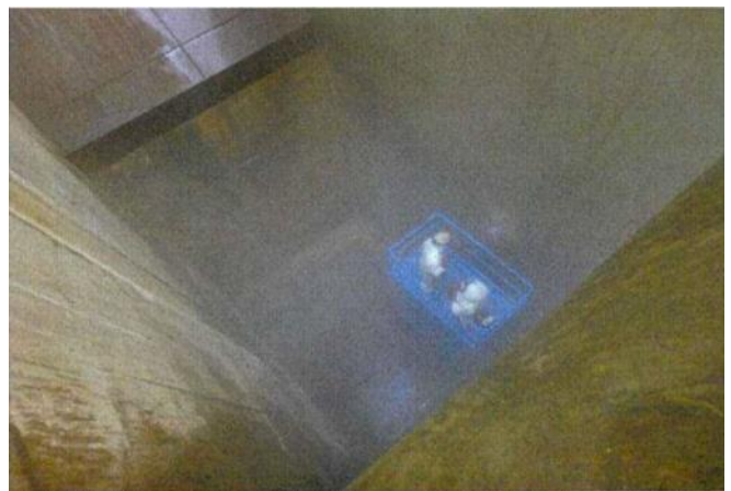
高圧洗浄による側面除去・除染作業中 (上から撮影)
