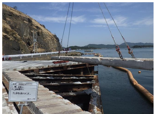
PC床板撤去状況
