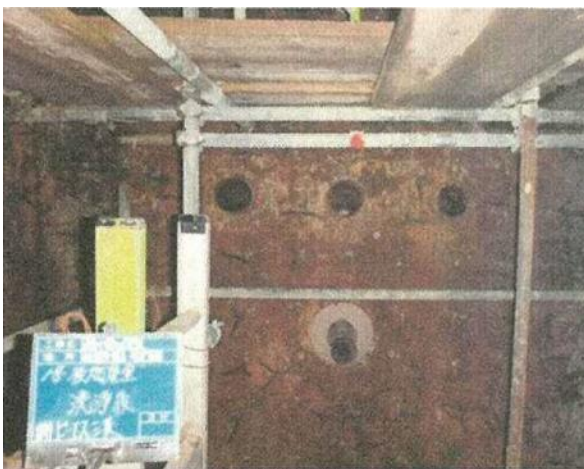
除去・除染作業後 (後燃焼室内部を撮影)
