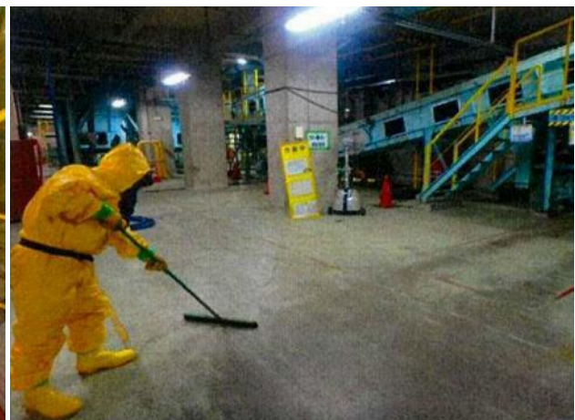
手作業による除去・除染作業中
