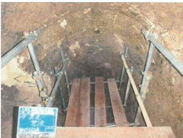
除去・除染作業後 (煙道内部を撮影)
