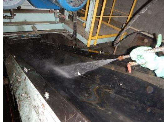
高圧洗浄によるコンベヤ除染作業中
