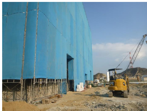
建屋等改修工事中（外壁等改修工事中） 南西側から撮影
