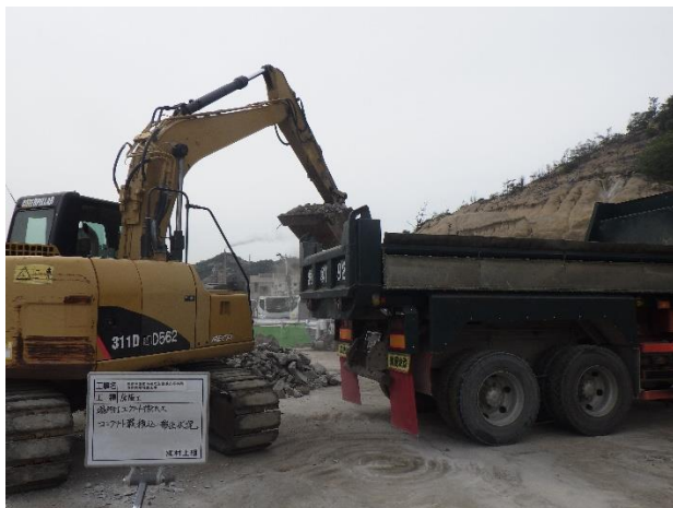
PC床板コンクリートガラ搬出
