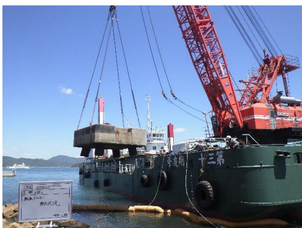
ドルフィン撤去の状況
