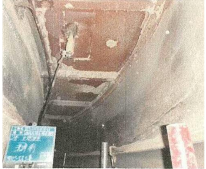
除去・除染作業前 (溶融炉内部を撮影)
