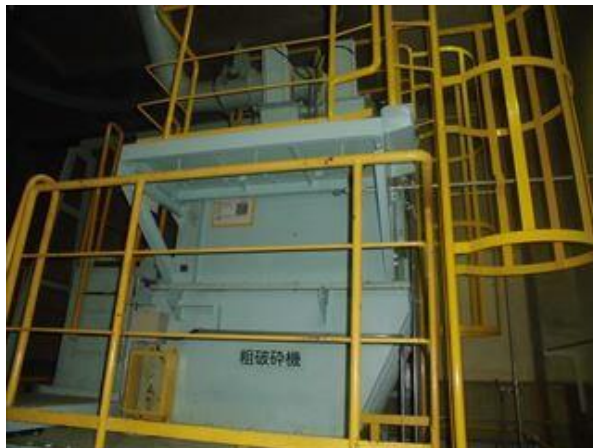
粗破砕機解体作業前 (1階から南方向に撮影)
