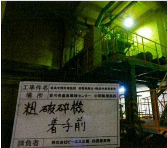
除去・除染作業前 (1階から北東方向に撮影)
