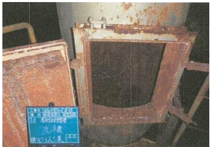
除去・除染作業後 (飛灰計量槽点検口を撮影)
