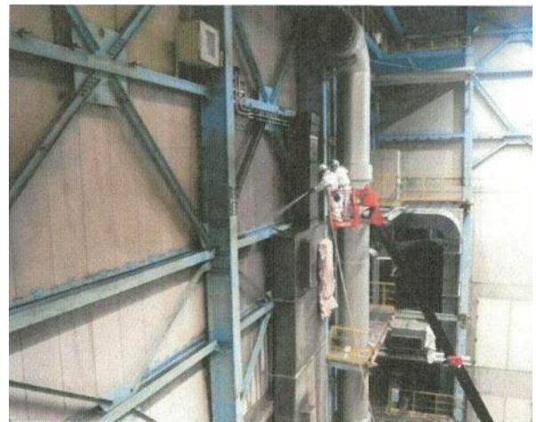
高圧洗浄による除去・除染作業中 (南棟北東壁付近を撮影)
