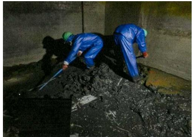
手作業による除去・除染作業中 (汚水貯留槽内を撮影)
