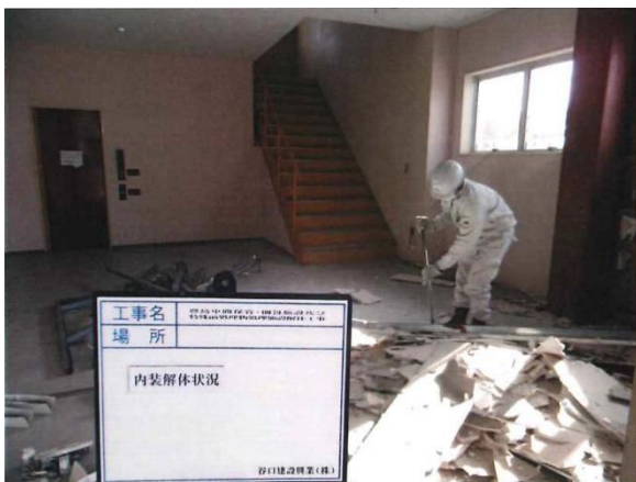
1階玄関ホール付近内装解体中 (西側から撮影)
