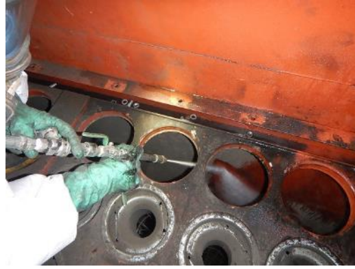
高圧洗浄による集塵機内除染作業中
