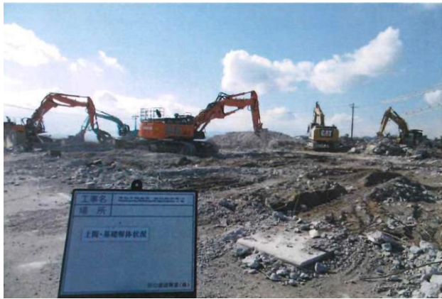
土間解体の状況 (北東側から撮影)
