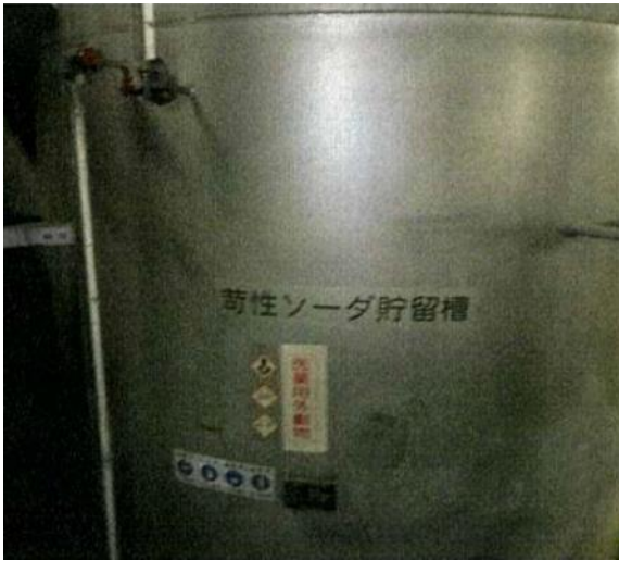
除去・除染作業前 (苛性ソーダ貯留槽外観を撮影)
