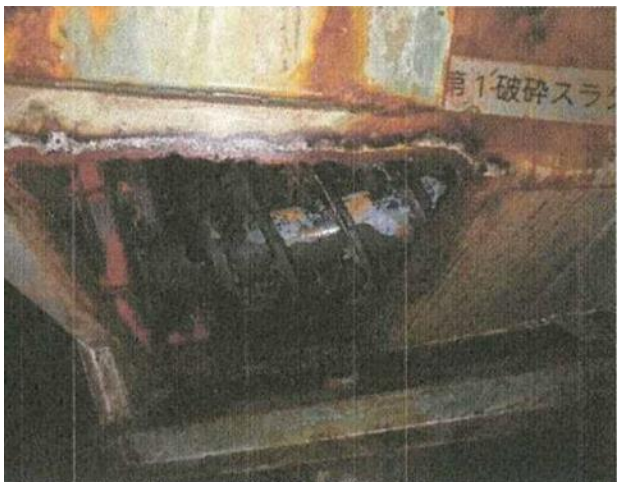
除去・除染作業後 (第1 破碎スラグコンベヤを撮影)
