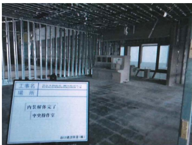
中央操作室付近内装解体後 （南東方向から撮影）
