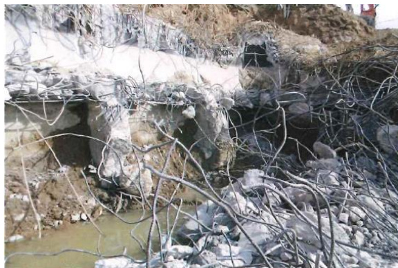
基礎・地中梁解体の状況 (南側から撮影)
