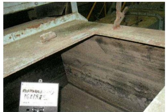
除去・除染作業後 (点検口から内部を撮影)
