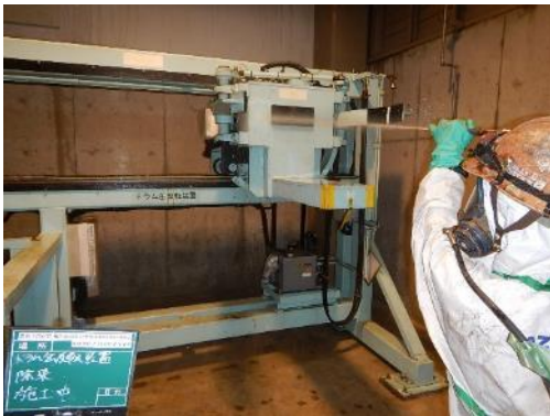
高圧洗浄による除染作業中
