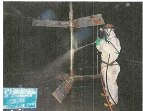
高圧洗浄による除去・除染作業中 (飛灰貯留槽内部を撮影)
