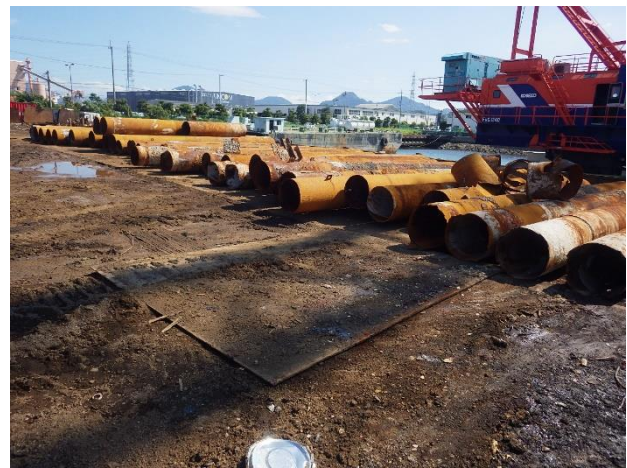
鋼管杭 荷下し後
