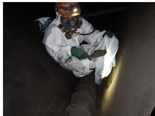
吸引による集塵機内除去作業中 レベル3 保護具使用
