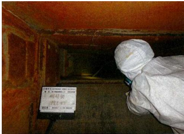
手作業による研り除去・除染作業中 (破碎機内部を撮影)
