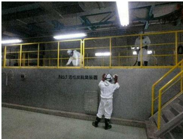
ウエス等による除去・除染作業中
