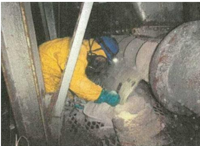
手作業による除去・除染作業中 (レベル3 保護具着用飛灰計量槽コンベヤを撮影)
