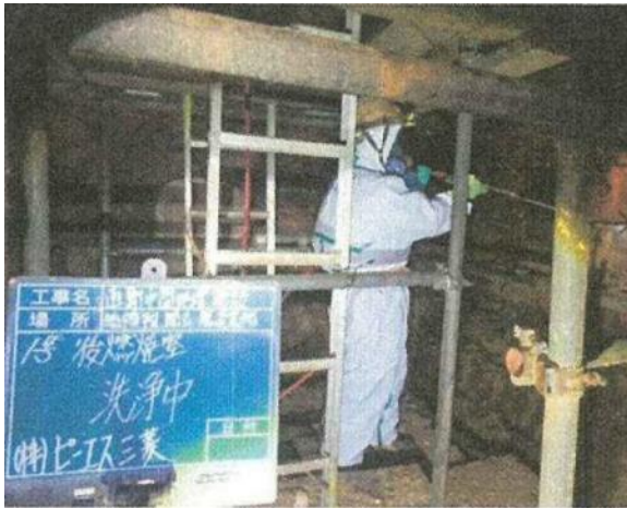
高圧洗浄による除去・除染作業中 (後燃焼室内部を撮影)
