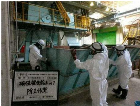
ブラシによる除去・除染作業中 (横からホッパを撮影)
