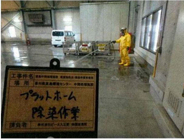
高圧洗浄による除去・除染作業中 (プラットホームを北向き撮影)
