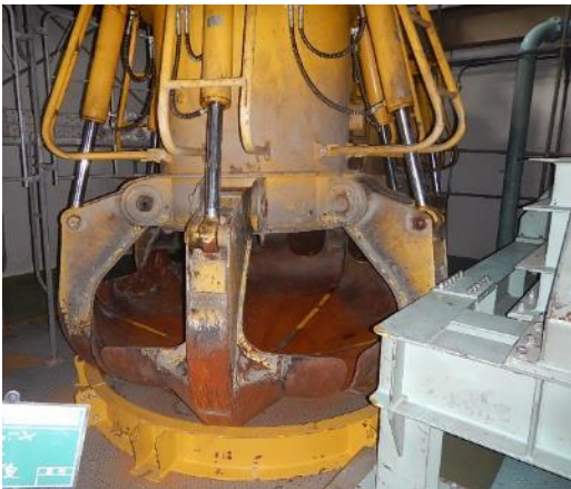
除去・除染作業後
