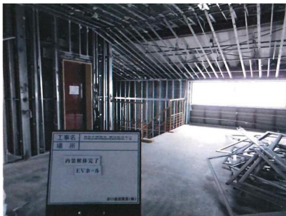
2階エレベータホール付近内装解体後 (北側から撮影)
