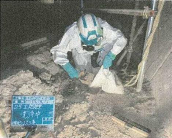
手作業による除去・除染作業中 (溶融炉内部を撮影)
