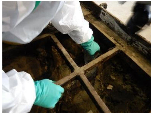
手作業による除去作業中
