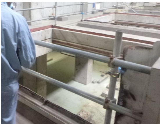
供給ホッパ解体作業後 (転落防止用単管手摺り設置)
