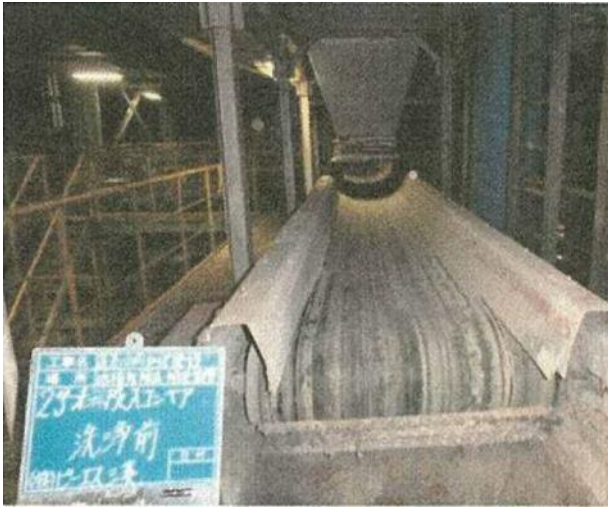
除去・除染作業前 (投入コンベヤを撮影)
