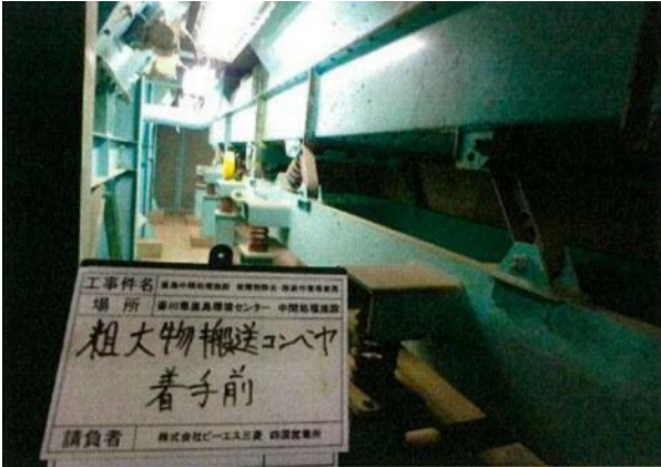
除去・除染作業前 (コンベヤ外装を撮影)
