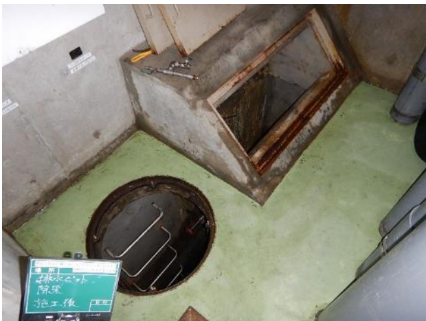
地下ピット作業終了後
