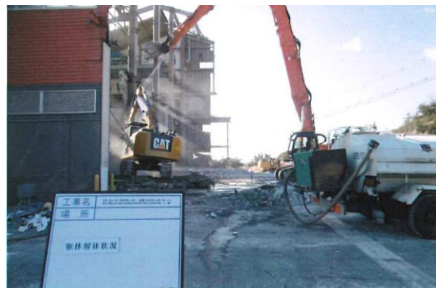
投入前室付近解体中（東側から撮影）
