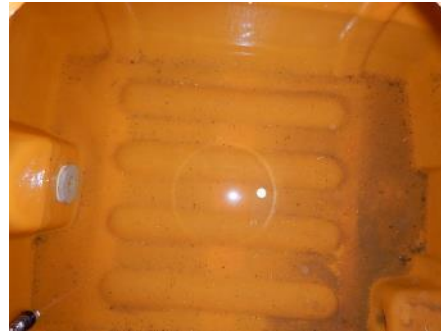
薬剤抜き取り前（タンク内部を撮影）
