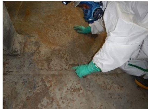
手作業による除去作業中
