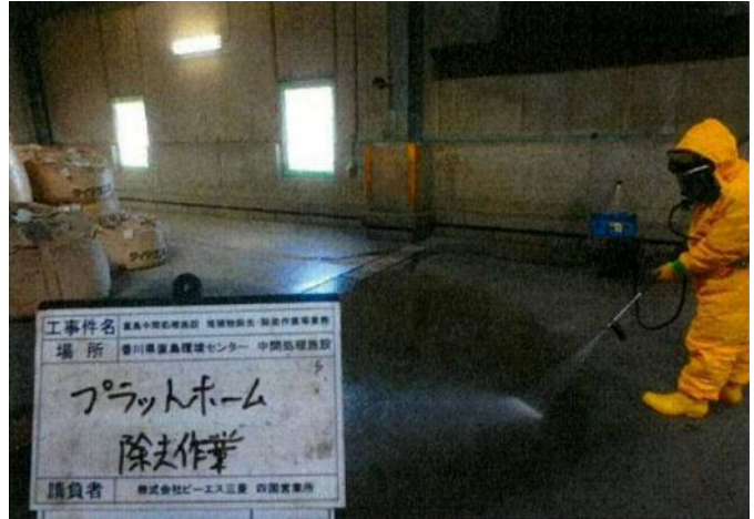
高圧洗浄による除去・除染作業中 (プラットホーム洗車スペース前を撮影)
