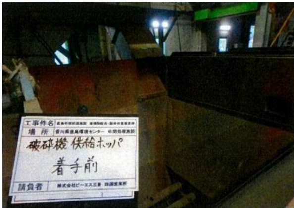
除去・除染作業前 (横からホッパを撮影)
