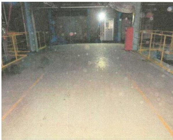
除去・除染作業後 (2階フロアを西向きに撮影)
