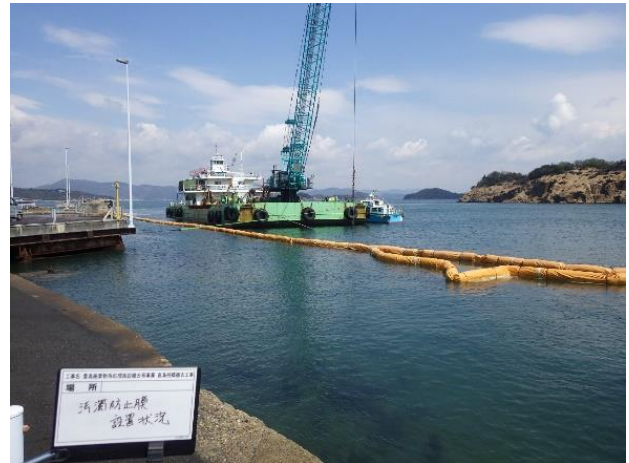
汚濁防止膜設置状況
