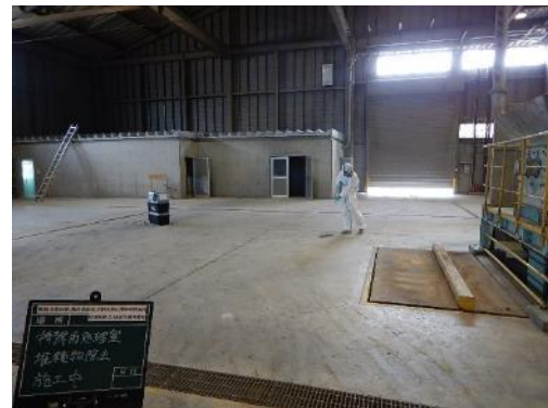
手作業による殊前処理室除去作業中 (東向きに撮影)
