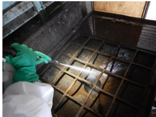
高圧洗浄による除染作業中
