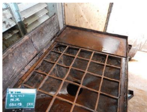
高圧洗浄による除染作業中
