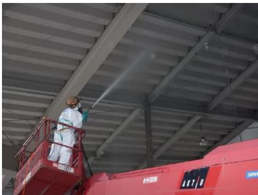
高所作業車による天井除染作業中
