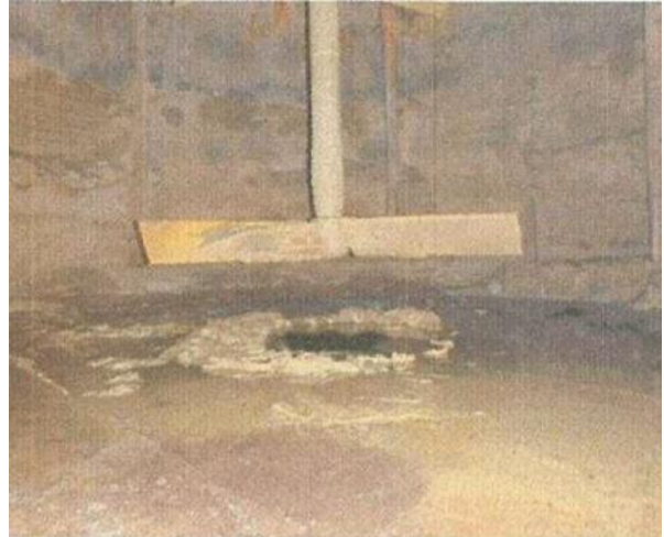
除去・除染作業前 (飛灰貯留槽内部を撮影)
