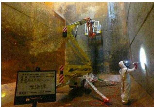
吸引装置による底面付近除去・除染作業中 (底面付近から撮影)
