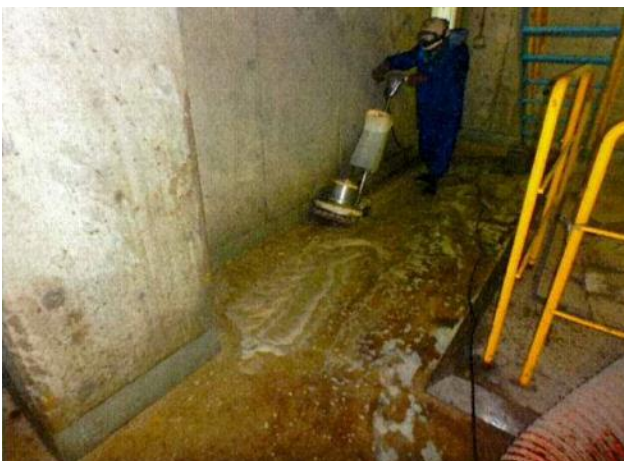
床除去・除染作業中
