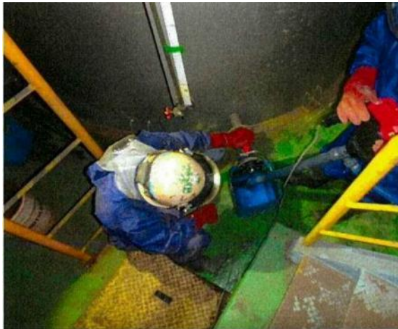
手作業による除去作業中 (苛性ソーダ貯留槽付近を撮影)
