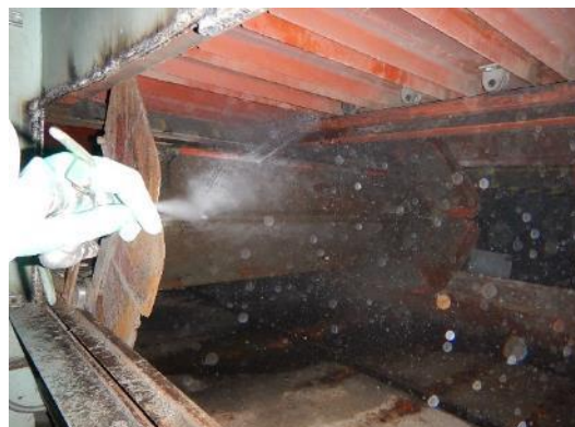
高圧洗浄による除染作業中
