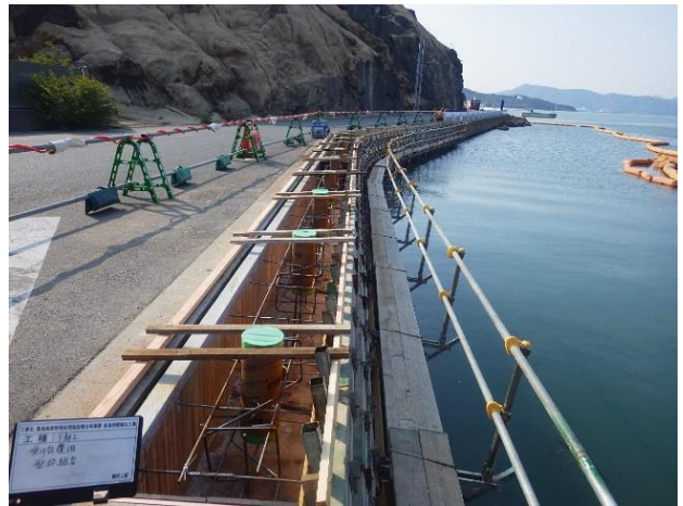
受け台復旧 型枠組立
