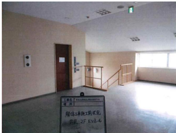
2階エレベータホール付近内装解体前 (北側から撮影)
