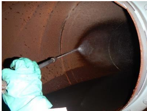
高圧洗浄による配管内除染作業中
