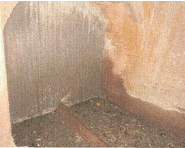
除去・除染作業前 (投入プレッシャー内部を撮影)
