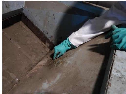
手作業による除去作業中
