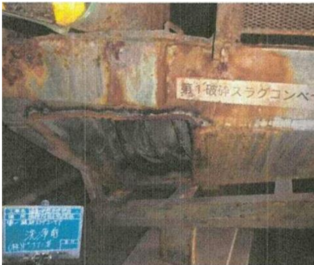
除去・除染作業前 (第1 破碎スラグコンベヤを撮影)
