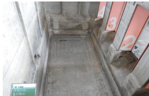
ピット底面除去・除染作業後(西から撮影)
