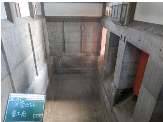
ピット除去・除染作業前(西から撮影)
