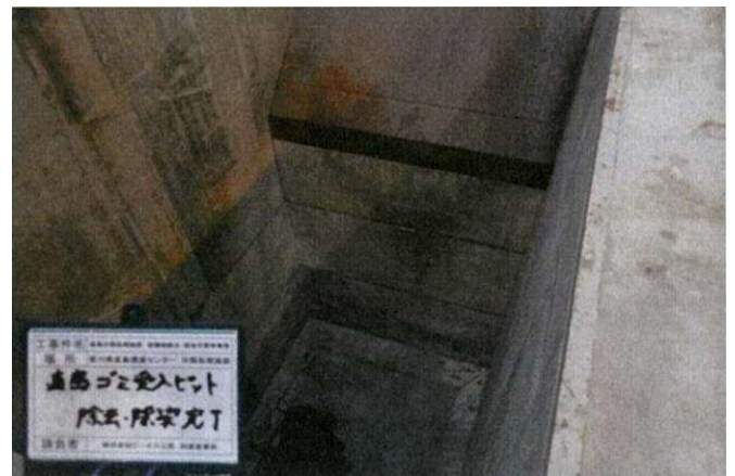
高圧洗浄による側面除去・除染作業中 (上から撮影)
