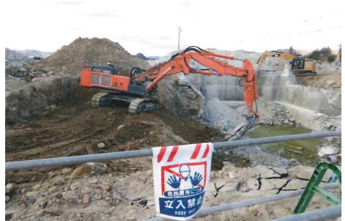
基礎・地中梁解体の状況 (東側から撮影)
