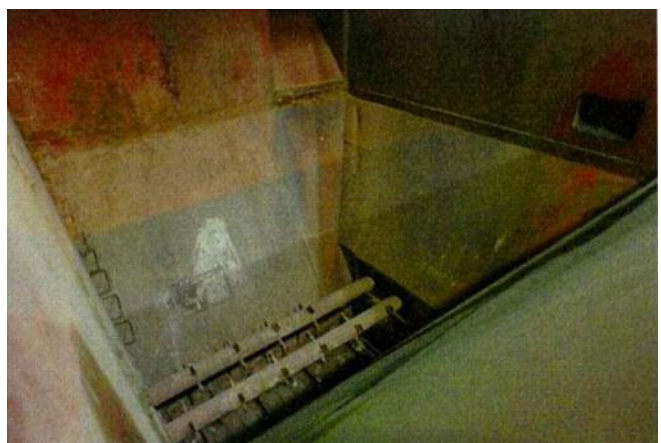
除去・除染作業後 (上からホッパを撮影)
