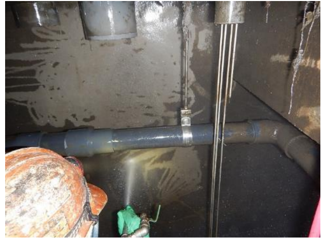
高圧洗浄による地下ピット内除染作業中
