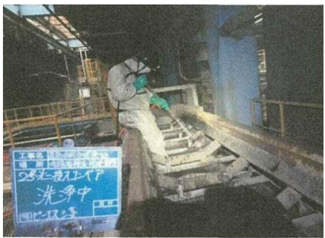
高圧洗浄による除去・除染作業中 (投入コンベヤを撮影)
