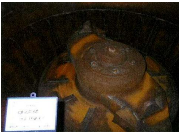
除去・除染作業後 (上から破碎機内部を撮影)
