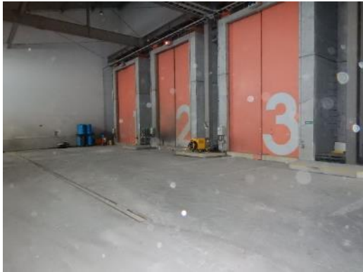
除去・除染作業前（北西方向に撮影）
