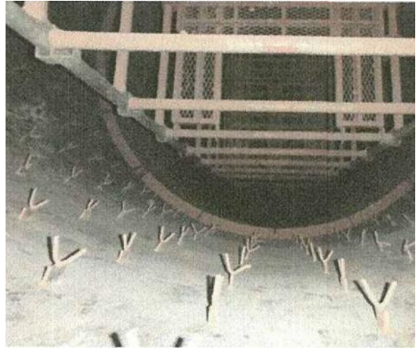
除去・除染作業前 (キルンガス冷却室内部を撮影)
