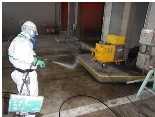
高圧洗浄による床面除染作業中
