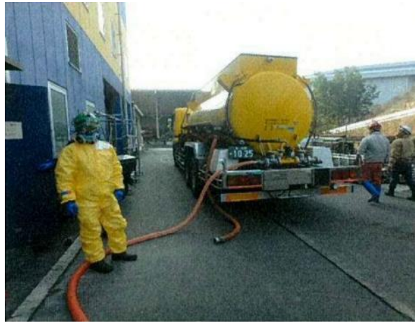
バキュームによる除去作業中 (化学防護服着用中間処理施設西側を南方向に撮影)
