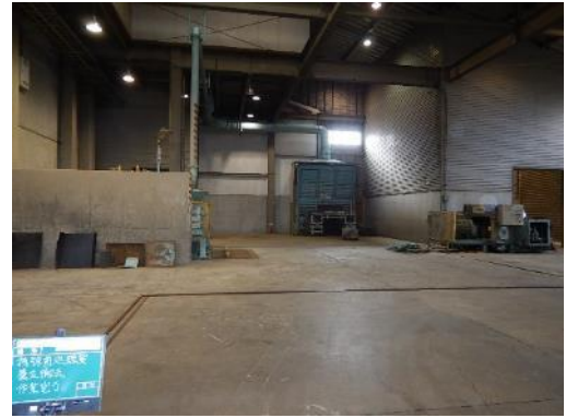
除去・除染作業後
