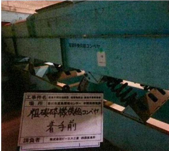
除去・除染作業前 (コンベヤ外装を撮影)
