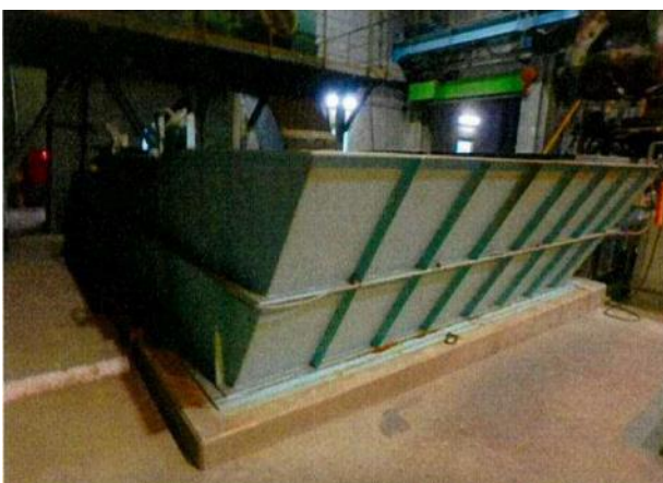
除去・除染作業後 (横からホッパを撮影)
