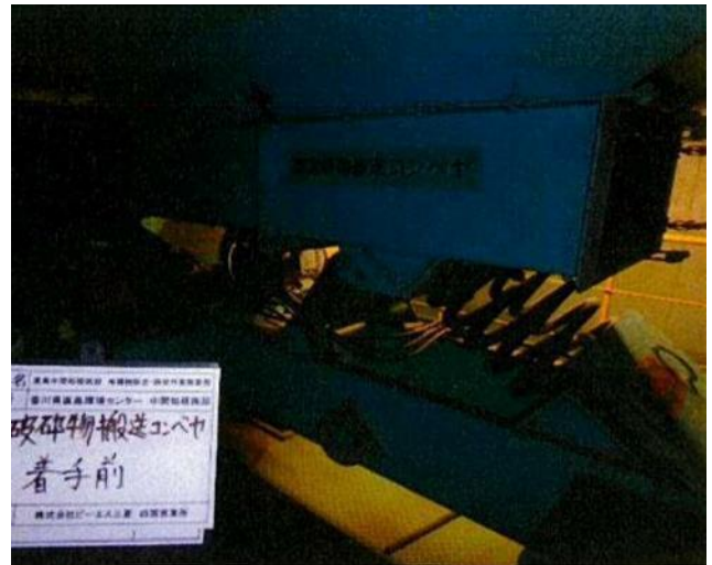
除去・除染作業前 (コンベヤ外装を撮影)
