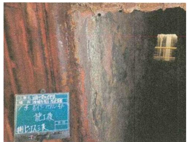
除去・除染作業後 (4階ボイラ点検口より撮影)
