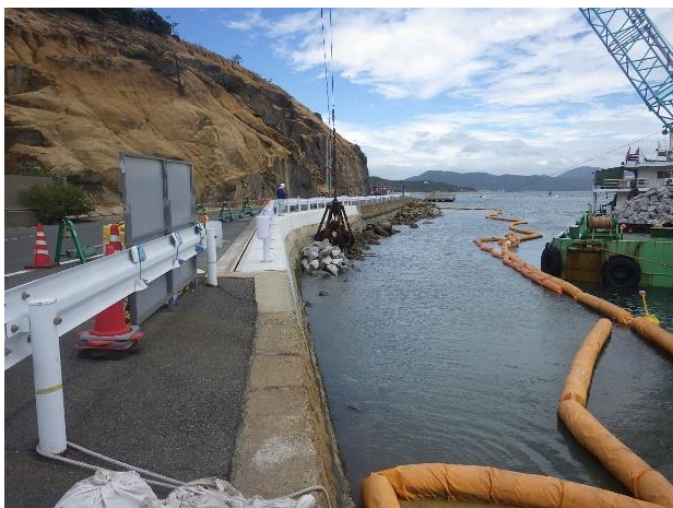
捨て石設置作業中
