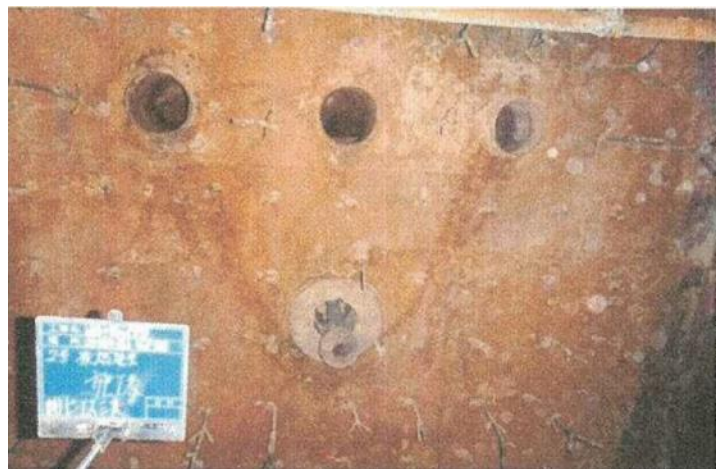
除去・除染作業後 (後燃焼室内部を撮影)
