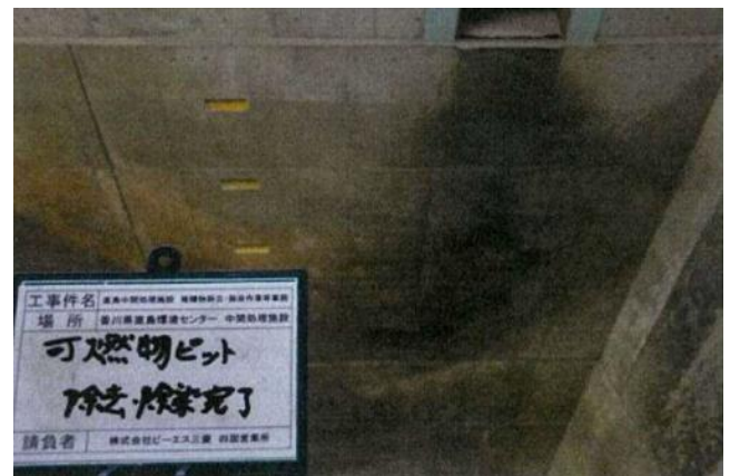
研り作業による底面除去・除染作業中 (上から底面を撮影)
