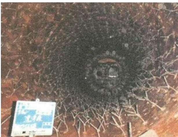
除去・除染作業後 (ロータリーキルン内部を撮影)
