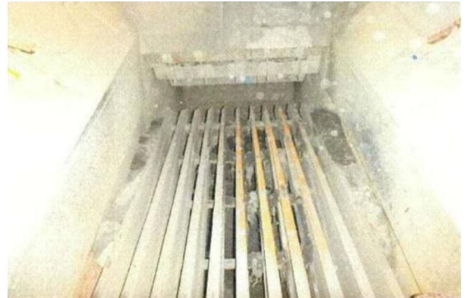
除去・除染作業前 (上からグリズリを撮影)
