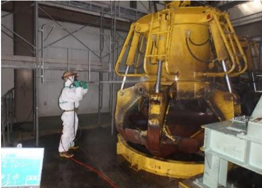
高圧洗浄による除染作業中
