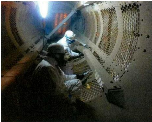
手作業による除去・除染作業中 (グリズリ内部撮影)
