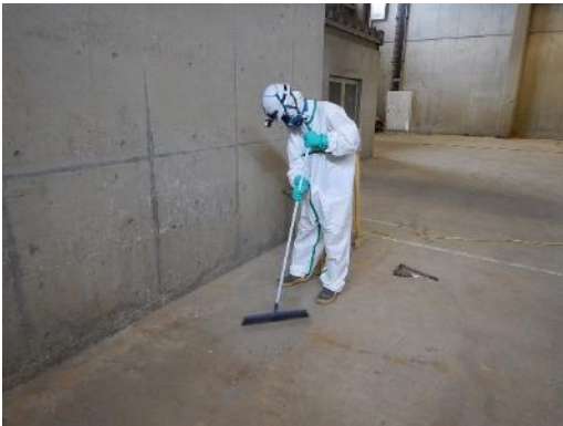
手作業による除去作業中
