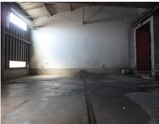
除去・除染作業後（西向きに撮影）
