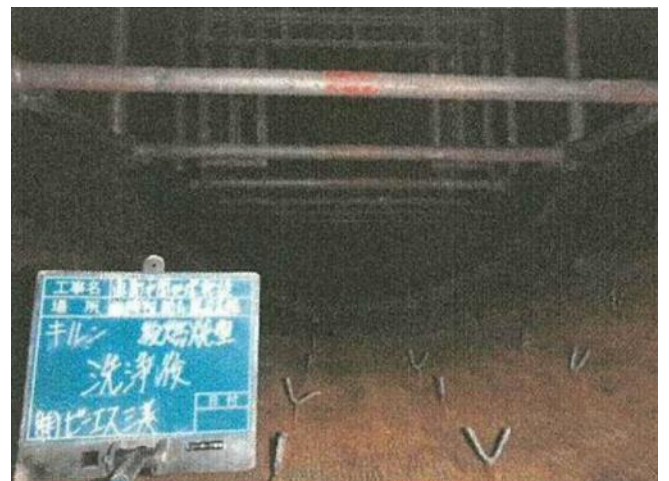
除去・除染作業後 (キルンガス冷却室内部を撮影)
