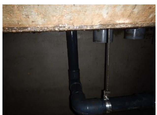
地下ピット作業終了後
