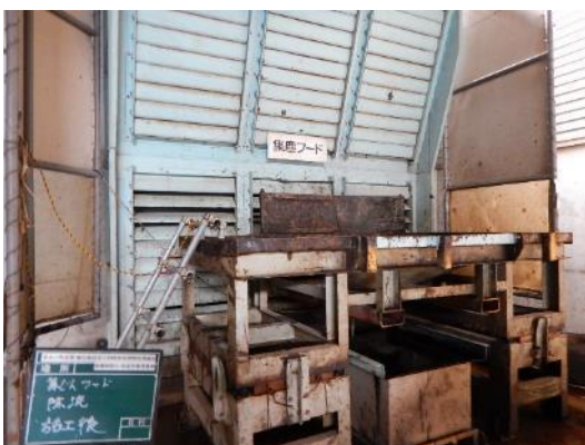
除去・除染作業後
