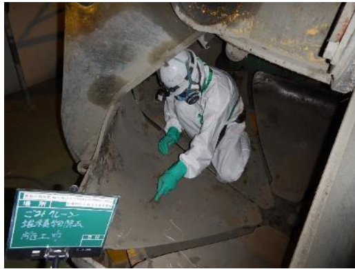
手作業による除去作業中
