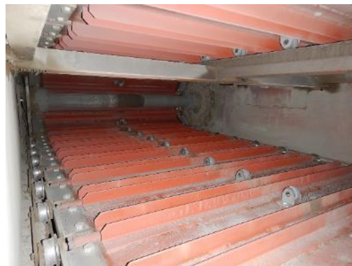
切出しコンベヤ内部除去・除染作業前
