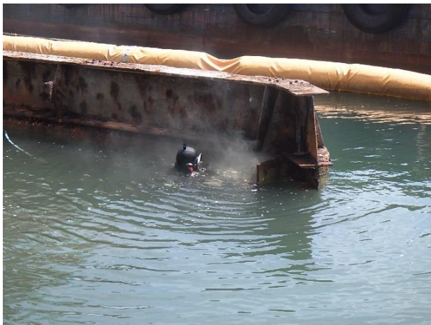
カーテンウォール溶断状況
