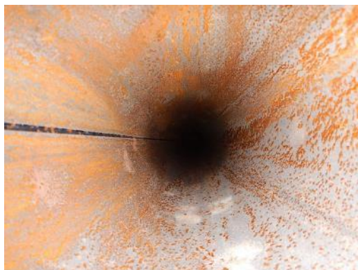
配管内作業終了後
