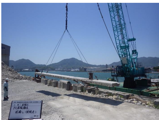
PC床板撤去 荷下し
