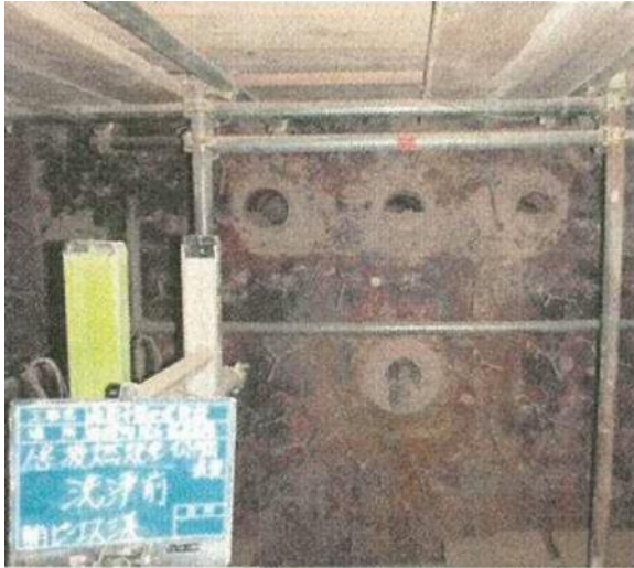
除去・除染作業前 (後燃焼室内部を撮影)
