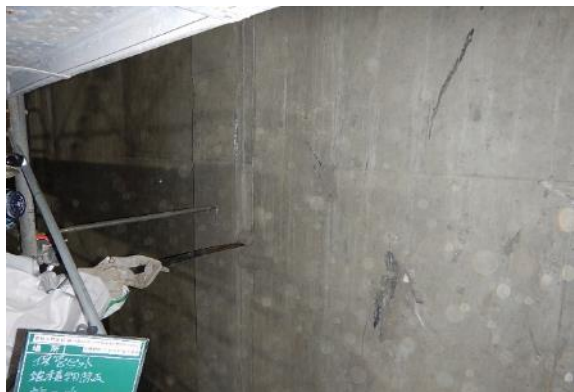
壁面除去作業中
