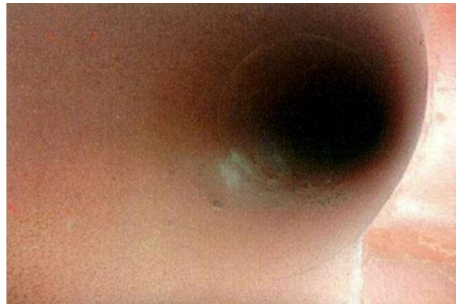
吸引による除去・除染作業後 (サイクロン配管内部を撮影)
