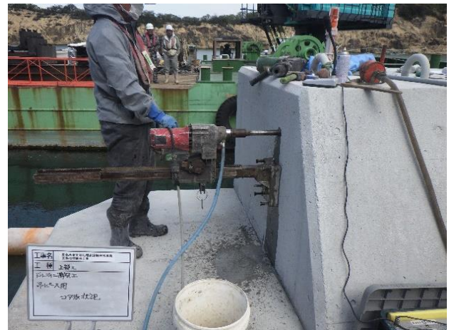
吊りピース用コア抜状況
