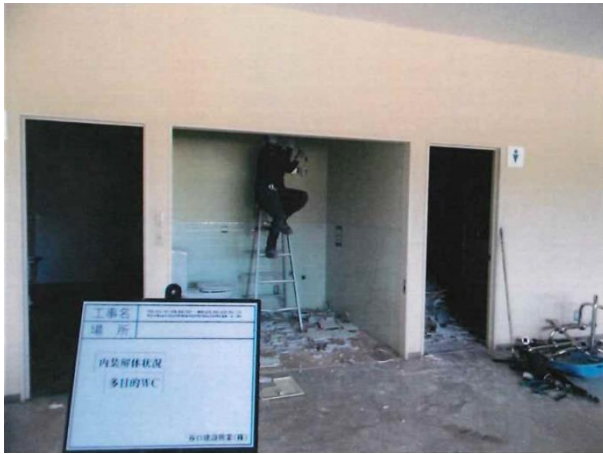
トイレ付近内装解体中 (東方向から撮影)
