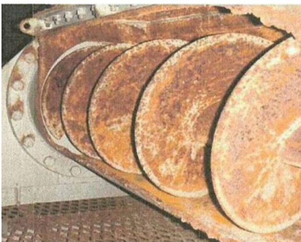
除去・除染作業後 (飛灰計量槽コンベヤを撮影)
