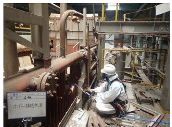
ボイラーガス溶断作業中 (レベル3保護具着用)
