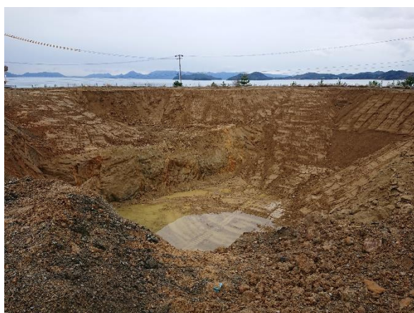
解体撤去完了後 (東側から撮影)
