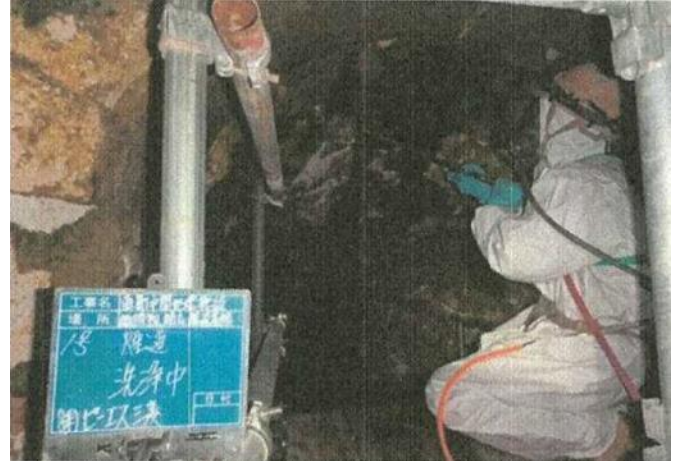
高圧洗浄による除去・除染作業中 (煙道内部を撮影)
