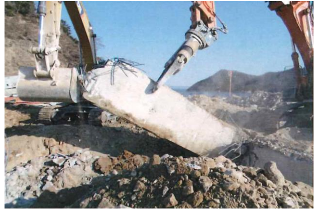
基礎・地中梁解体の状況 (南西側から撮影)
