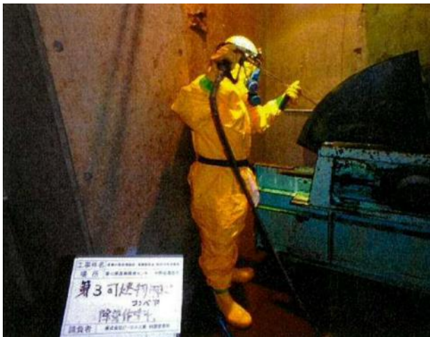
吸引による除去・除染作業中 (末端部点検口を撮影)
