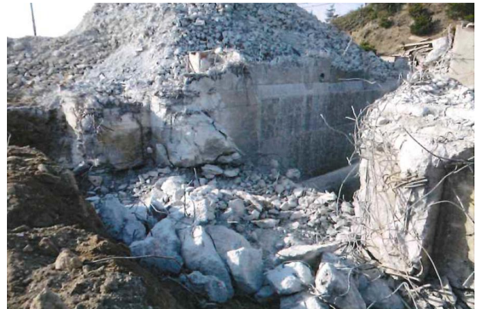
地中梁及びピット壁の解体の状況 (東側から撮影)
