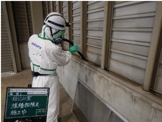
入口付近除去作業中
