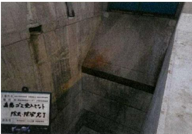
研り作業による底面除去・除染作業中 (上から撮影)
