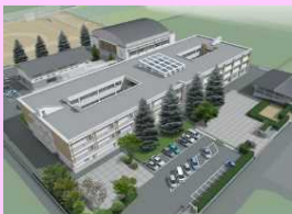
笠田高校校舎棟第1期改築工事(R4竣工)
