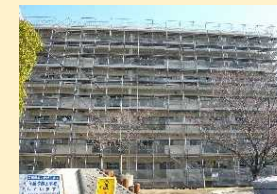
県営住宅の外壁改修工事
