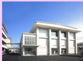
高松商業高校南体育館改築工事(R3竣工)
