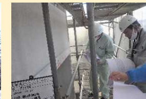
建築職員による工事中の現地検査
