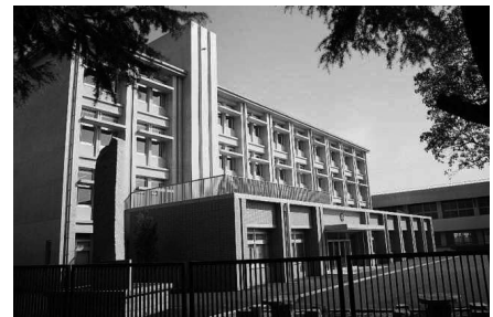
平成 26 年 10 月新校舎完成
