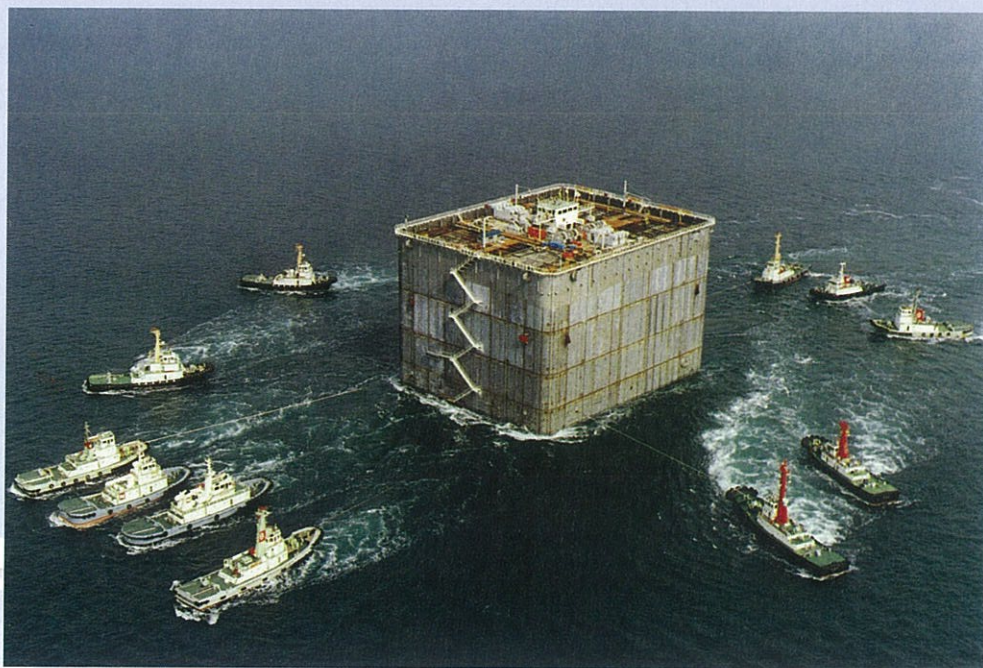
南備讃瀬戸大橋の7Aケーソン『瀬戸大橋の基礎』（本州四国連絡橋公団 海洋架橋調査会）
