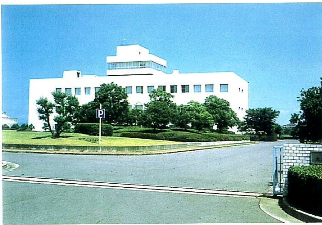
大東川浄化センター
