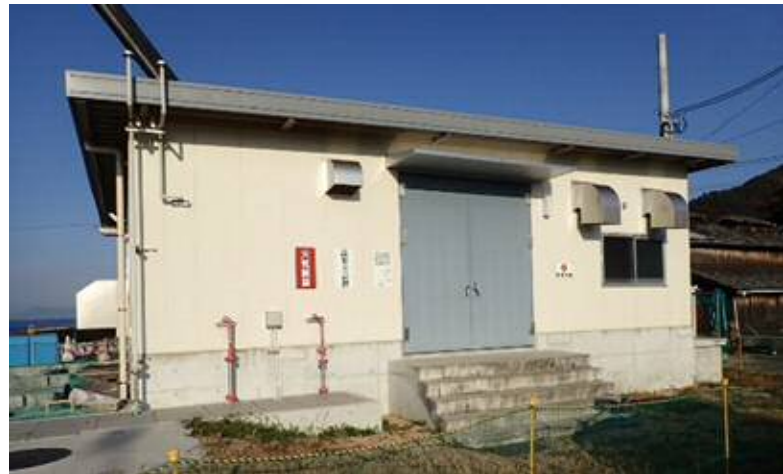
土庄町 湊崎都市下水路 大谷ポンプ場
